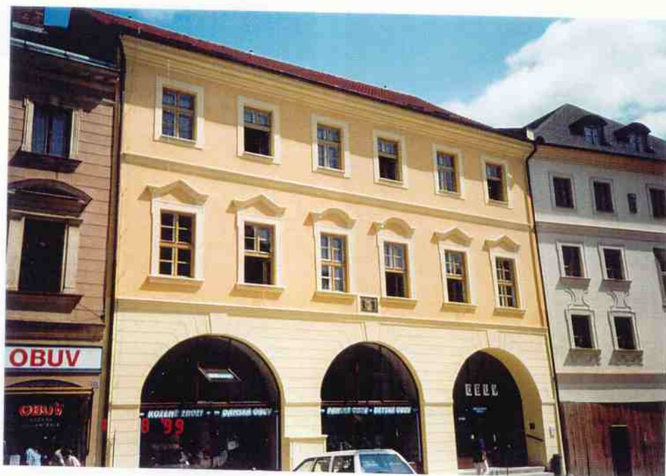
Čelní pohledy před a po obnově fasády
