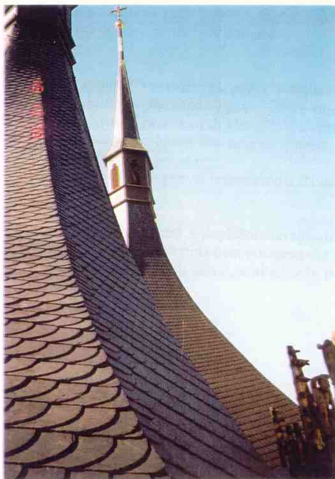
Chrám sv. Panny Barbory dokončená obnova hlavních střech
