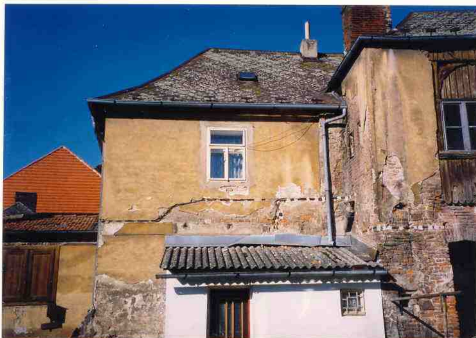
Stav objektu čp. 373 před rekonstrukcí
