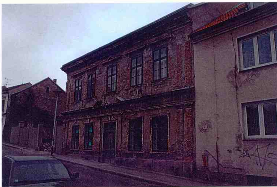
2.1. Dvoukřídlé vchodové dveře, Česká ulice č. p. 263, Kutná Hora Celkový pohled na objekt určený k opravě. Stav před provedením opravy.
