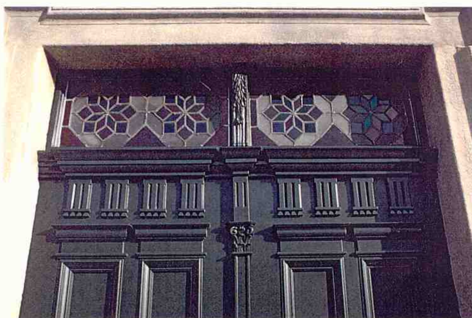
2.22. Dvoukřídlé vchodové dveře, Česká ulice č. p. 263, Kutná Hora Levé a pravé dveřní křídlo, horní část. Pohled z vnější strany. Stav po ukončení opravy.
