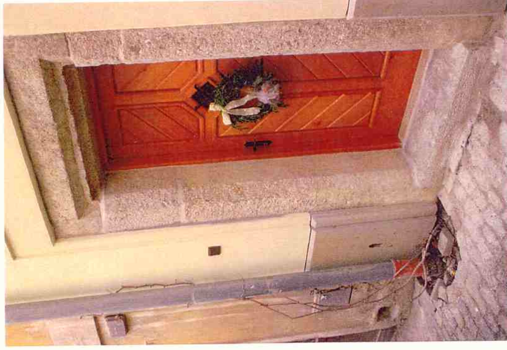
Stav po restaurování
