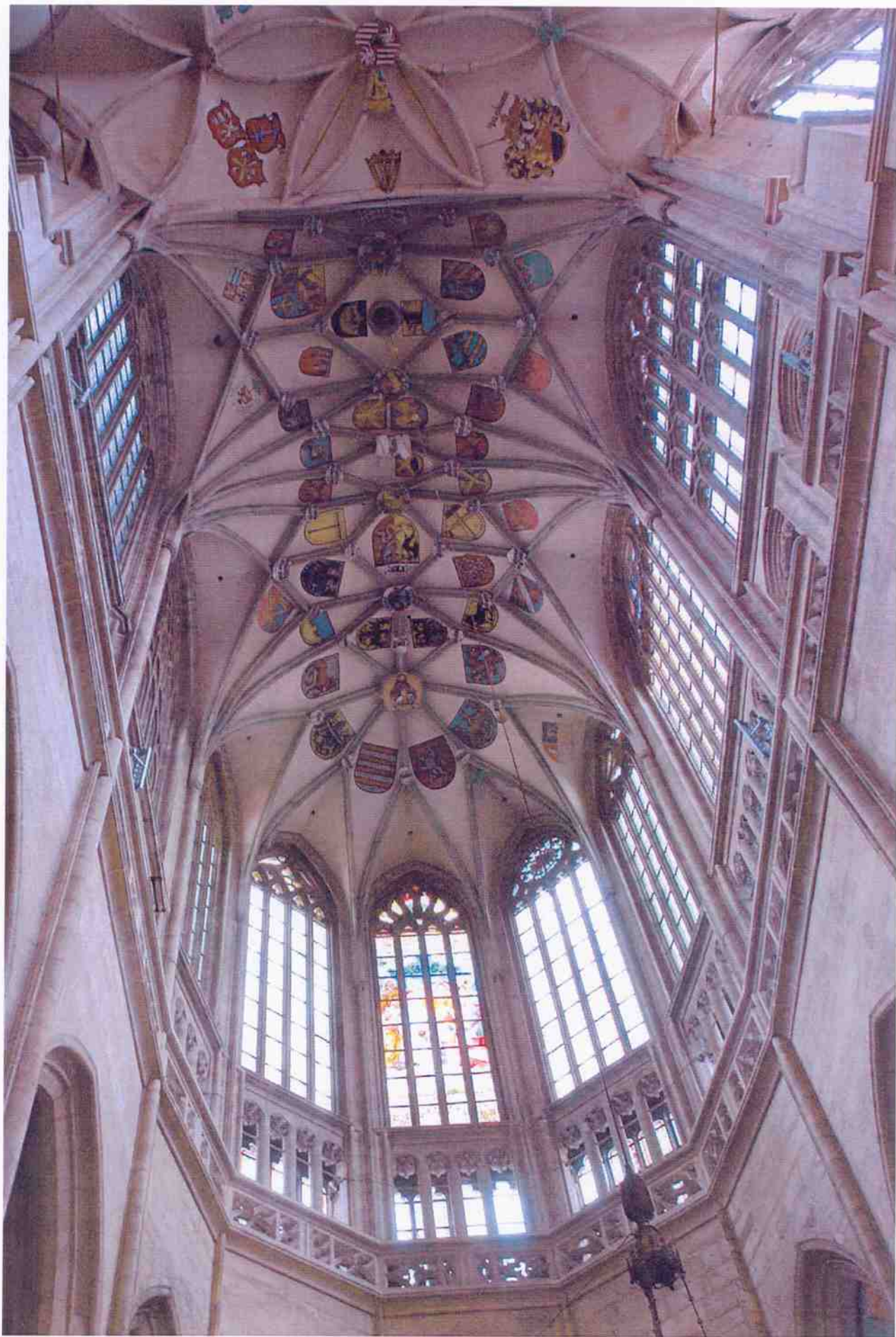
stav po dokončení prací
