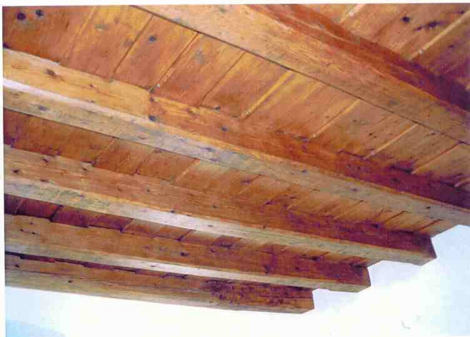
Celkový pohled na záklopový strop po zrestaurování.
