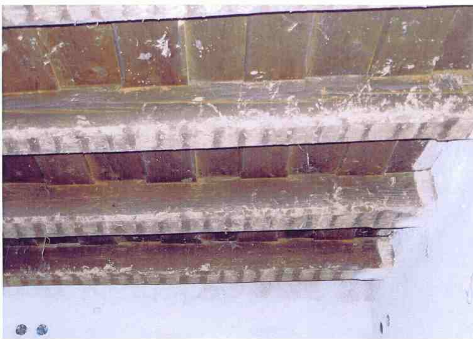
Záklopový strop po odstranění štukového podhledu – před restaurováním.
