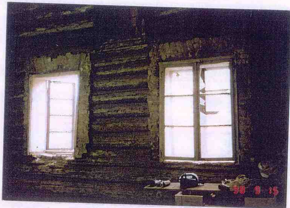
Původní stav zazděných oken jižní stěna
