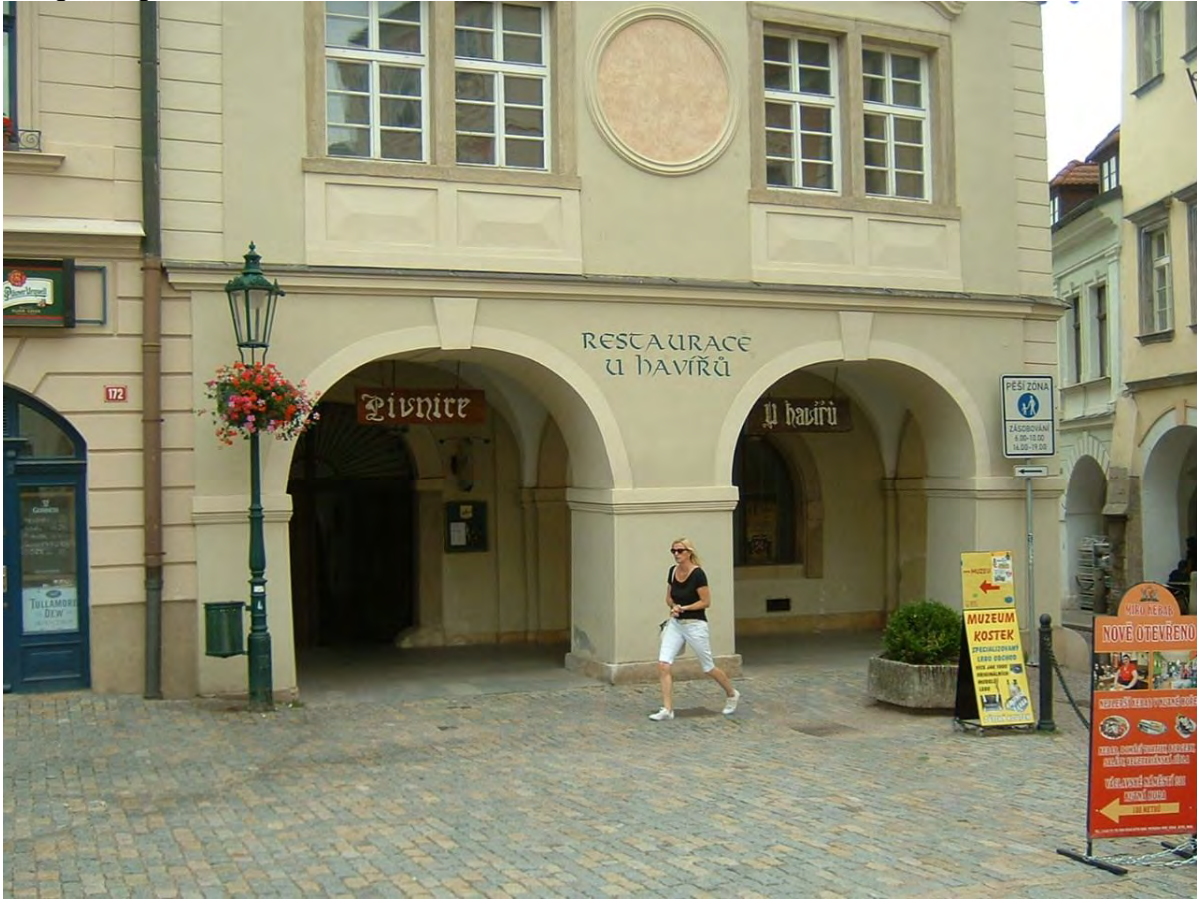
Stav před opravou
