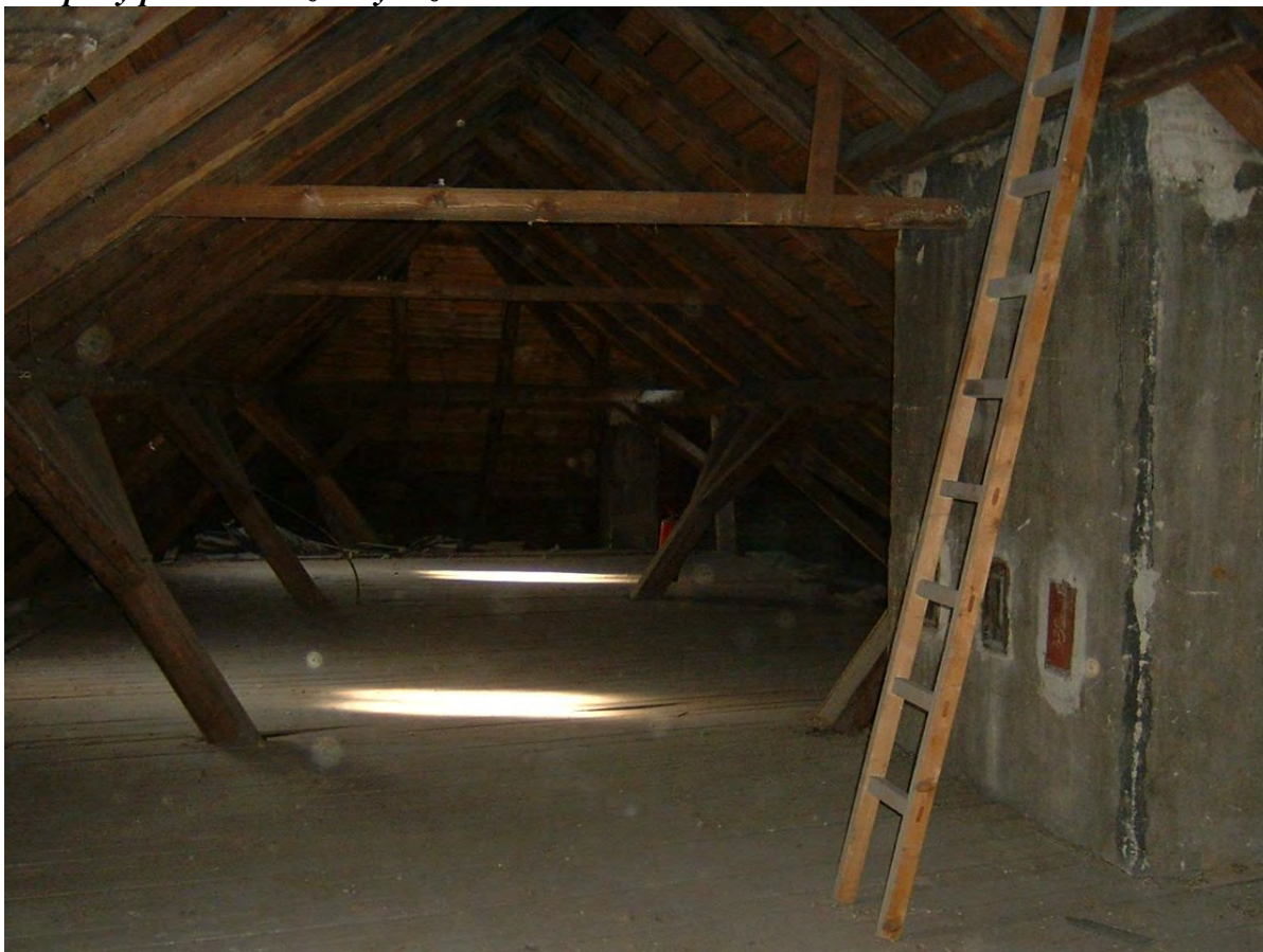
Stav půdy po demontáži a vyklizení
