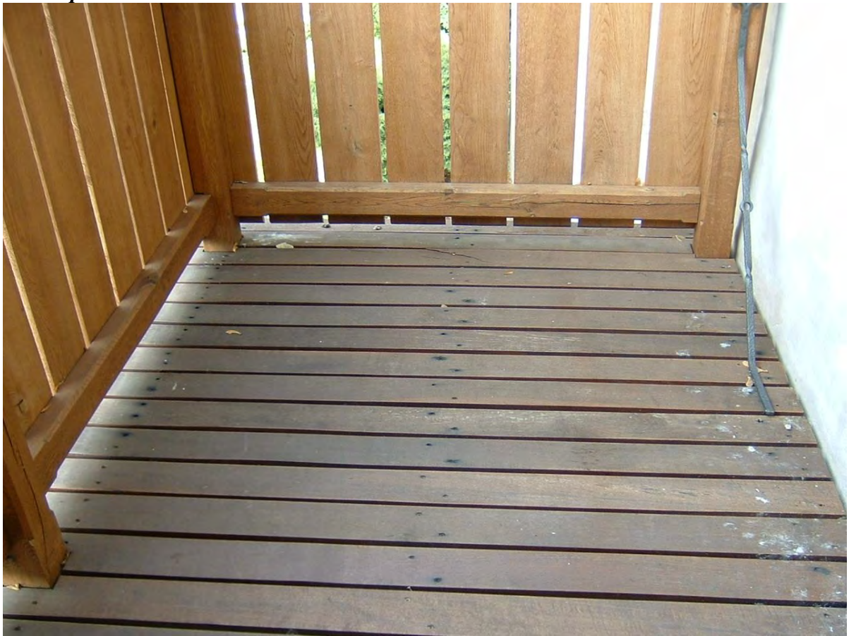
Balkón po nátěru dřevěné konstrukce
