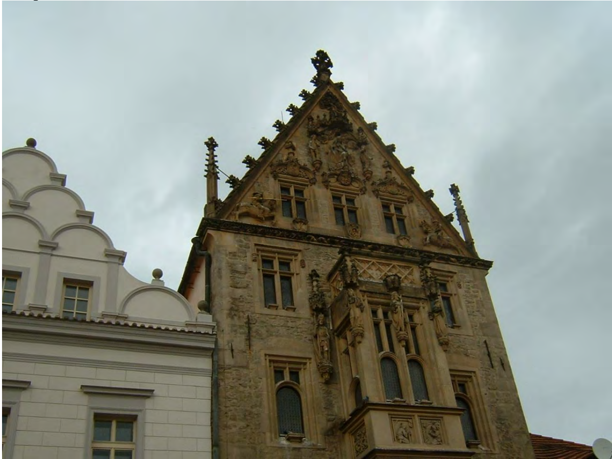
Stav před restaurováním
