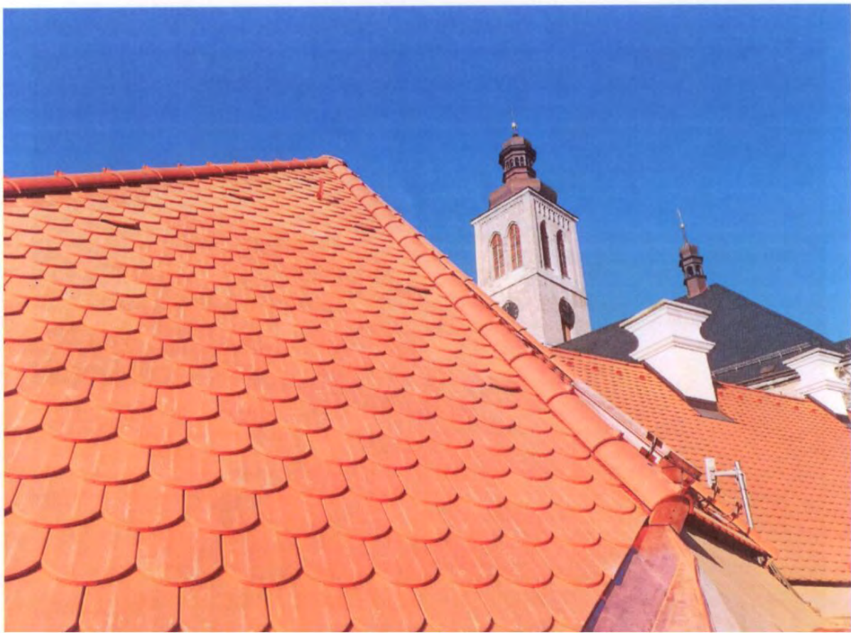
Stav po opravě
