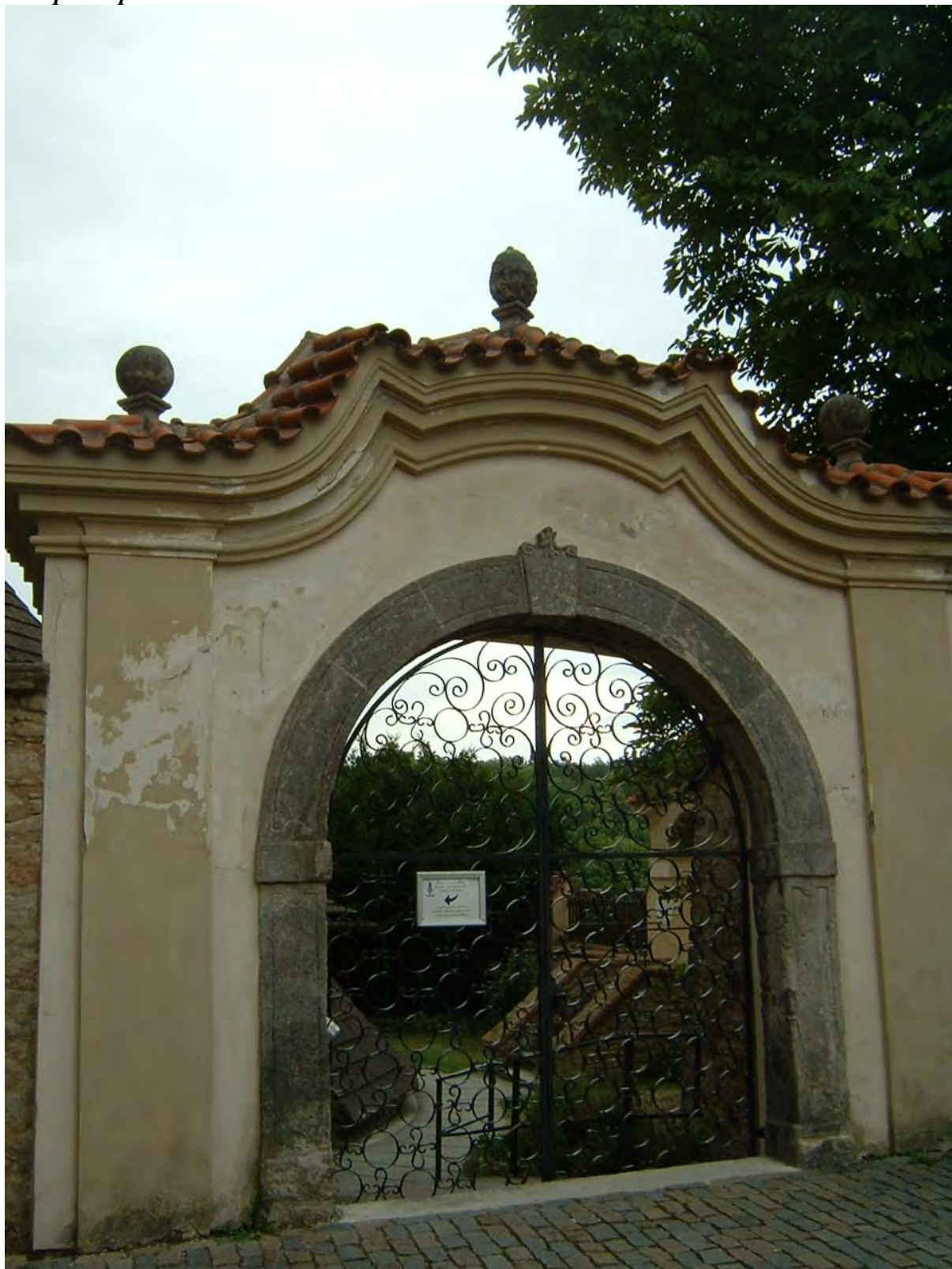
Stav před opravou
