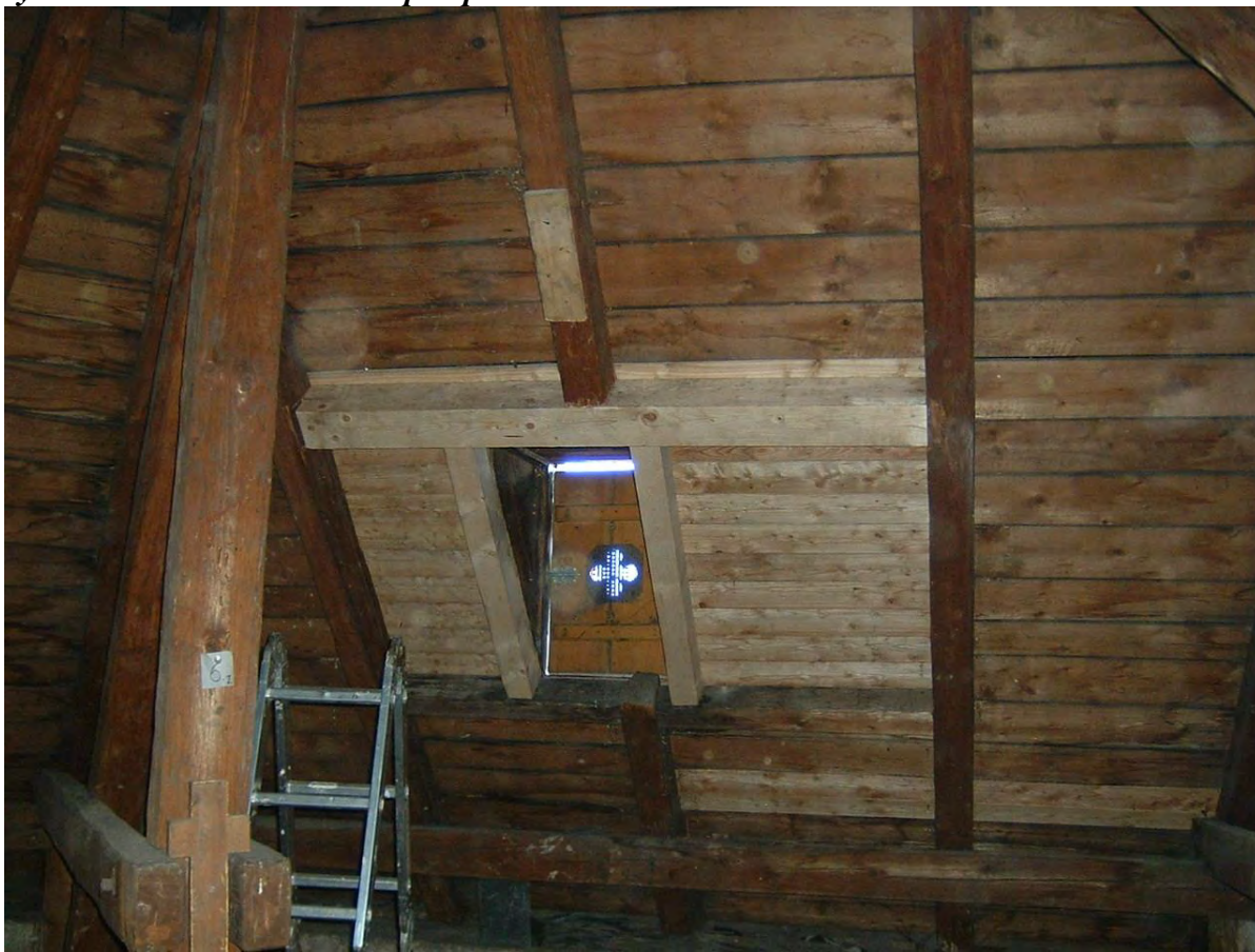
Východní křídlo – stav krovu po opravě
