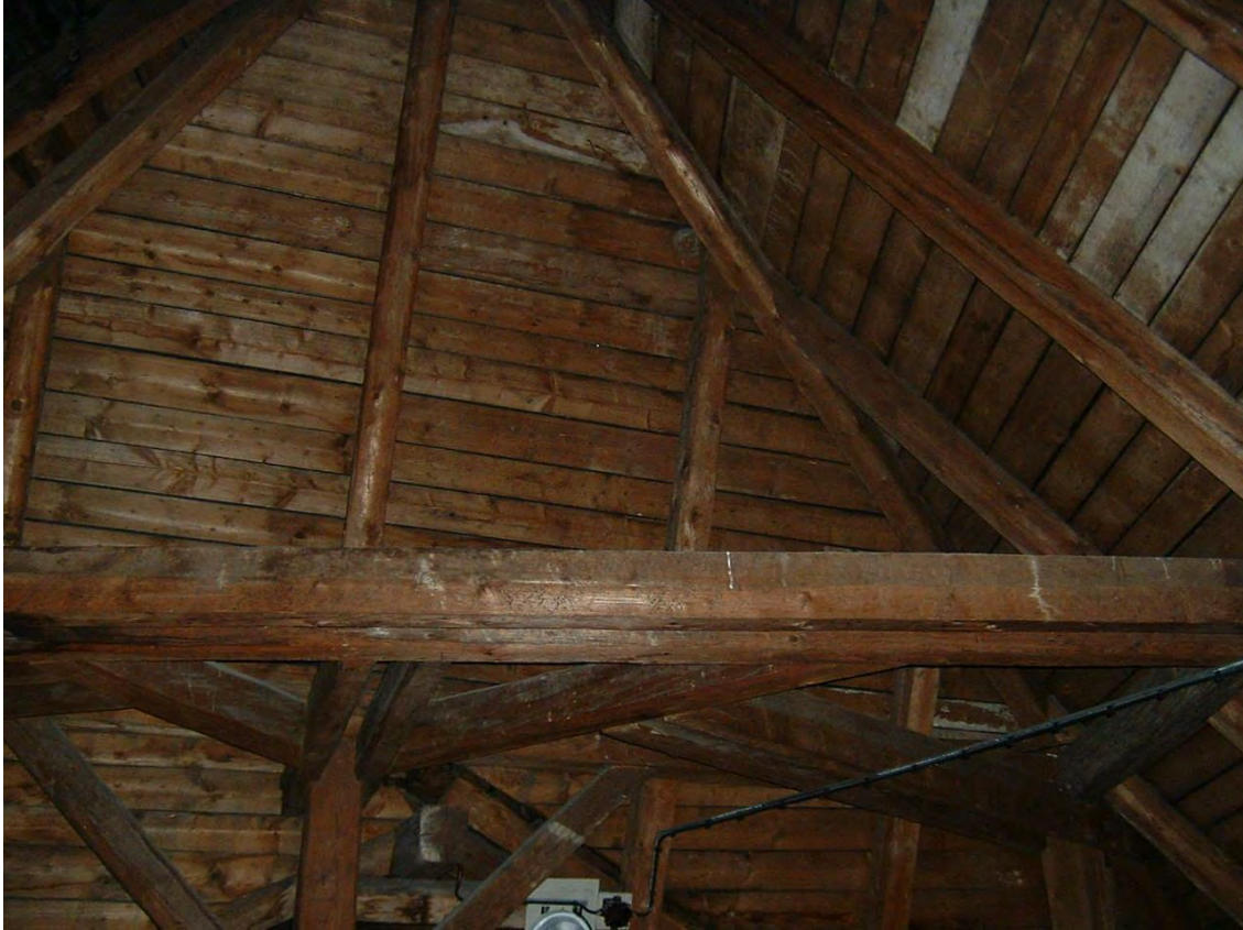
Východní křídlo – stav krovu před opravou
