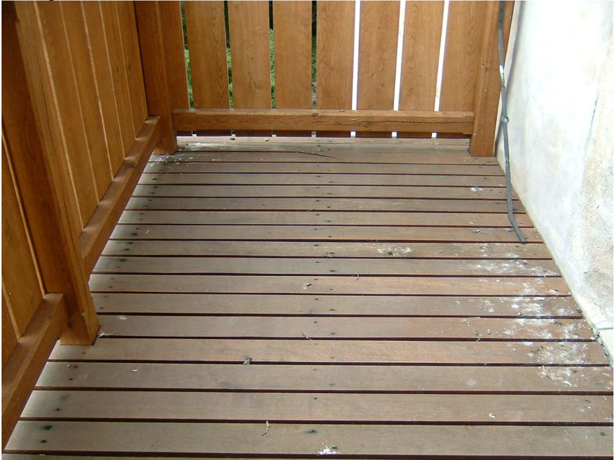
Balkón před nátěrem dřevěné konstrukce
