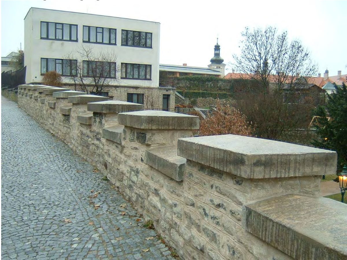
Stav části opěrné zdi po opravě
