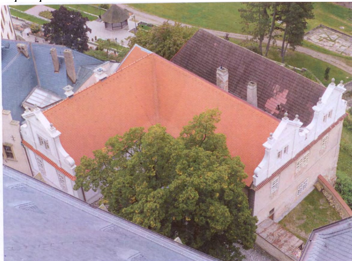
Stav před opravou
