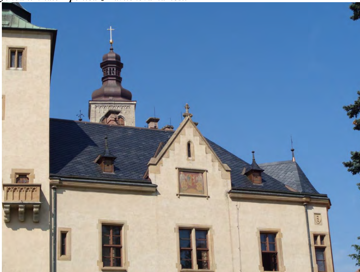
Stav po ukončení prací VI. etapy Východní křídlo – pohled z Havlíčkova náměstí
