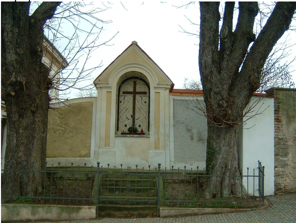
Stav po opravě omítek bez barevného nátěru
