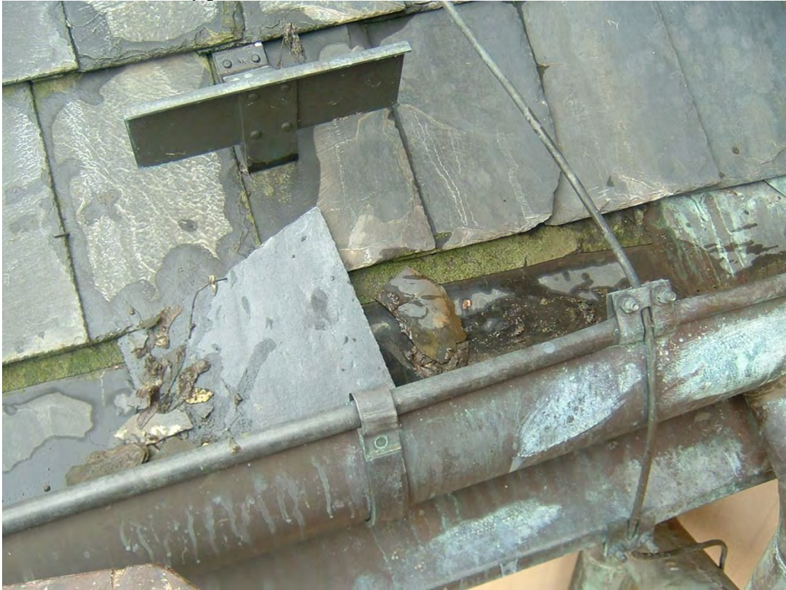
Východní křídlo – detaily poškození
