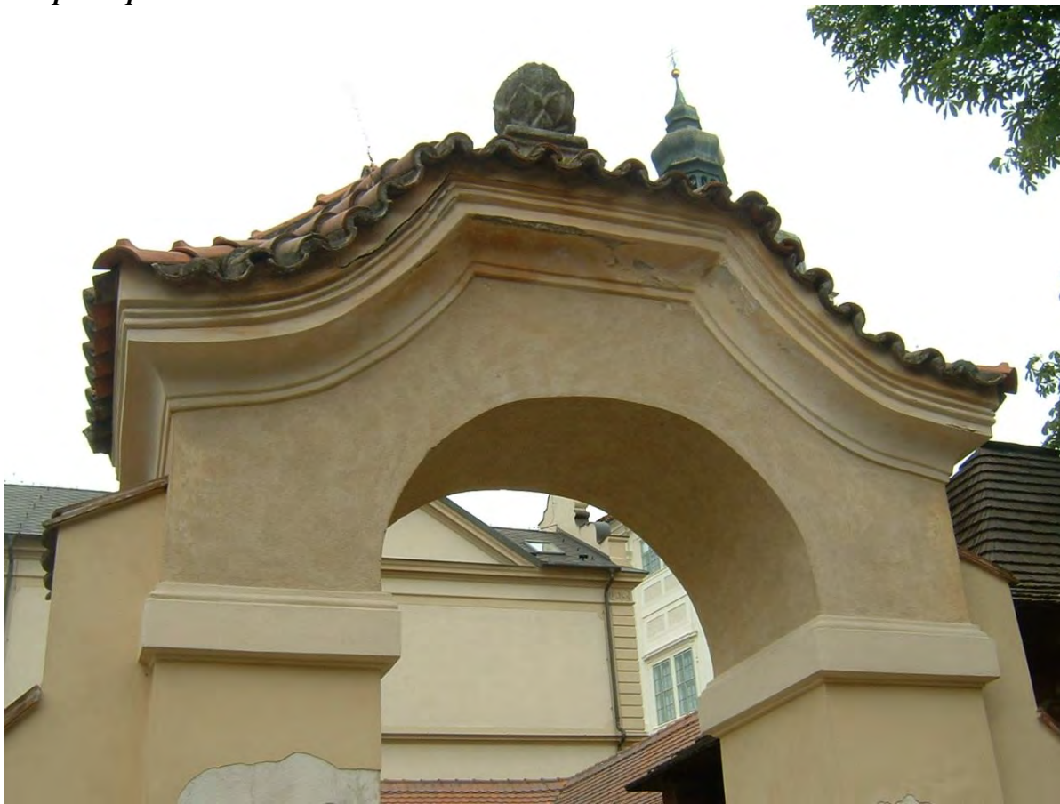
Stav před opravou
