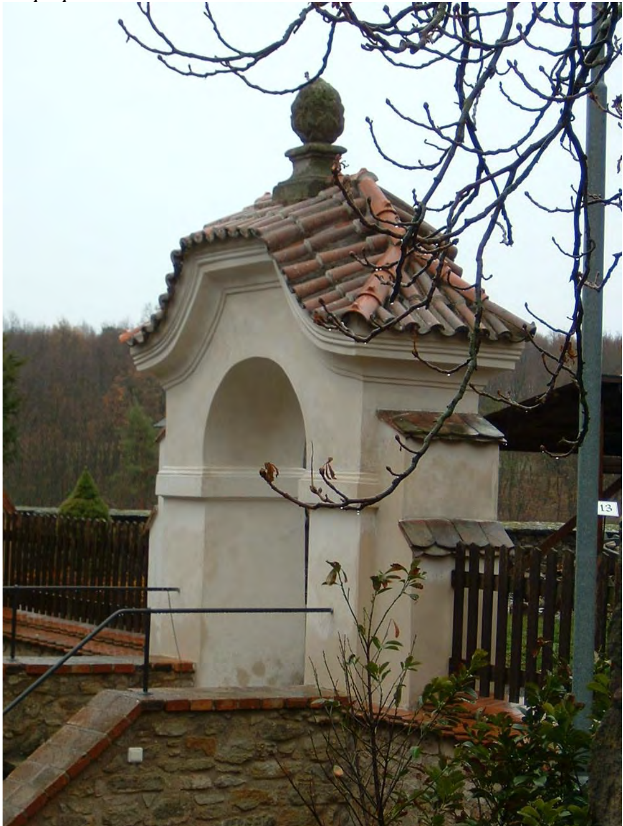
Stav po opravě omítek bez barevného nátěru
