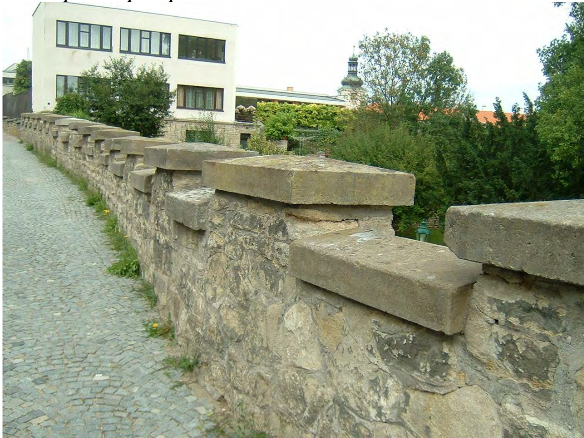
Stav části opěrné zdi před opravou
