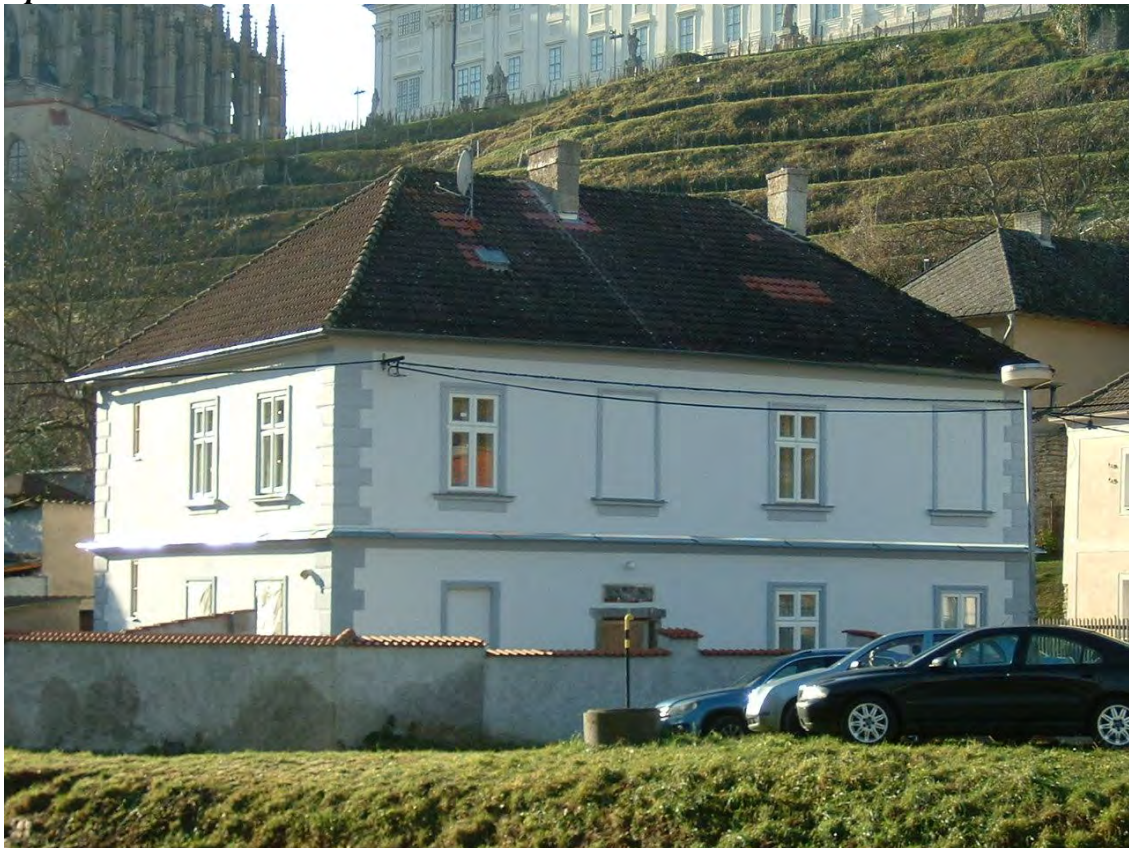
Stav po obnově
