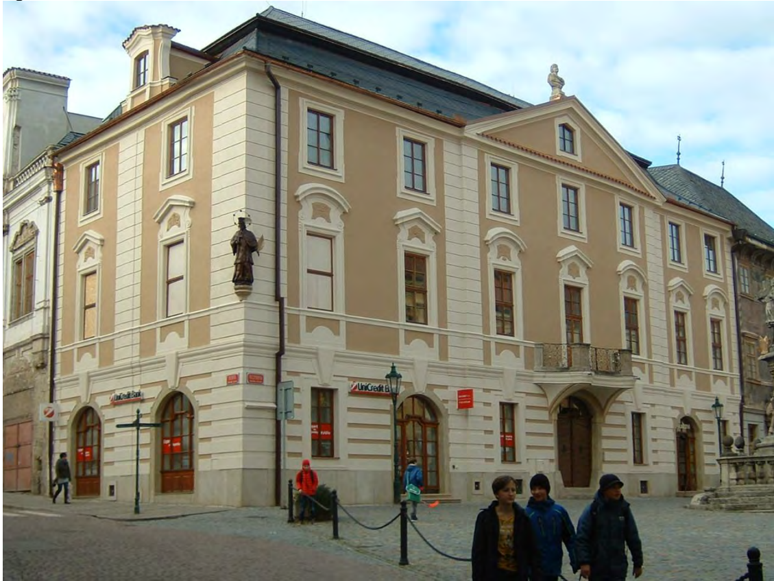
Stav po obnově
