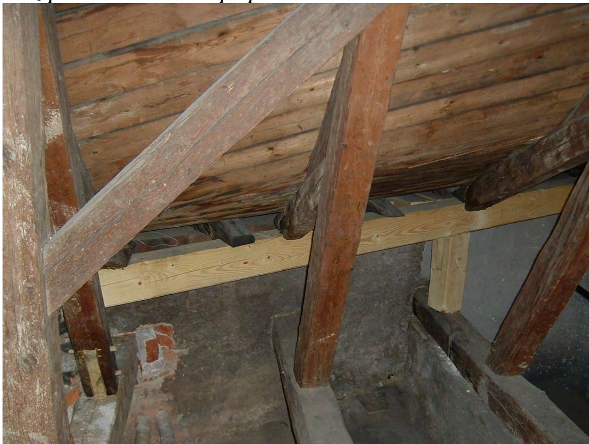
Severozápadní křídlo – stav krovu po opravě
