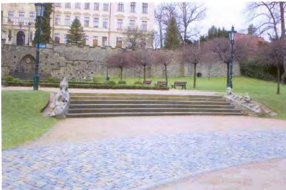
Krycí desky opěrných oblouků s kraby
