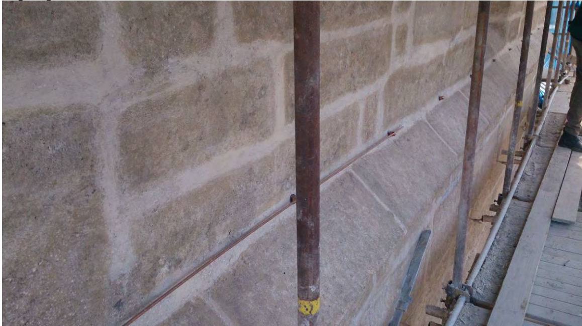
Stav po opravě
