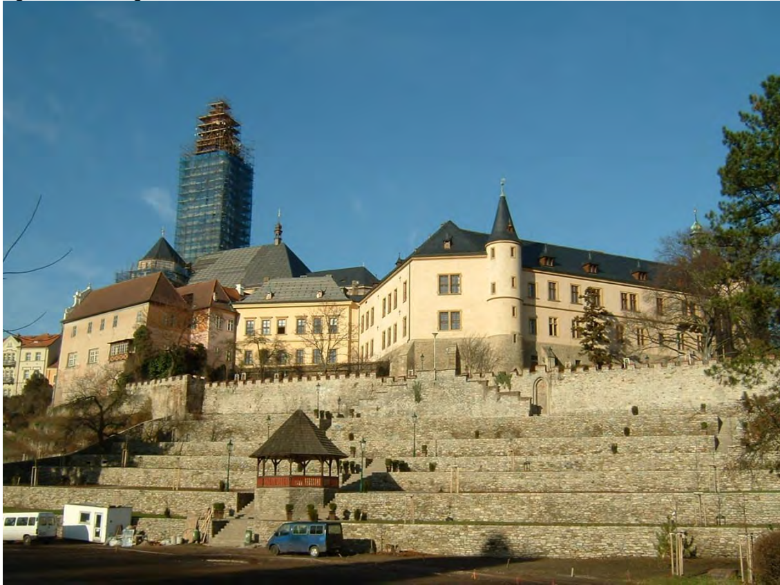
Stav po ukončení prací v roce 2015
