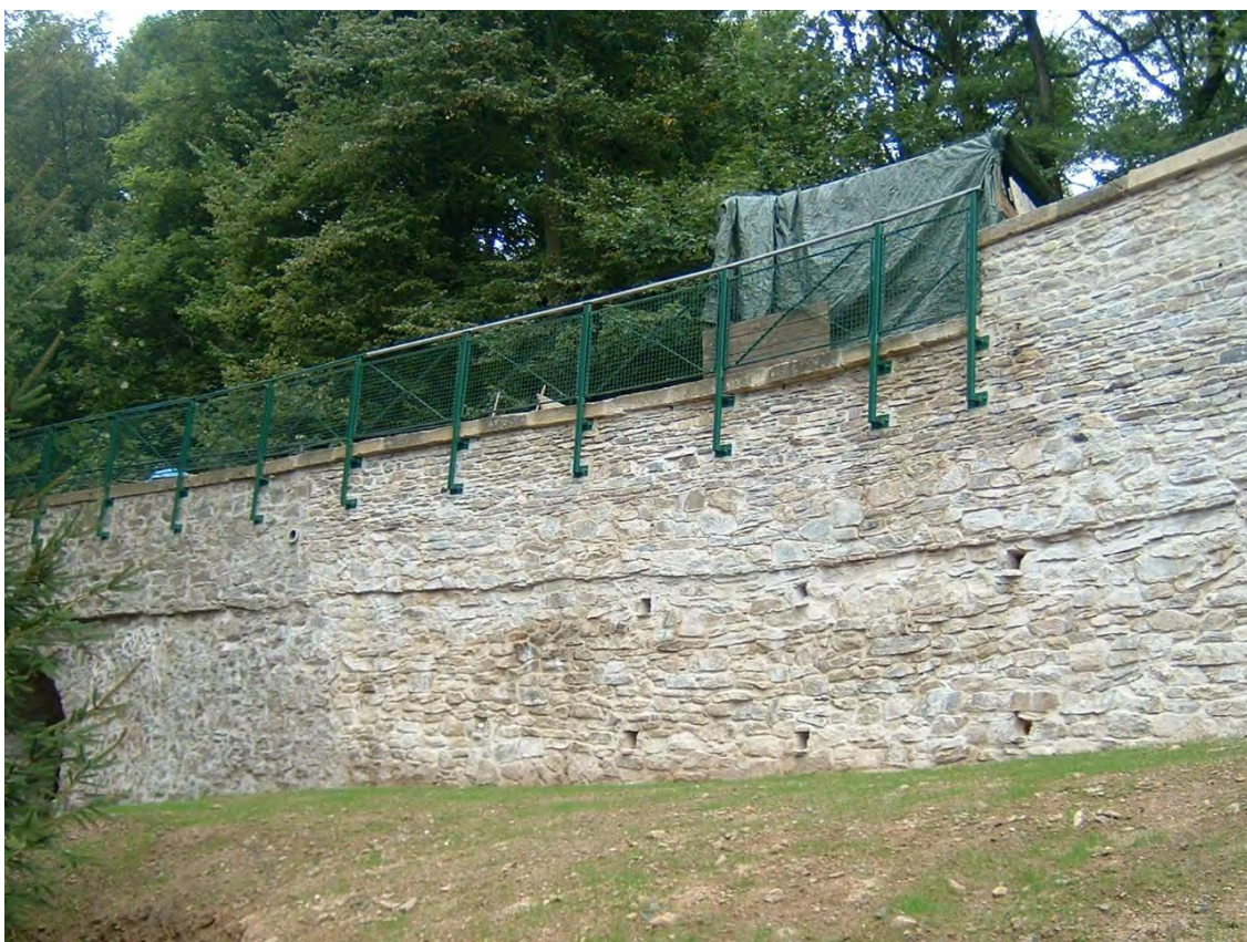
OPĚRNÁ ZEĎ U HRÁDKU
