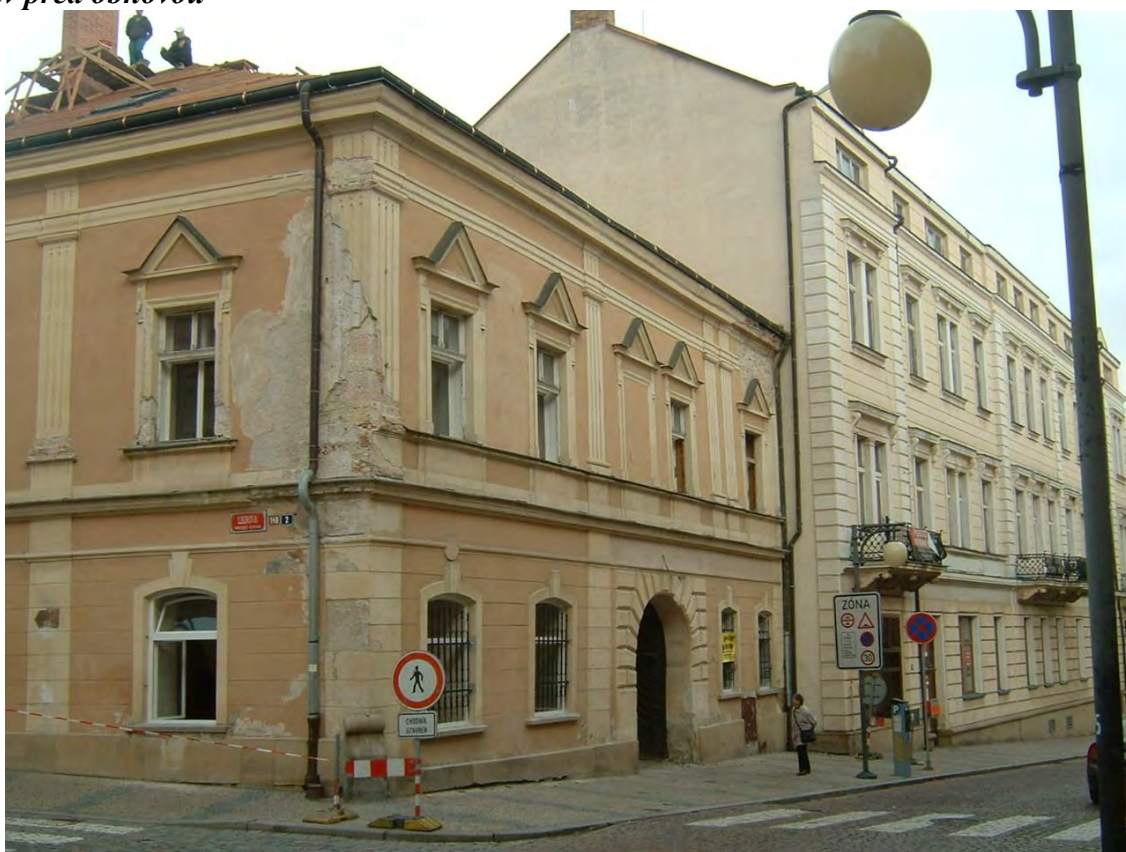
Stav před obnovou
