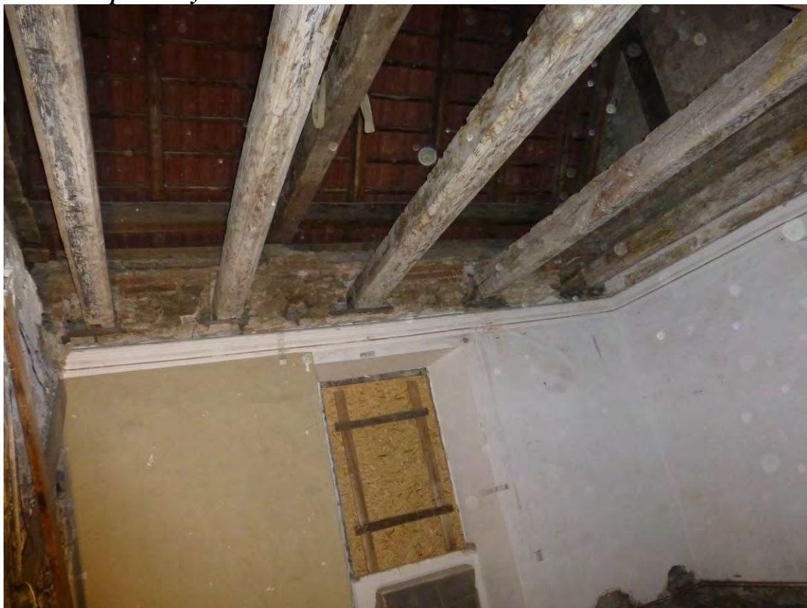
Malované stropní trámy
