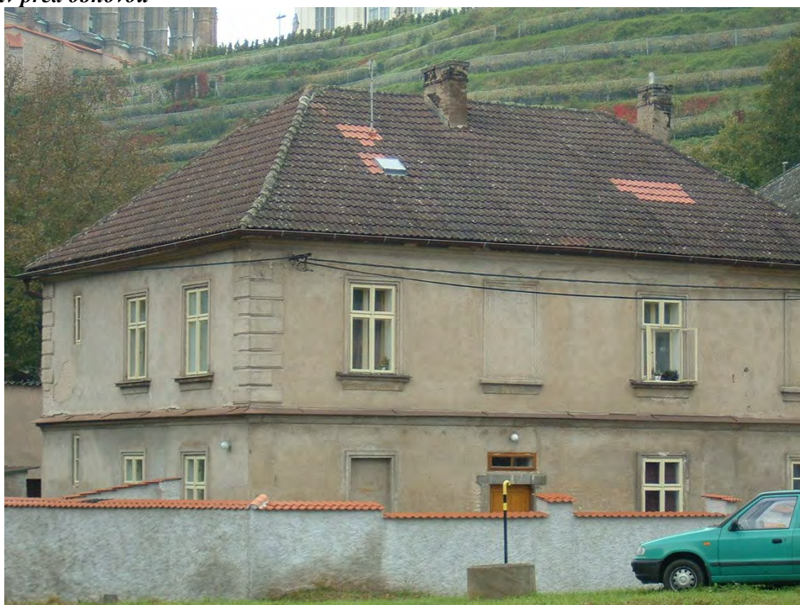
Stav před obnovou
