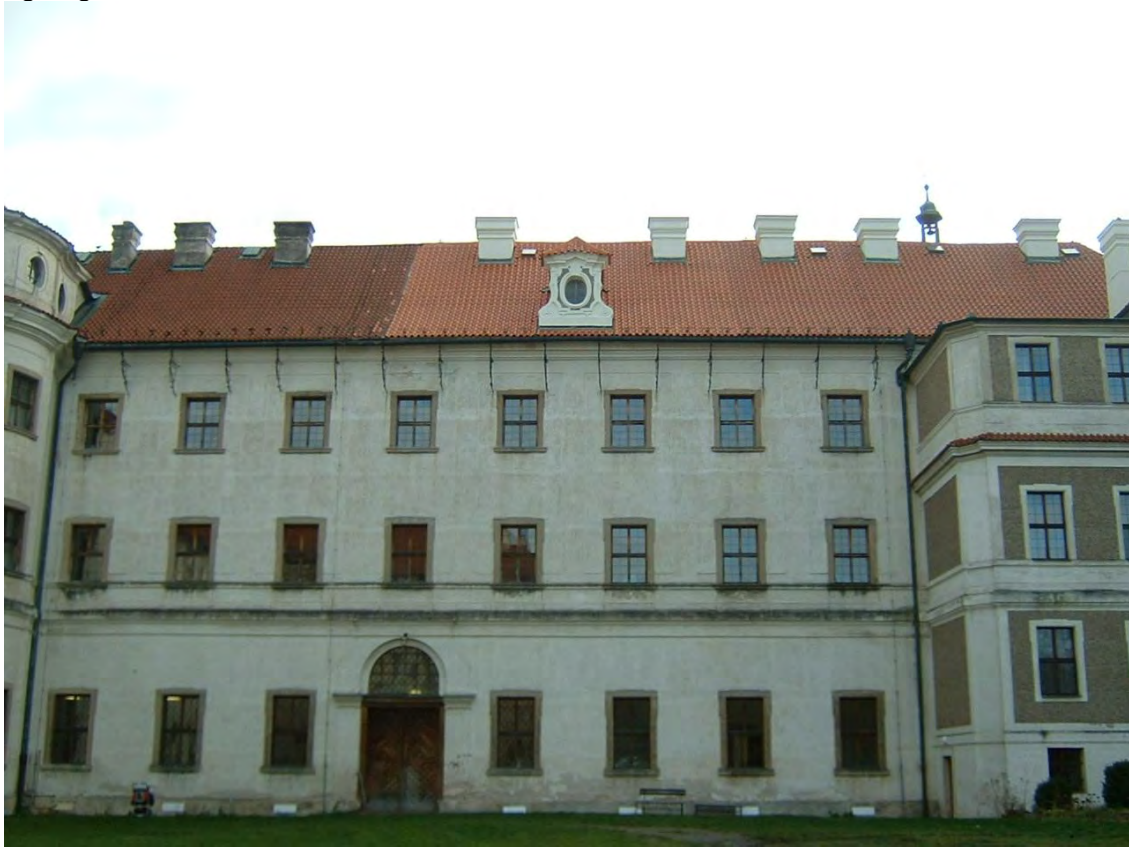
Stav po opravě
