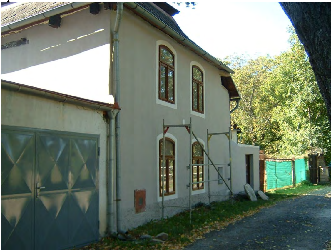
Stav po obnově
