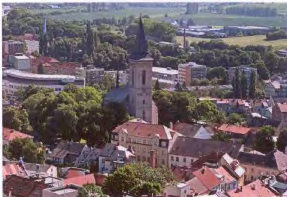
Stav před opravou
