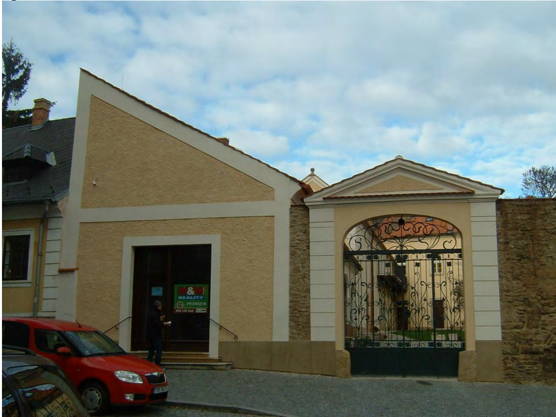
Stav po obnově
