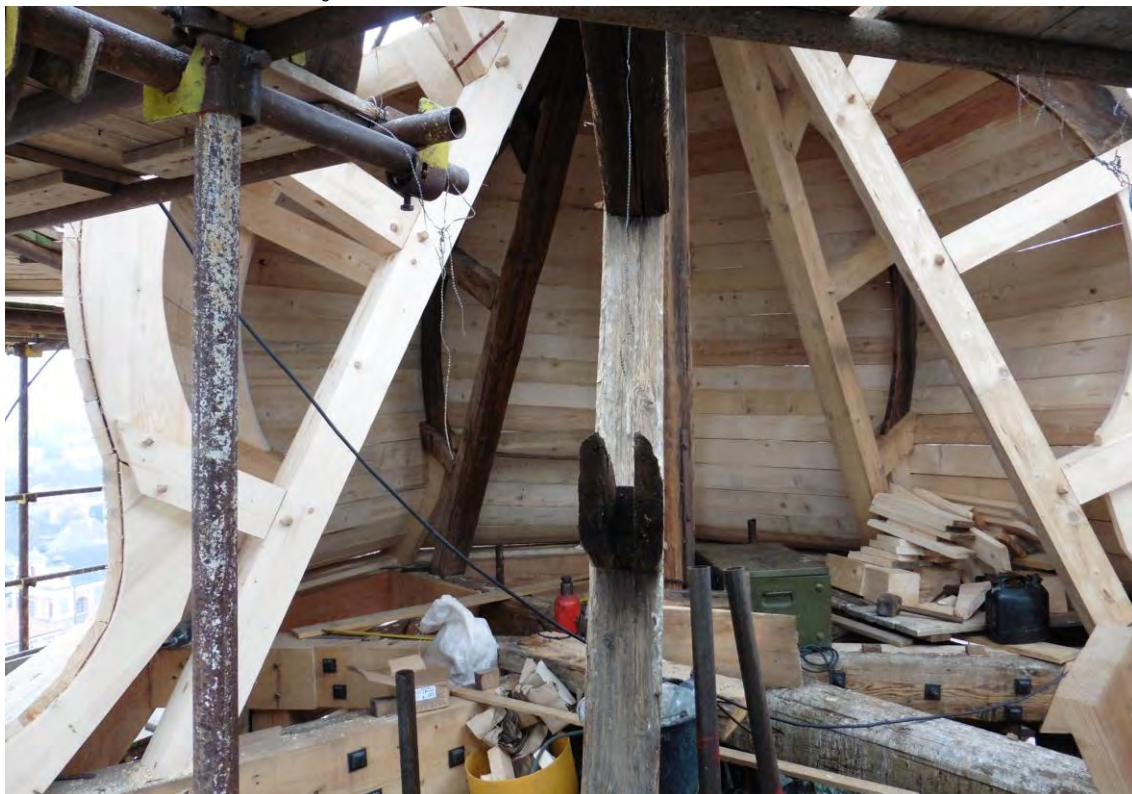
Oprava helmice severní věže
