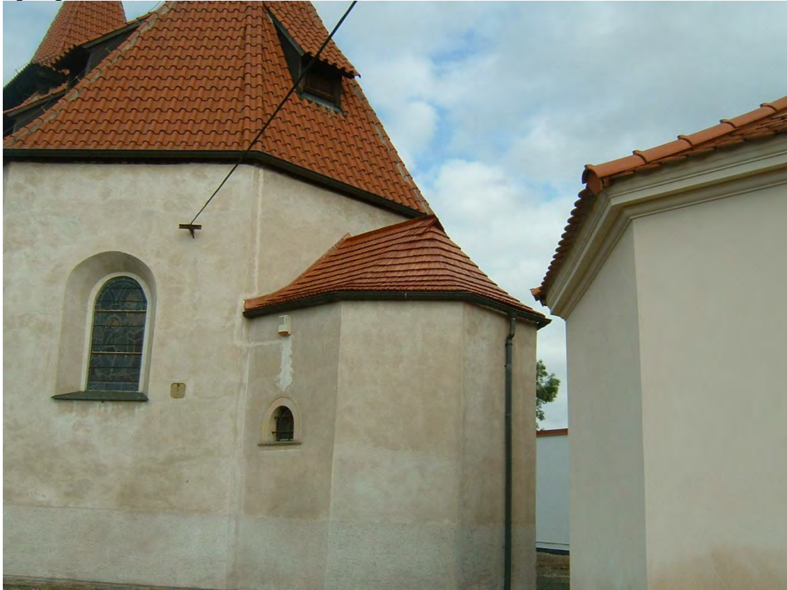
Stav po opravě
