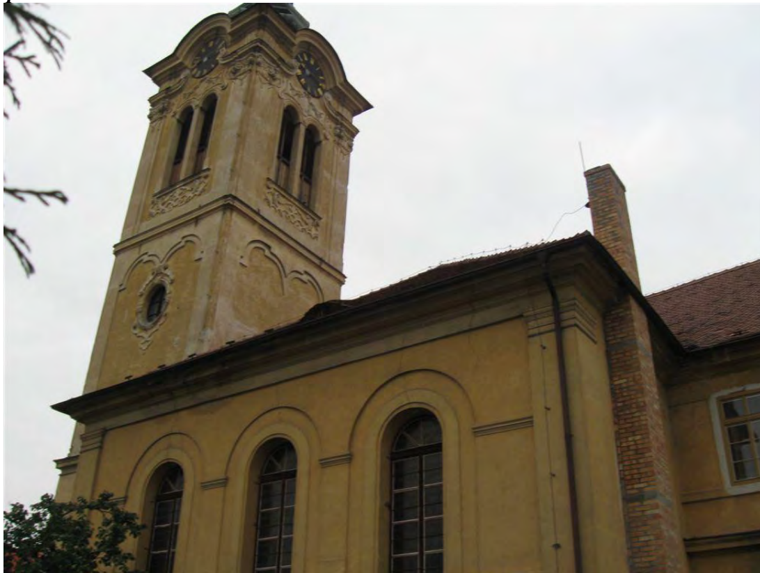
Stav před obnovou
