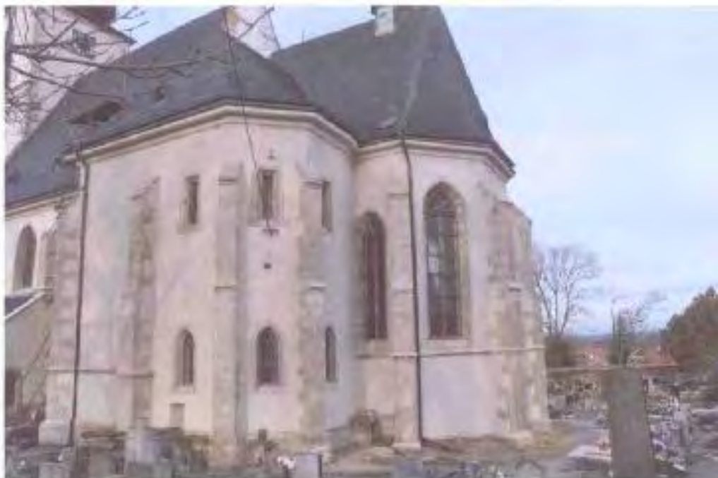
Stav po obnově
