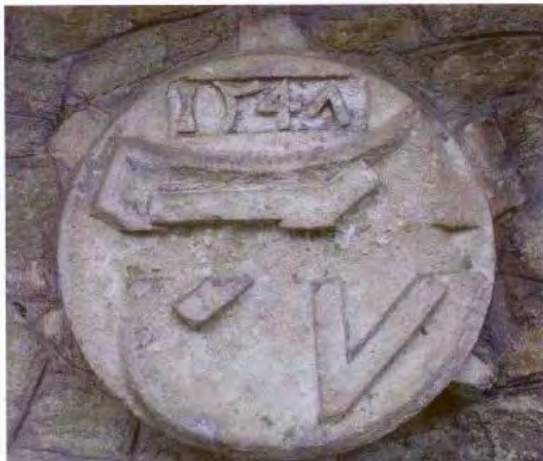
Klenební svorník s letopočtem 1547 a štítkem s kamenickou značkou
