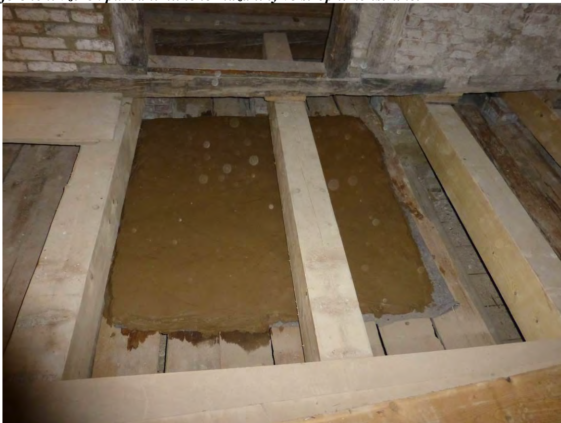
Referenční vzorek původní hliněné mazaniny ve stropní konstrukci
