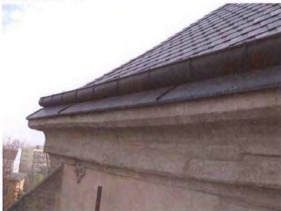
Římsa po opravě – 2015
