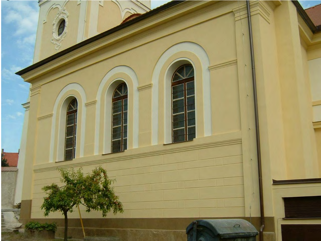
Stav po obnově
