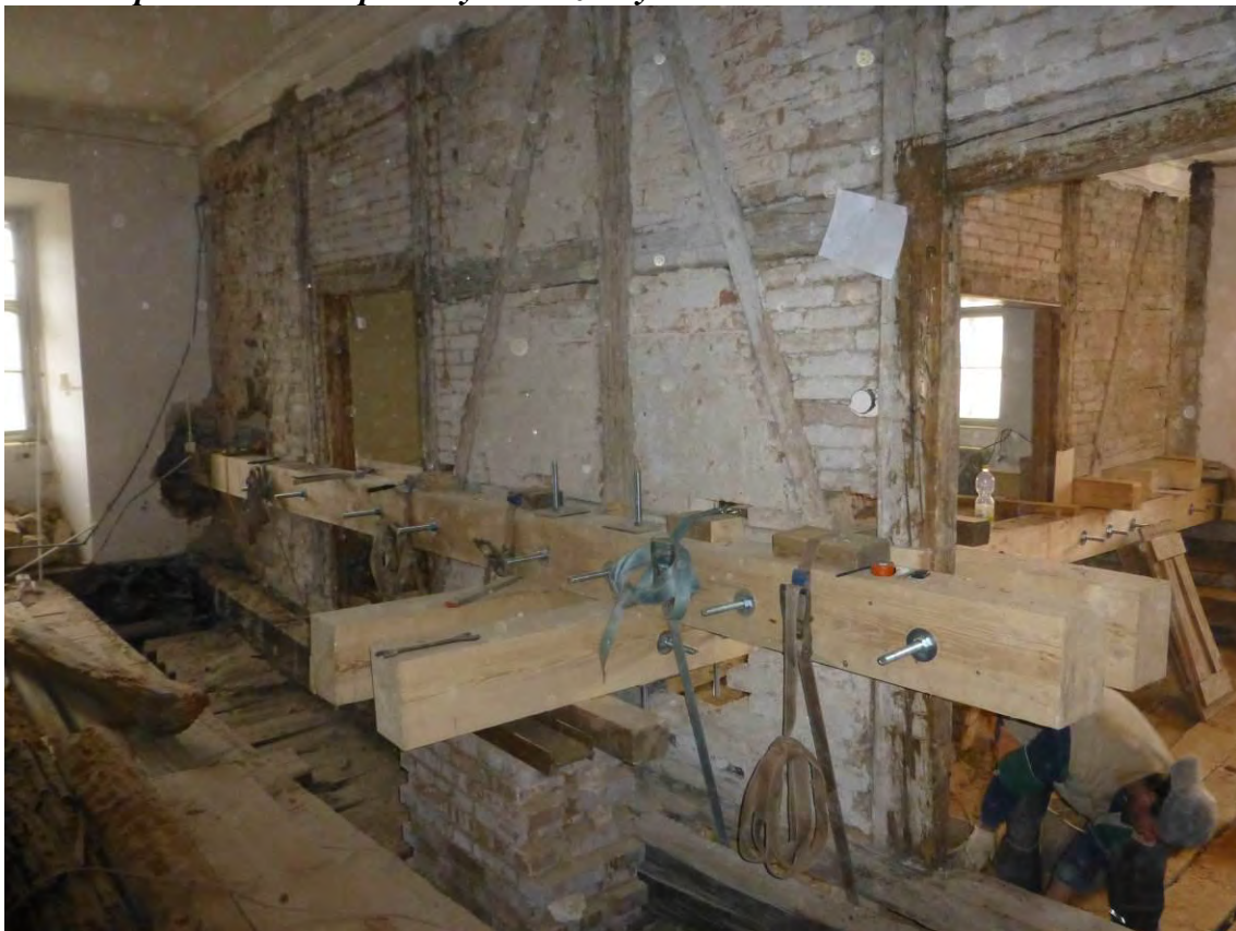
Konstrukce pro heverování pokleslých hrázděných stěn
