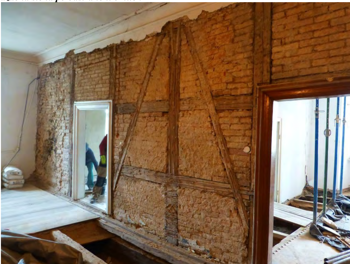
Hrázděná stěna po odstranění omítek
