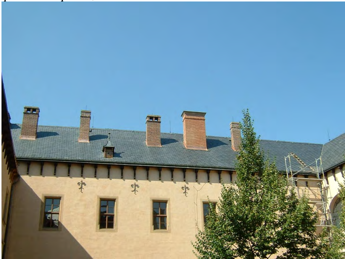
Stav po ukončení prací III. etapy Západní křídlo – pohled z nádvoří
