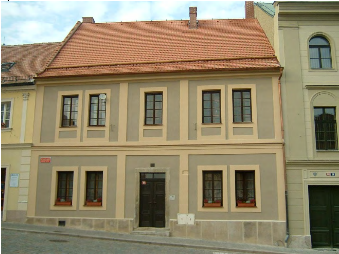
Stav po obnově
