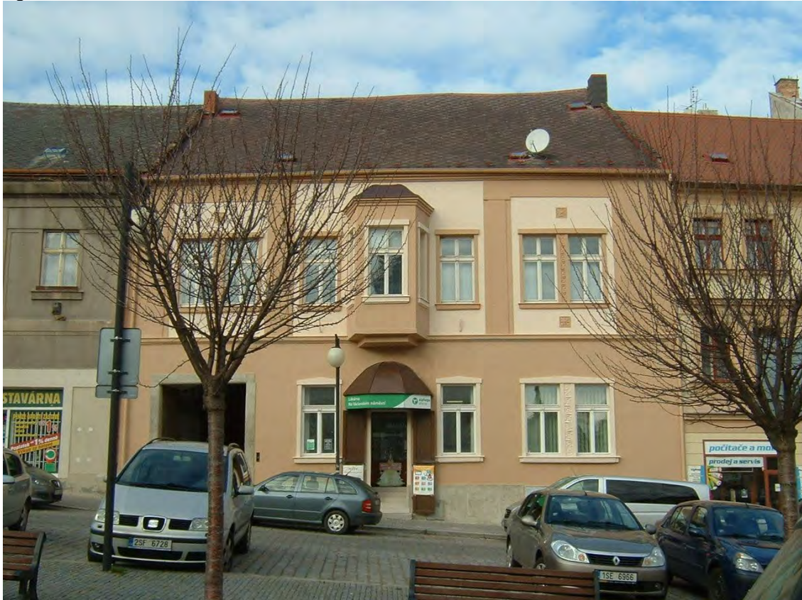
Stav po obnově
