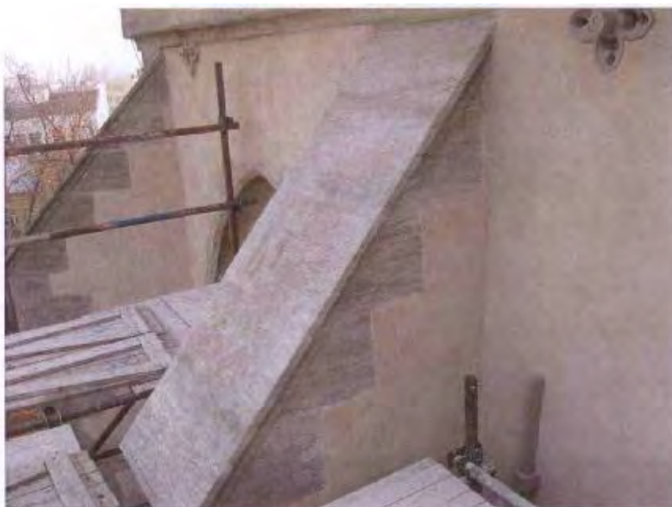
Opěráky po opravě - 2015
