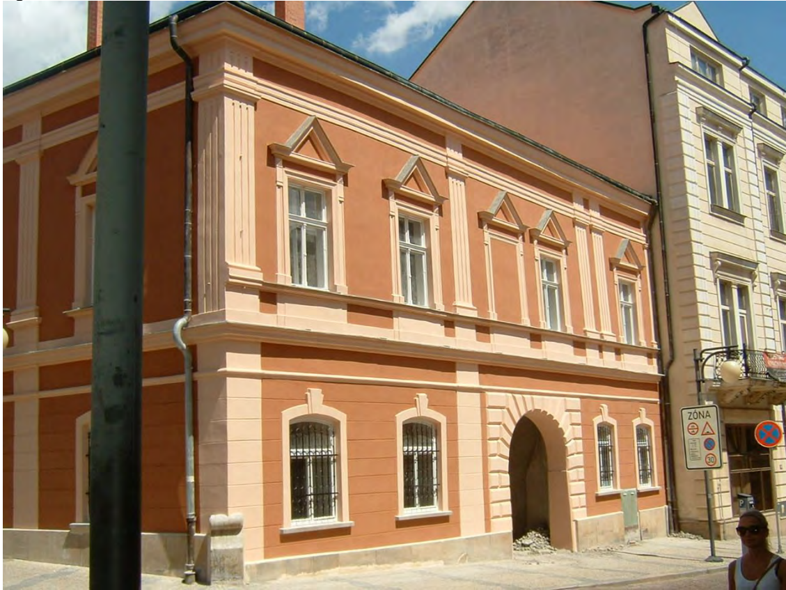
Stav po obnově
