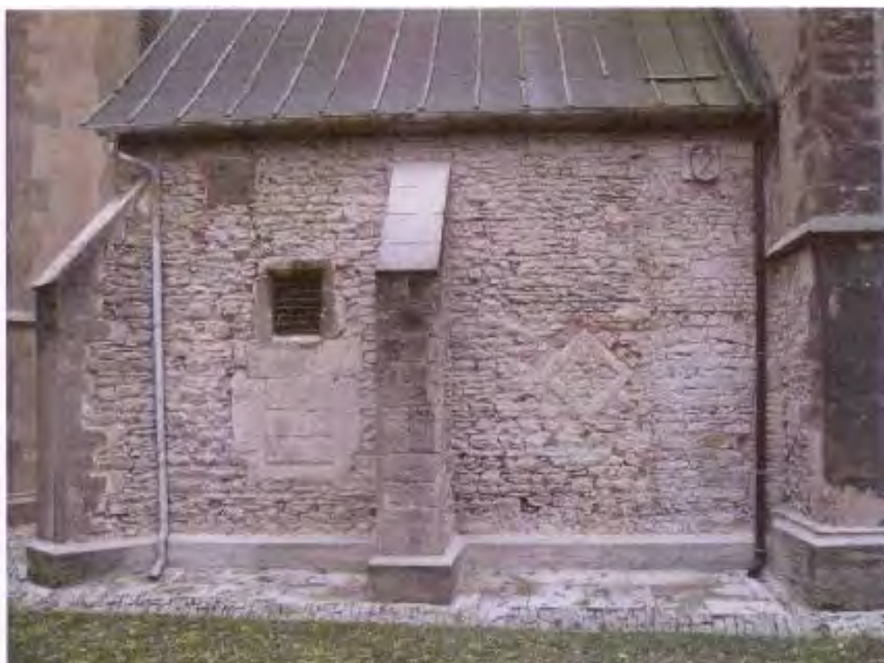
Stav po opravě
