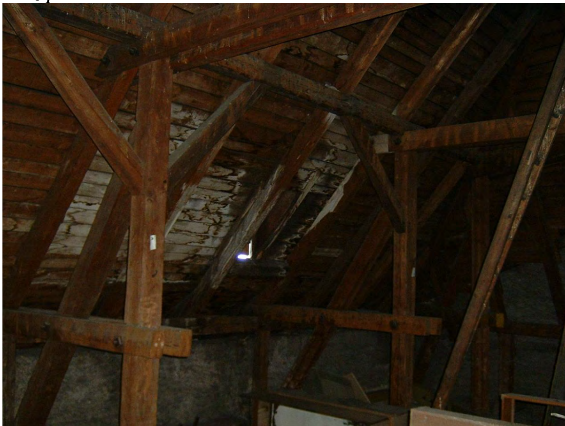
Severozápadní křídlo – stav krovu
