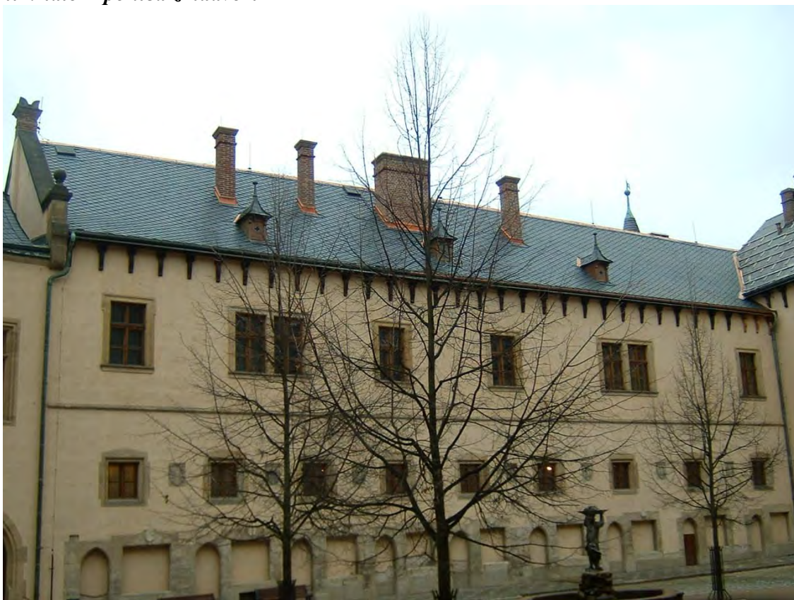
Stav po ukončení prací II. etapy Jižní křídlo - pohled z nádvoří
