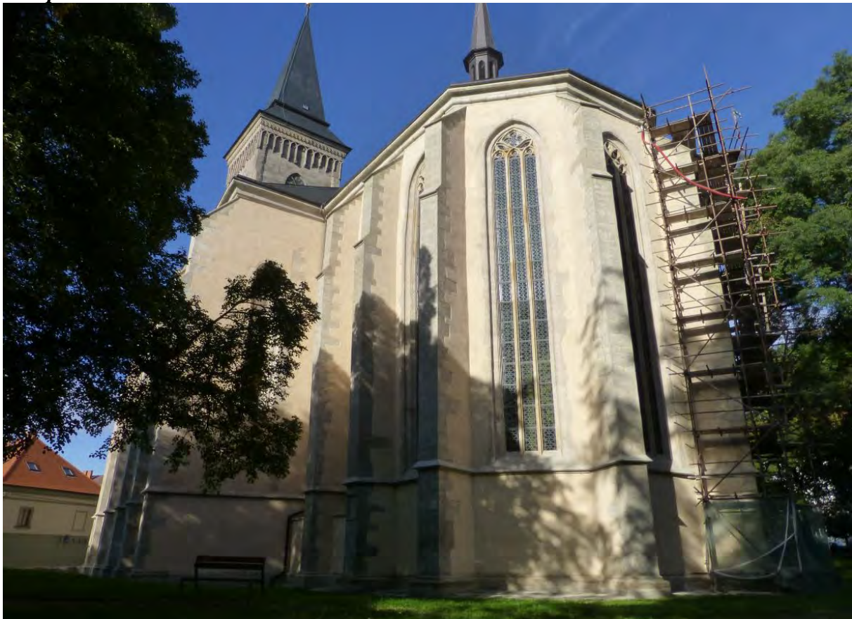
Stav před obnovou
