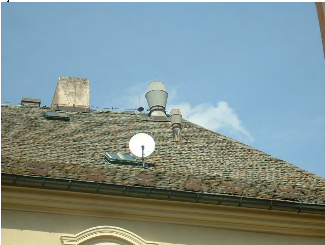
Stav před obnovou
