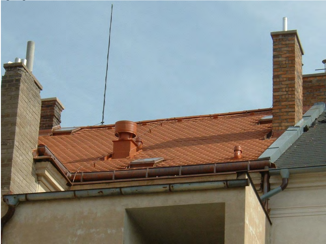
Stav po opravě
