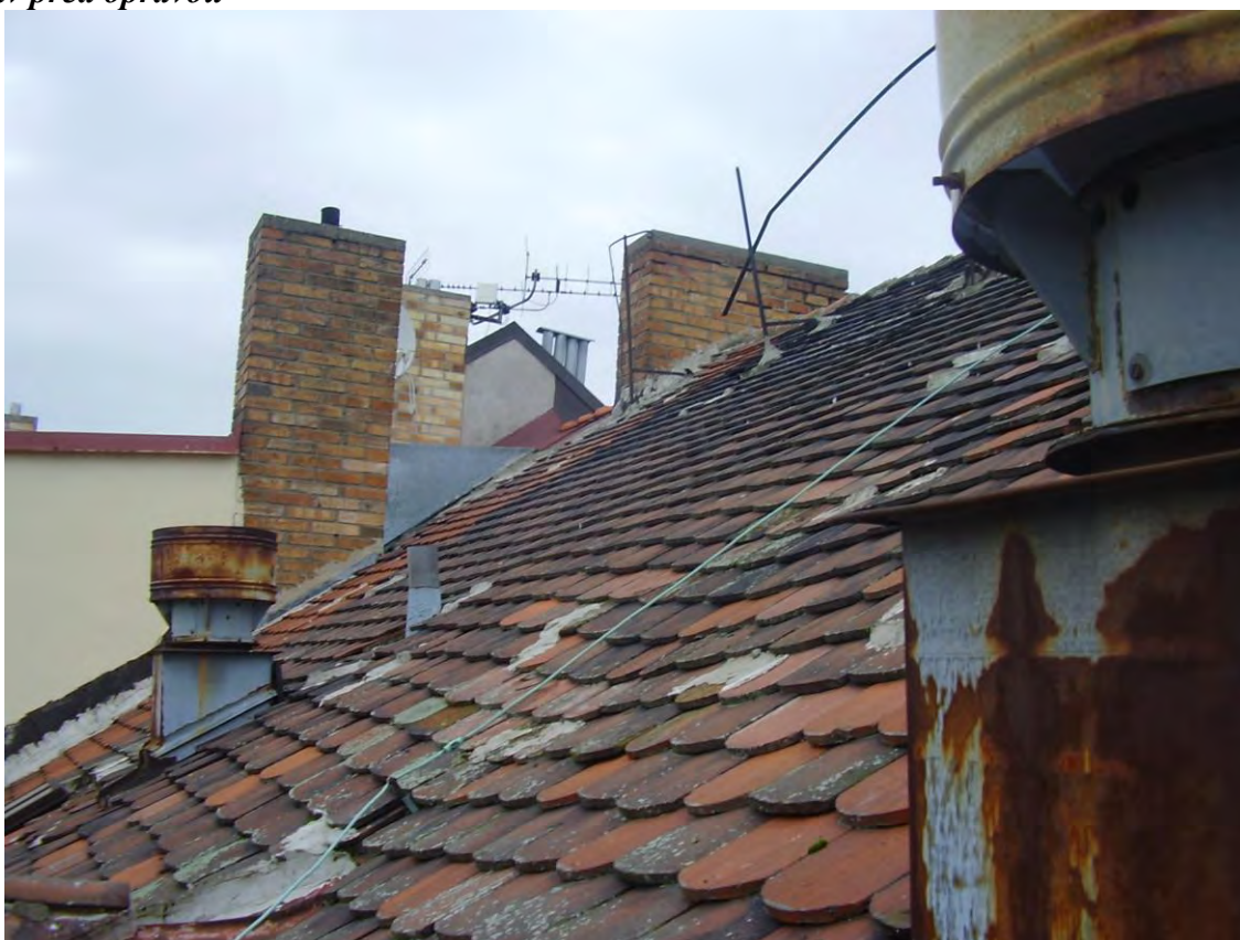
Stav před opravou
