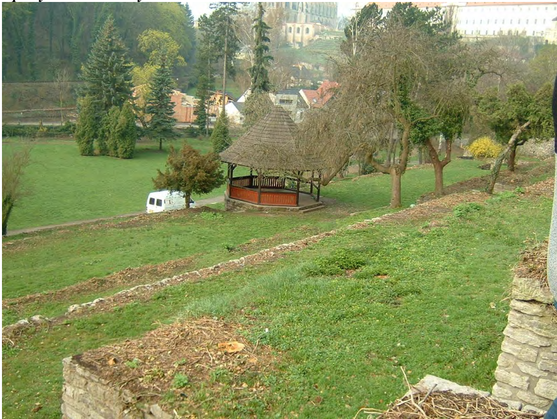
Stav po vyřezání náletových dřevin
