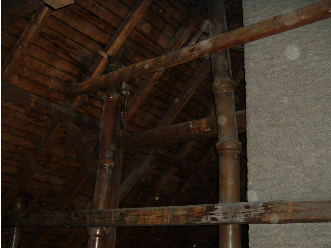
Západní křídlo – stav krovu a bednění před započatím oprav
