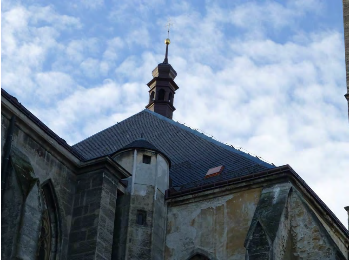
Stav po obnově
