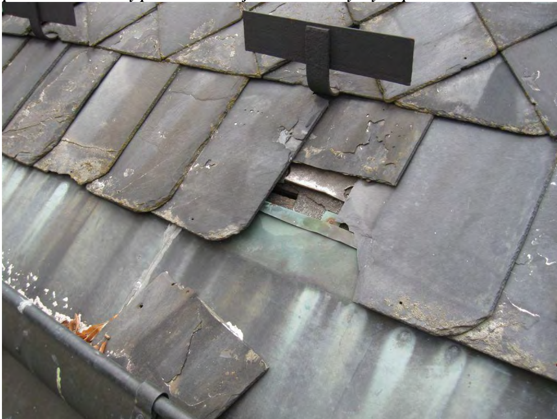
Západní křídlo - detaily poškozené stávající břidlicové krytiny a oplechování
