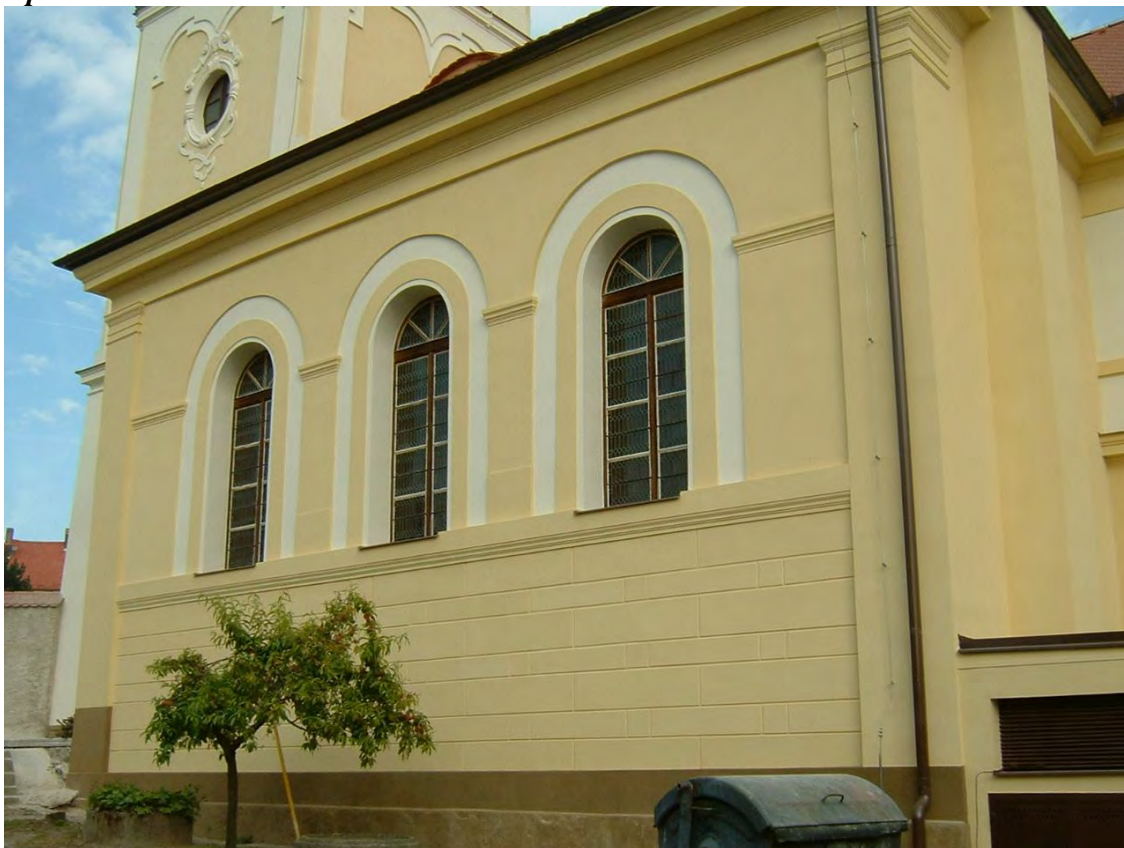
Stav po obnově
