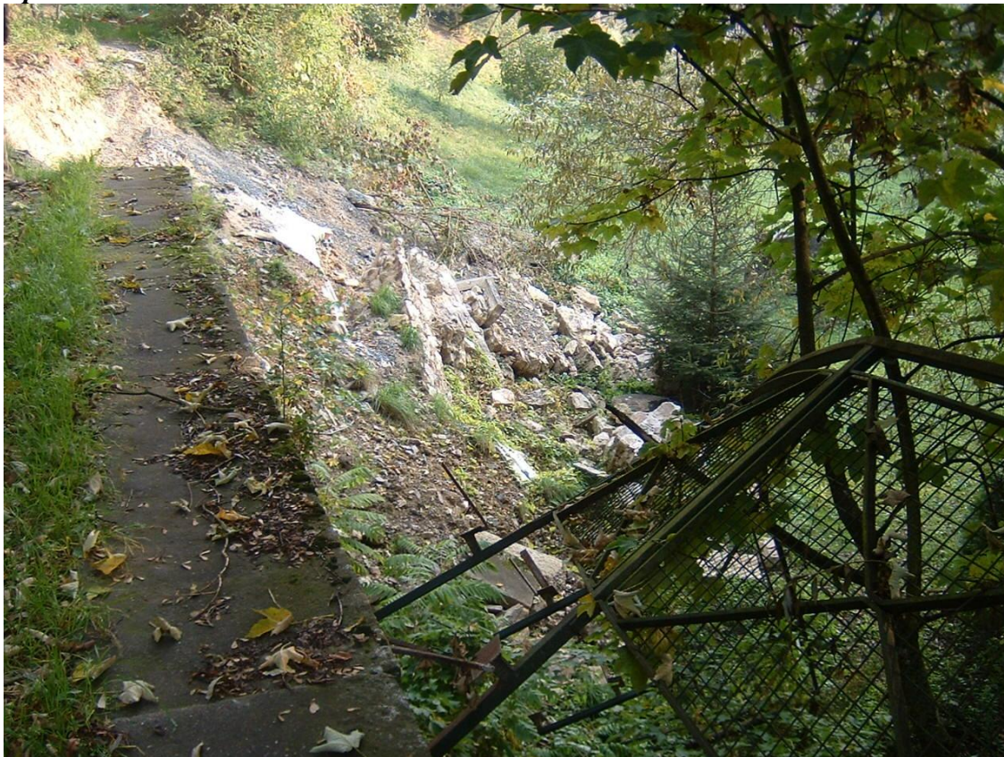
Stav po zřícení části mostu
