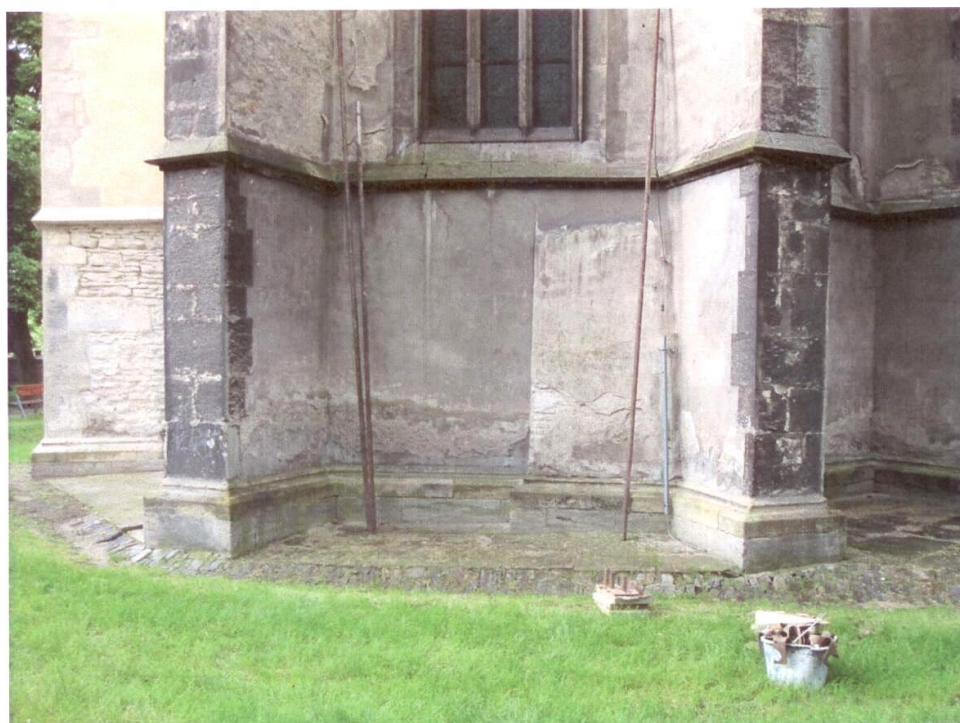
Sokl presbytáře před opravou
