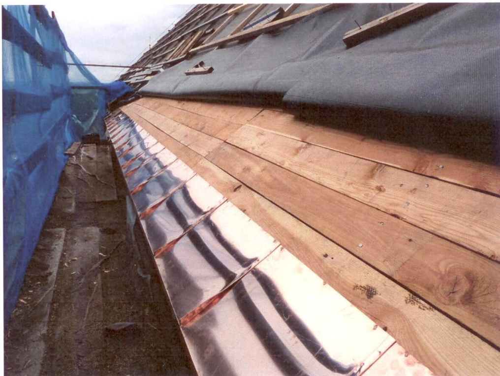
Montáž klempířských výrobků na lodi kostela
