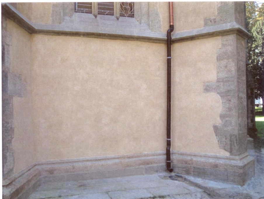
Opravený sokl presbytáře
