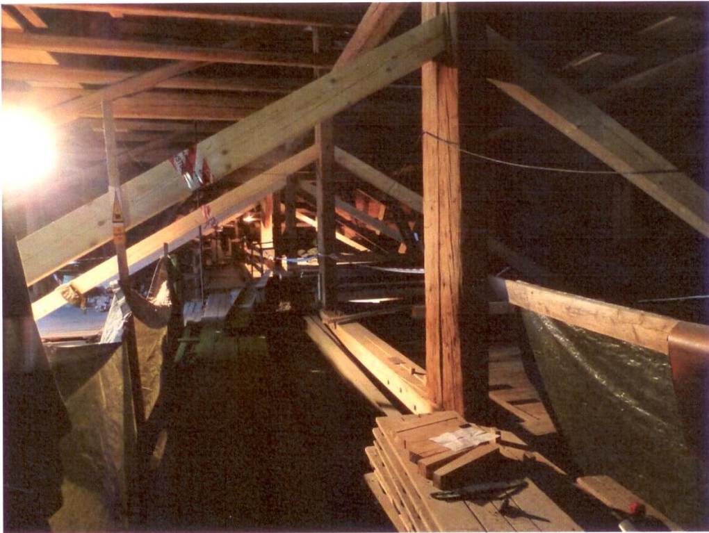
Nové středové vzpěry po montáži
