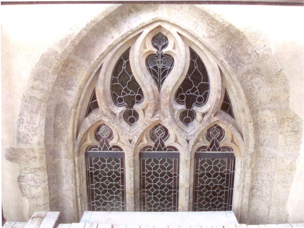
Horní část zrestaurovaného okna
