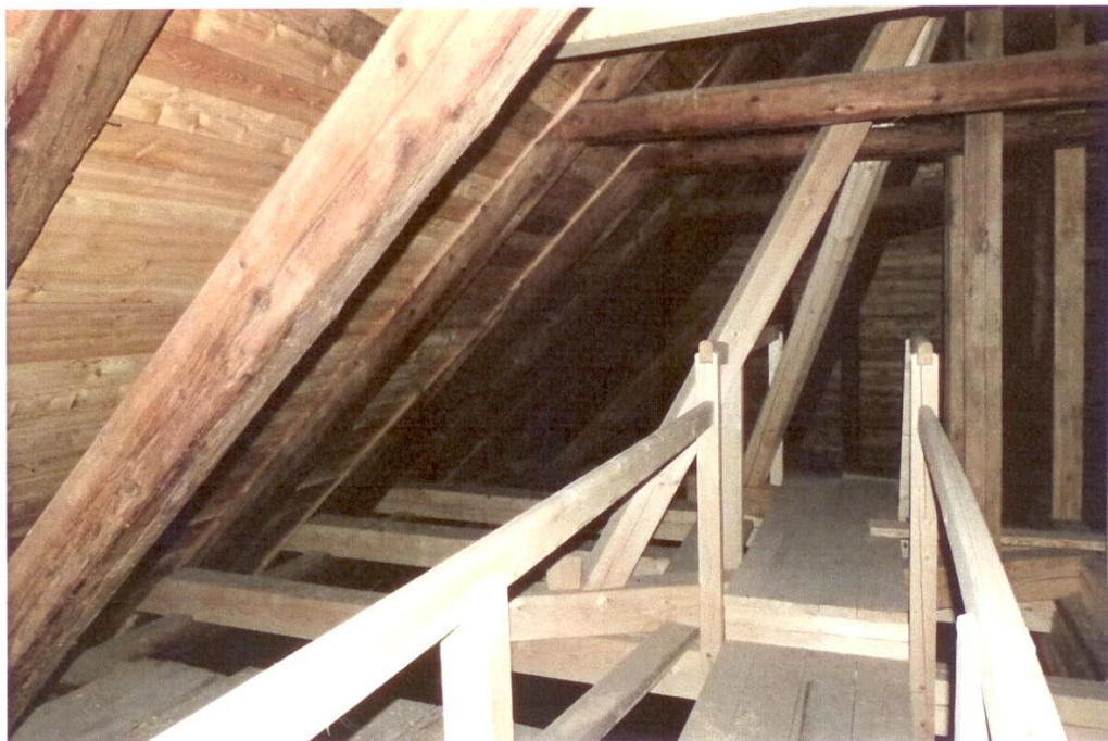
Konstrukce lávky v lodi kostela
