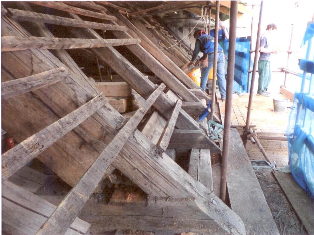
Severní část lodi po demontáži krytiny a šindele - r.2013
