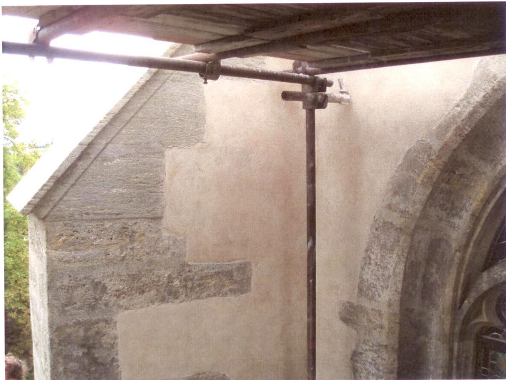
Opěrák presbytáře po restaurování kamene a opravou v r. 2013
