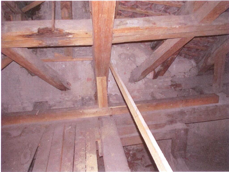
tesařské konstrukce – montážní zajištění
