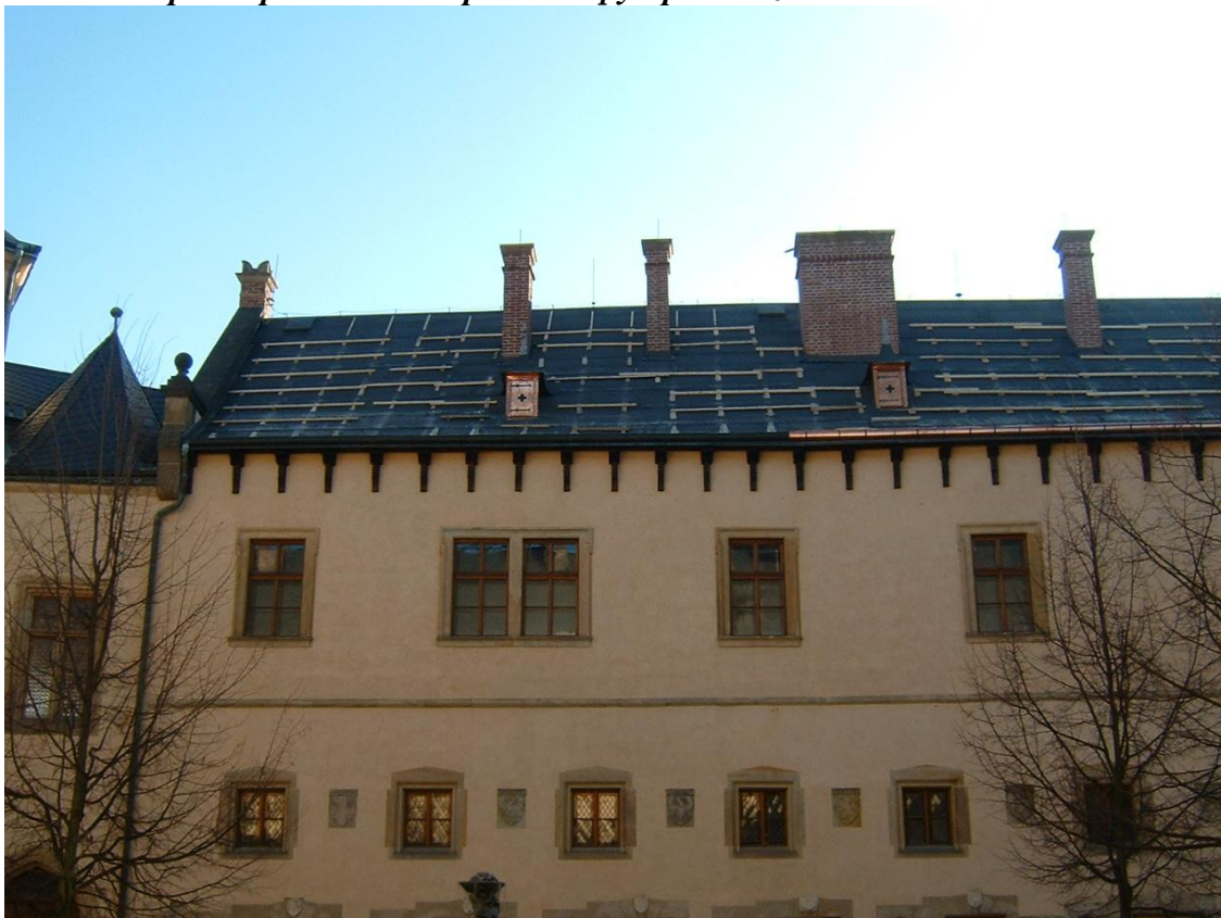
Stav střešního pláště po ukončení oprav I.etapy - pohled z nádvoří
