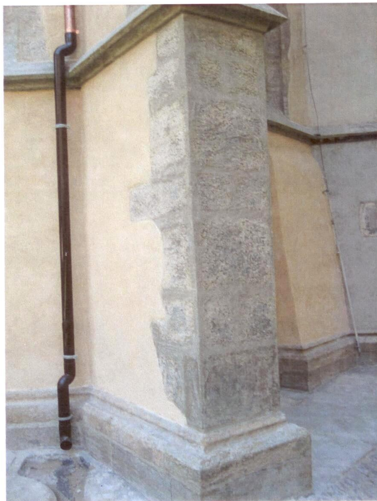
Opěrák presbytáře po restaurování kamene a opravou v r. 2013
