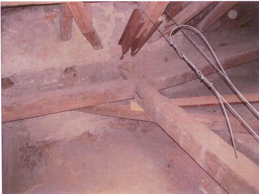
tesařské konstrukce – montážní zajištění
