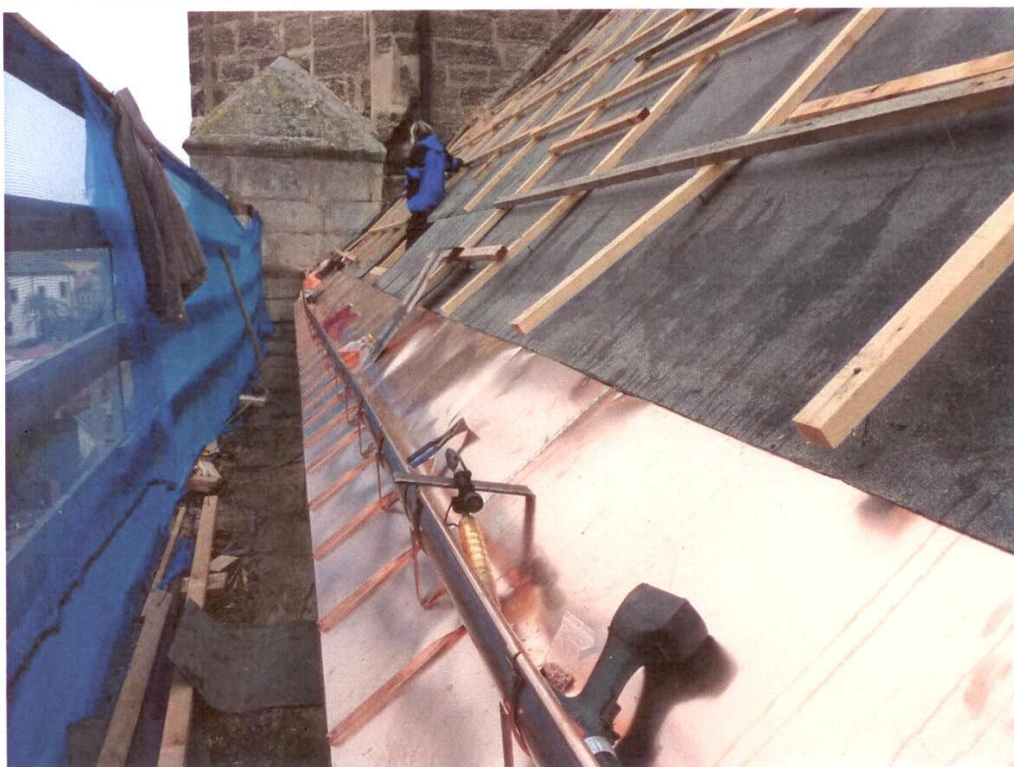
Montáž klempířských výrobků na lodi kostela
