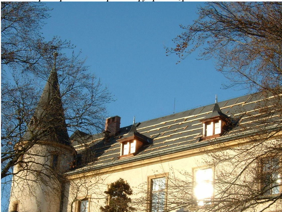
Stav střešního pláště po ukončení oprav I.etapy - pohled z parku
