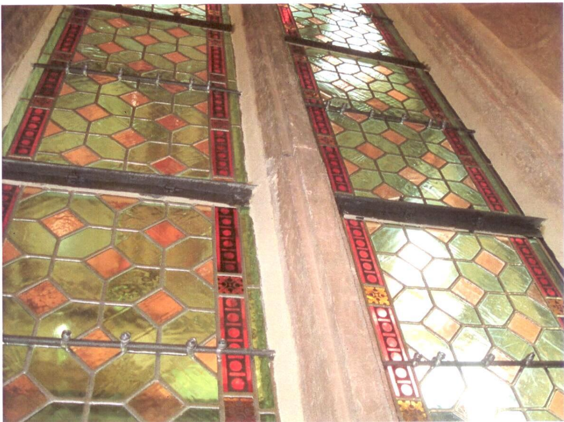
Část restaurované vitráže z interiéru kostela
