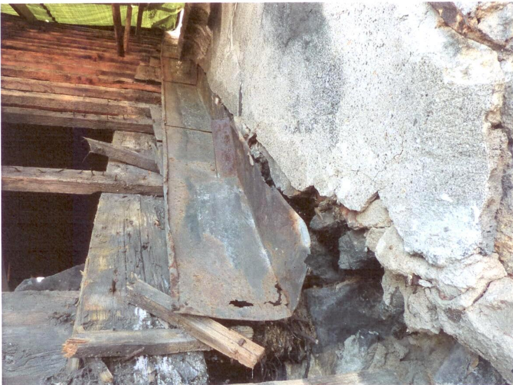
Stav klempířských výrobků u věže kostela před opravou - 2013
