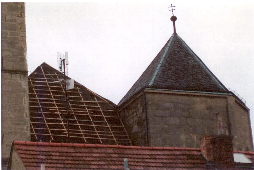
Západní valba po opravě - r.2013
