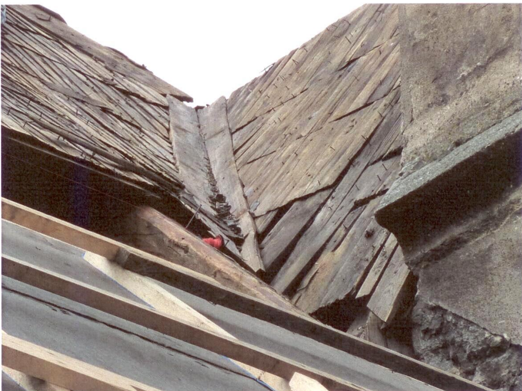
Stav šindelového podbití po demontáži břidlice
