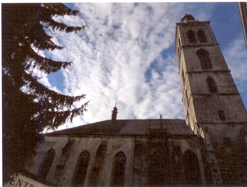
Severní část lodi kostela po opravě - r. 2013
