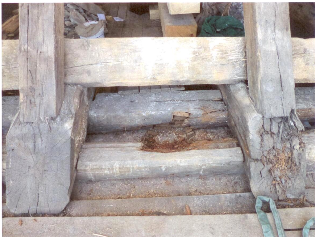
Příklad poškození krovu na severní části lodi - r.2013
