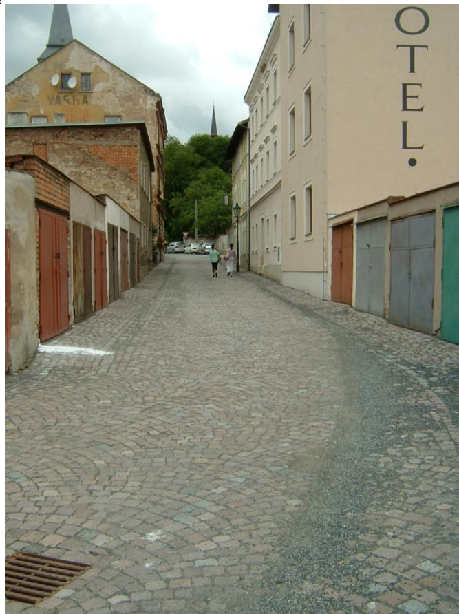
Uhelná ulice – stav po obnově
