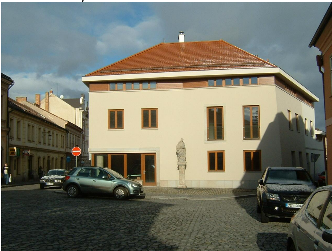
Anenské náměstí – stav po obnově
