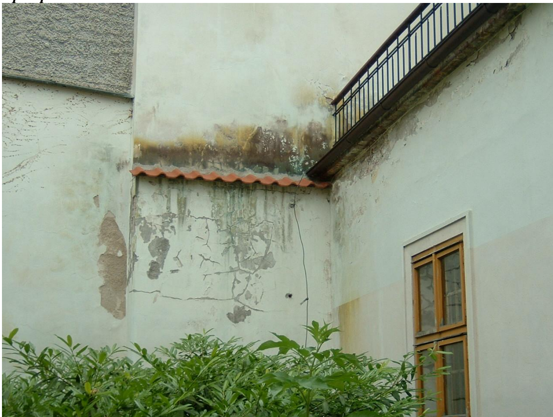
Stav po opravě
