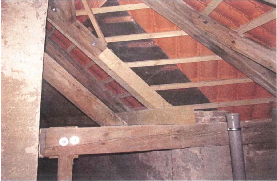
Stav po opravě
