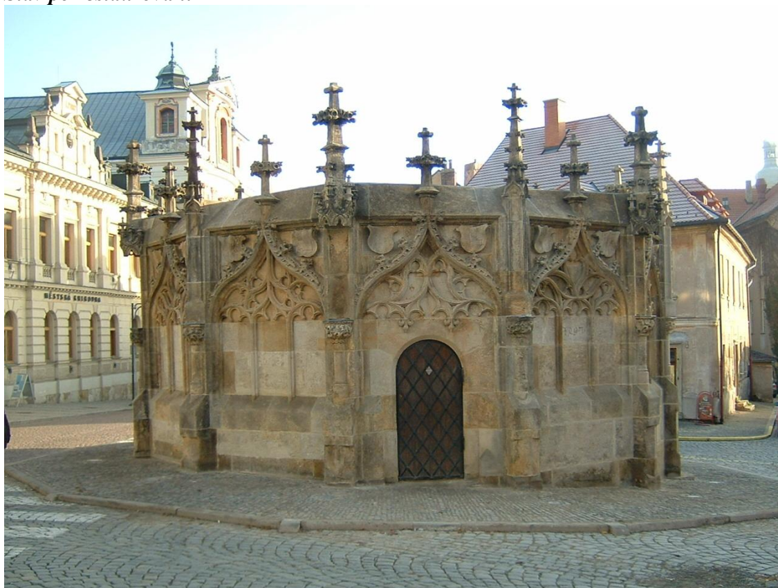
Stav po restaurování
