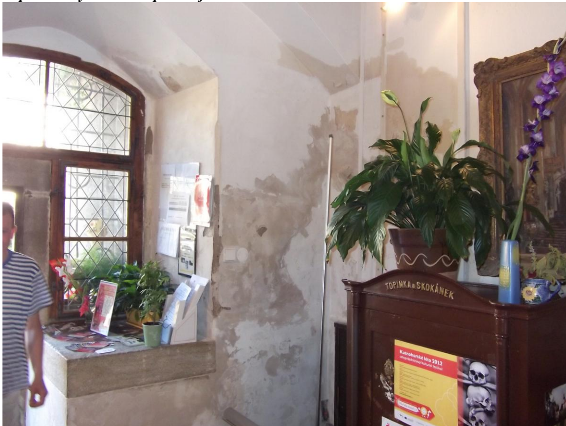
Stav poškozených omítek před sejmutím
