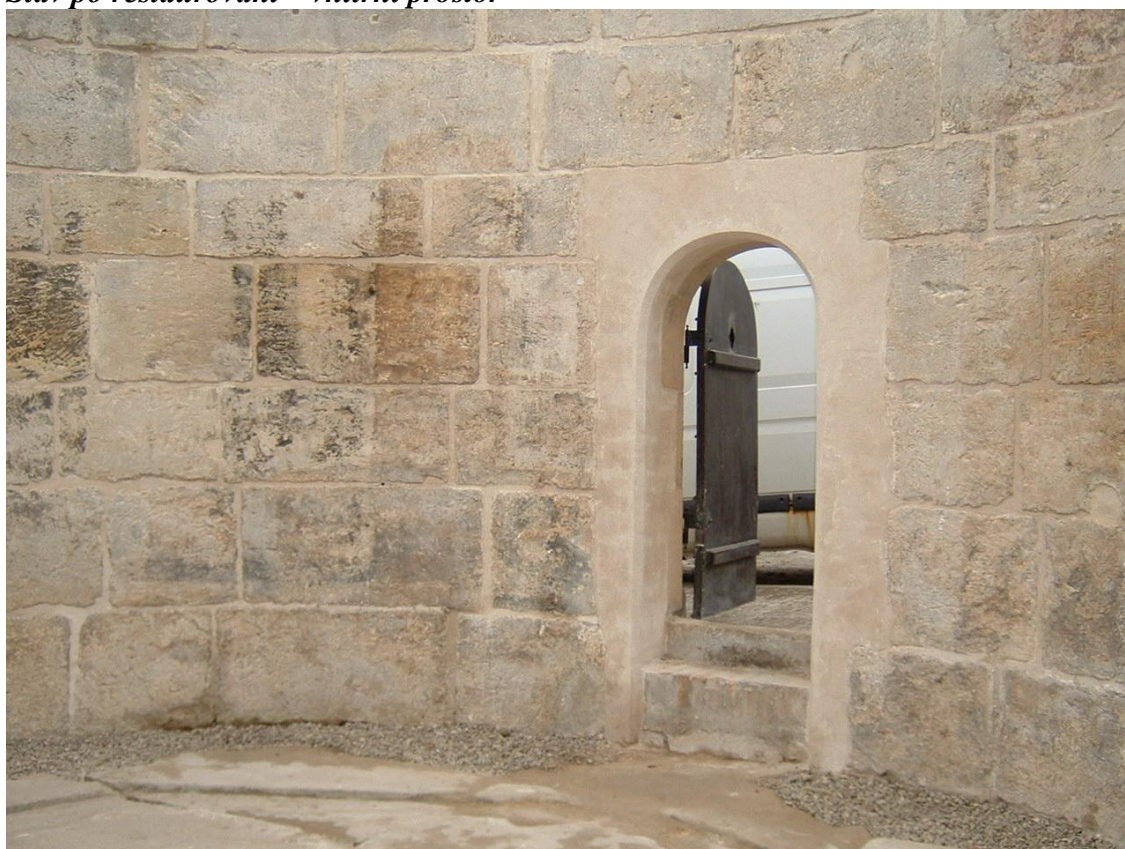
Stav po restaurování – vnitřní prostor
