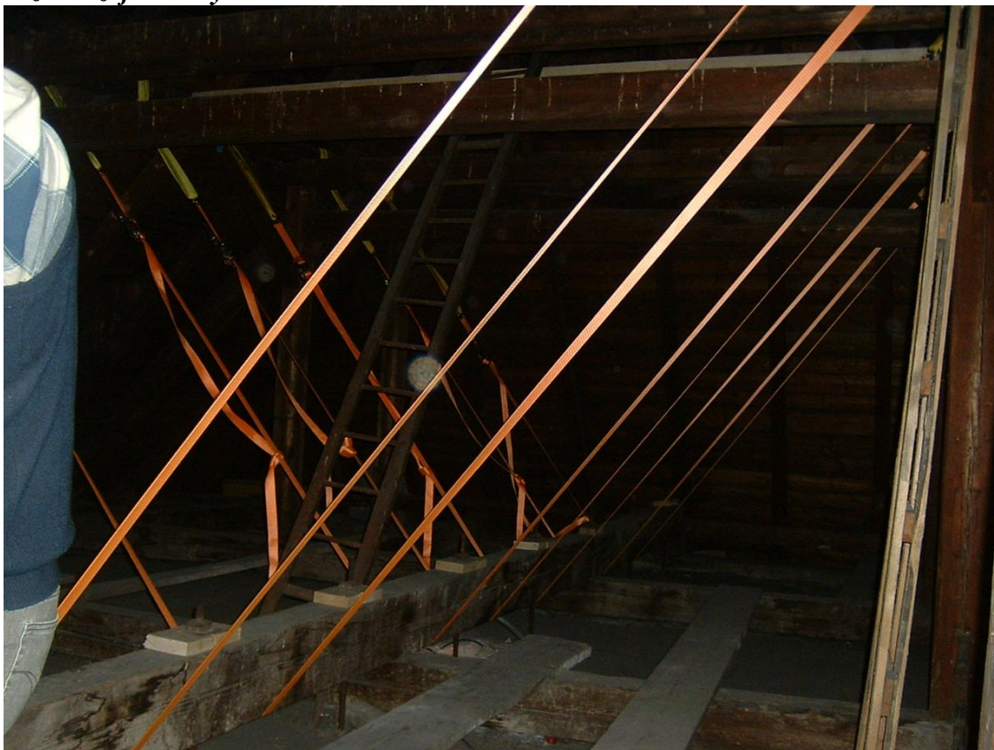
Provizorní zajištění vynášecího trámu
