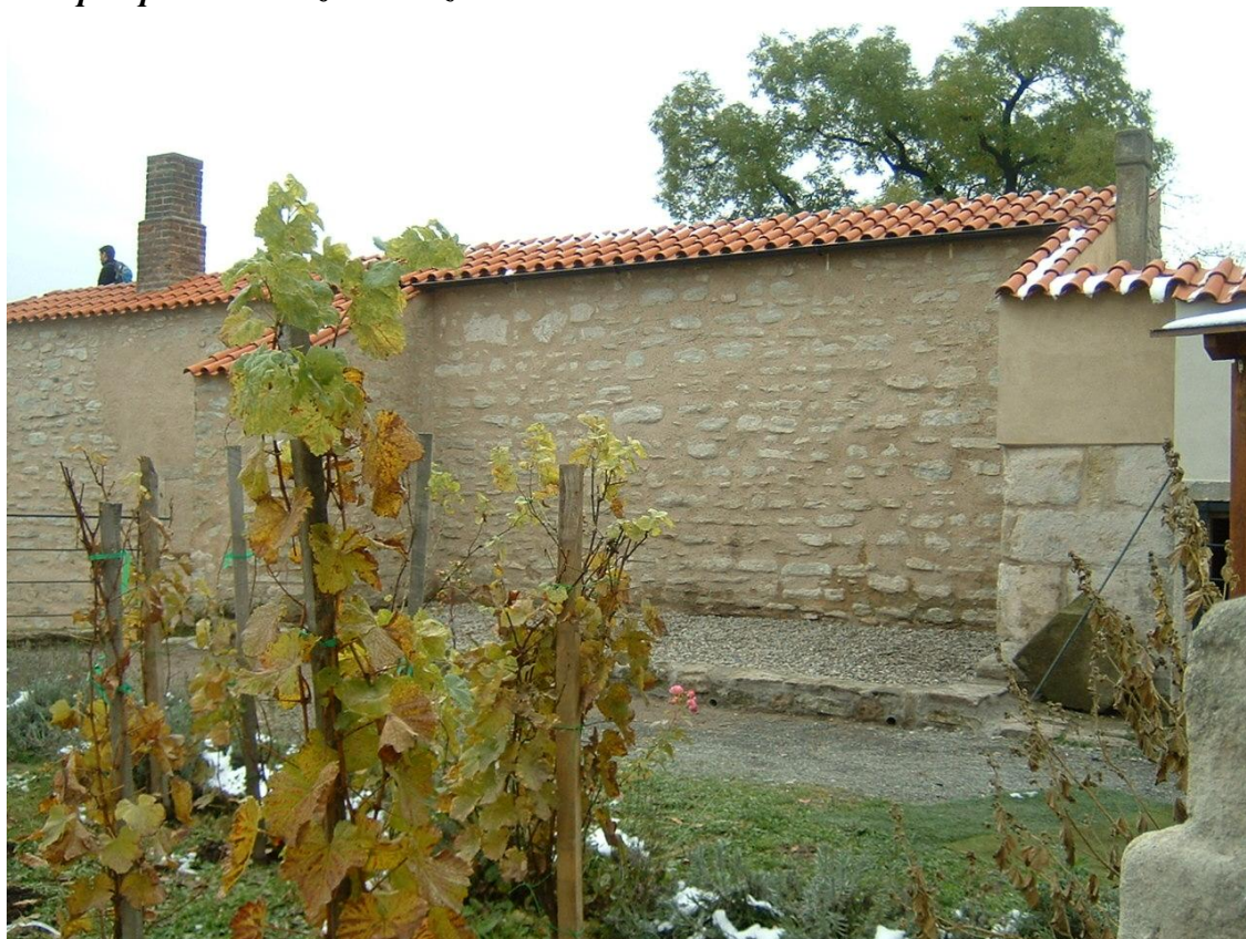
Stav po opravě vodovzdorné izolace nad komorou
