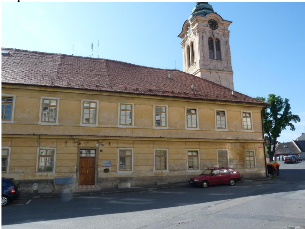
Stav před opravou
