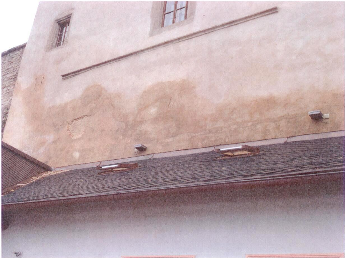
Stav poškozených omítek před sejmutím
