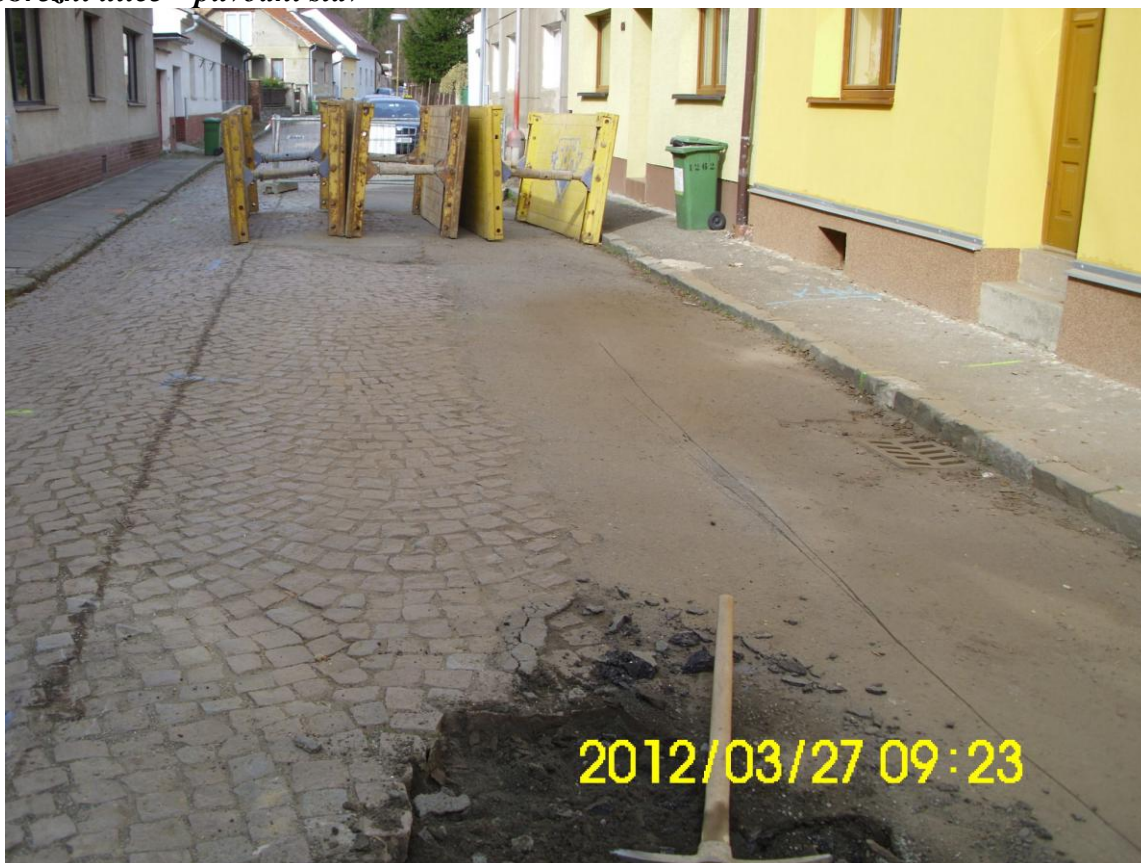
Pobřežní ulice – původní stav
