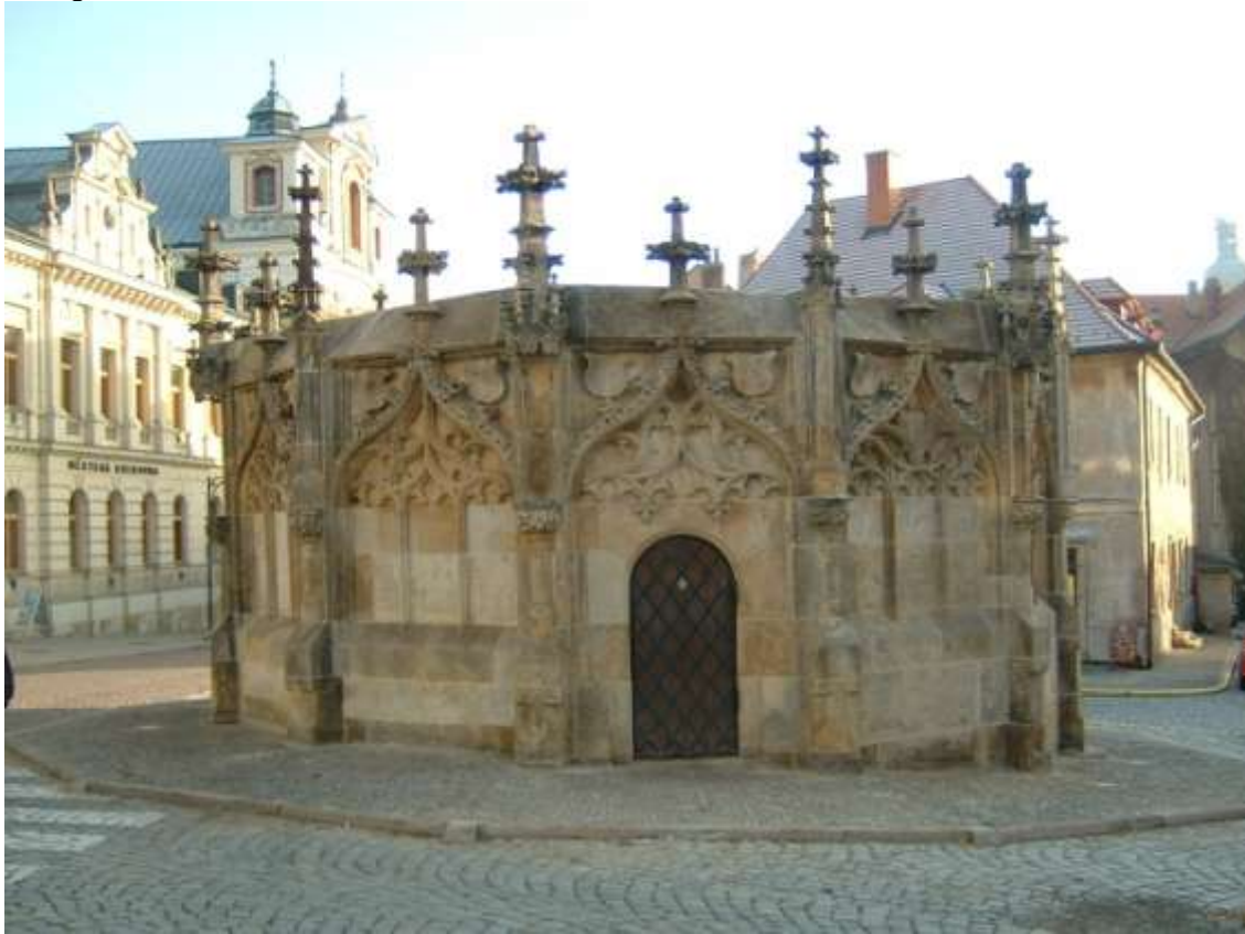
Stav po restaurování
