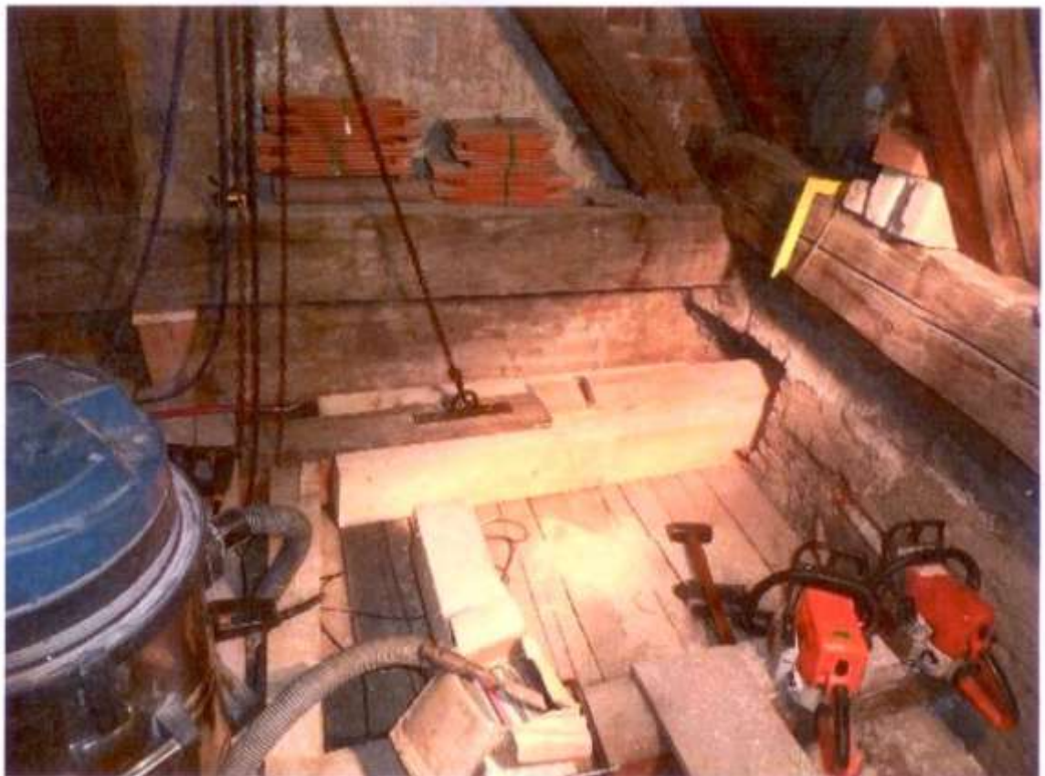
Protézování stropních trámů
