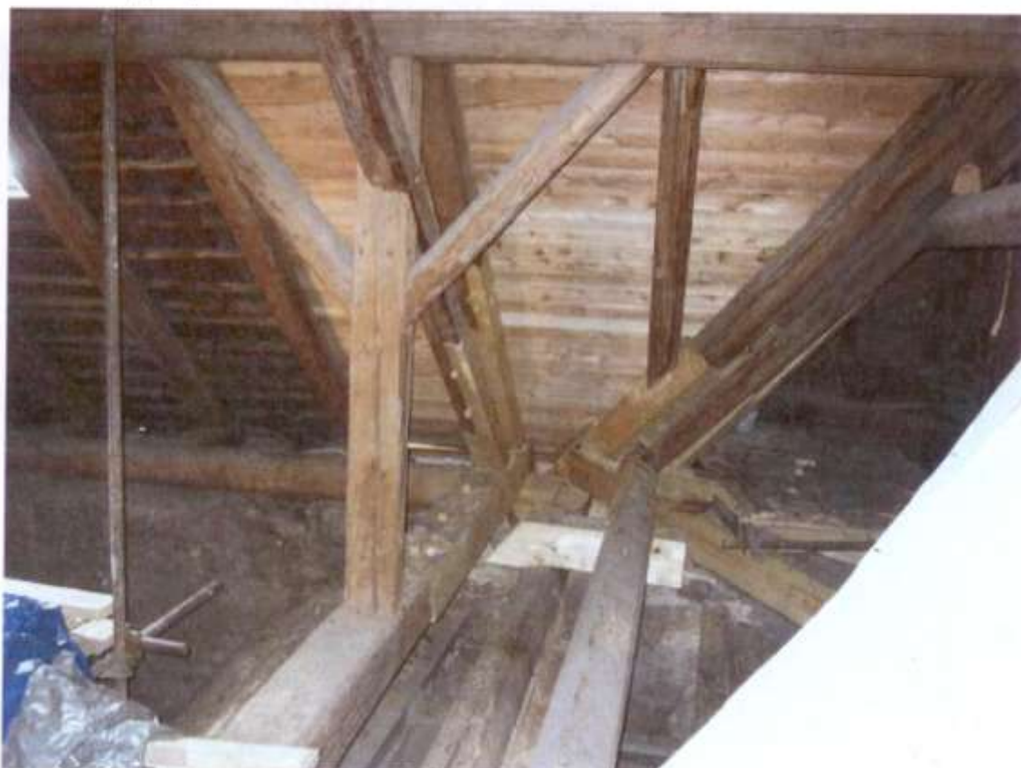
JV úžlabí po opravě – r.2011
