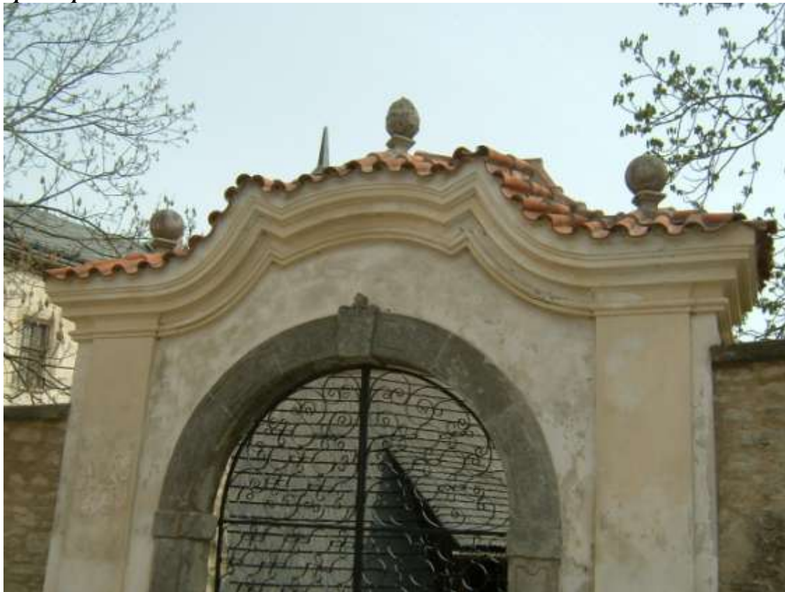
Stav před opravou
