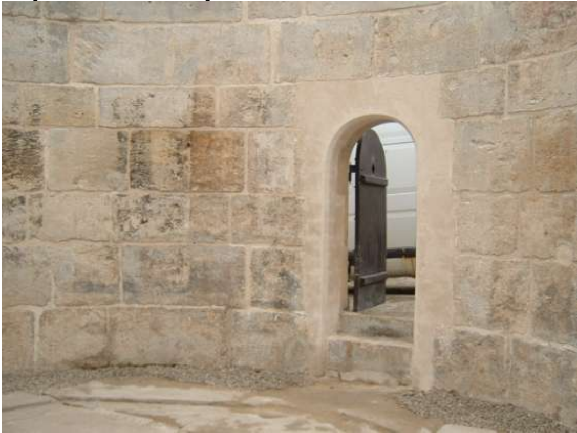
Stav po restaurování – vnitřní prostor
