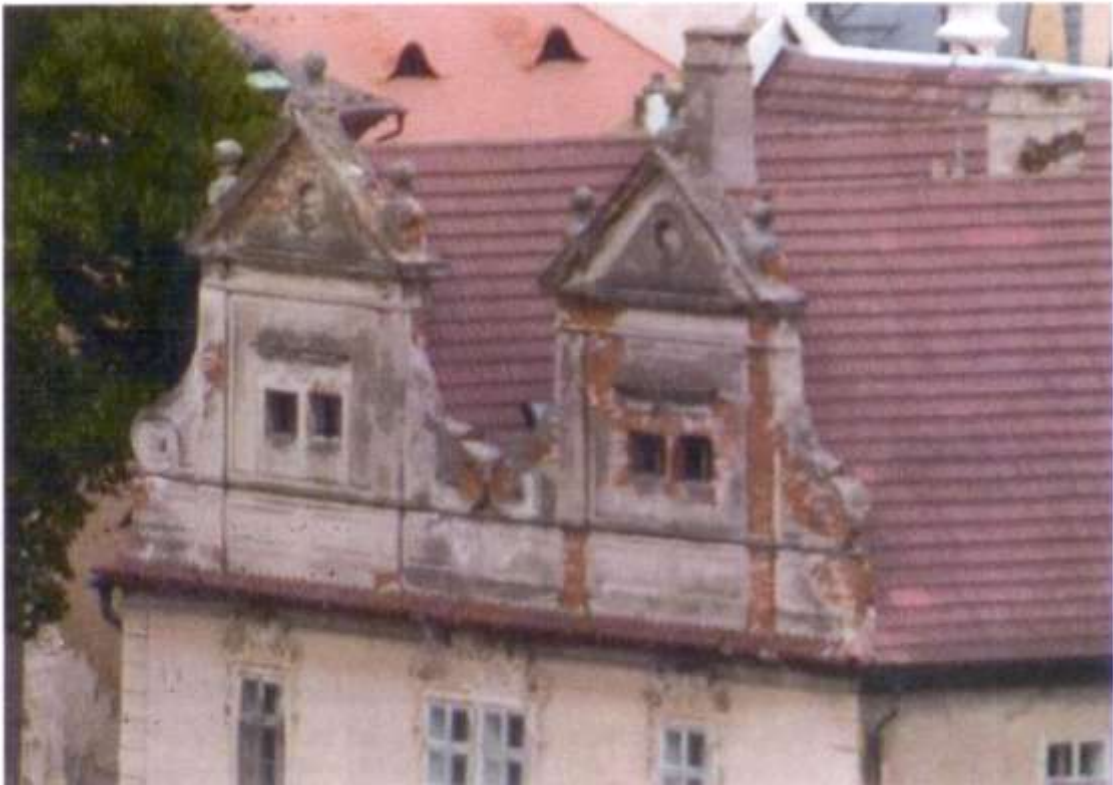
Západní štít před opravou
