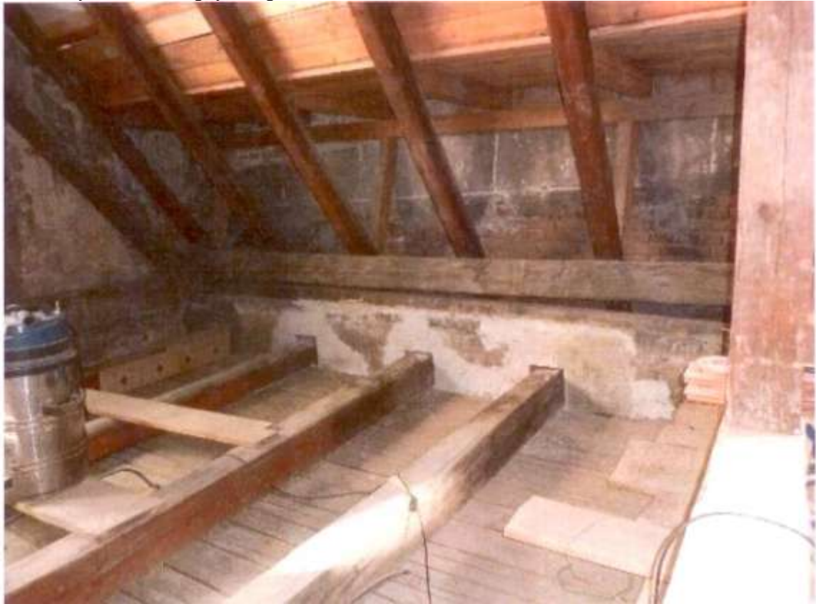
Protézování stropních trámů
