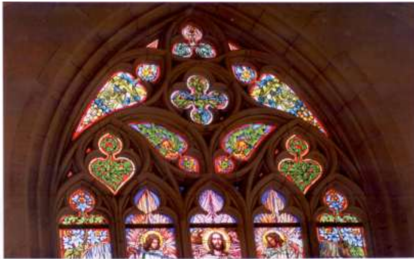
Horní část restaurované a nově osazené vitráže
