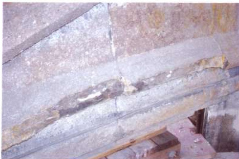
Kutná Hora, chrám sv. Barbory, restaurování a oprava vnějšího pláště – úsek 5A Havarijní stav spodního opěrného oblouku OsL S6. září 2009
