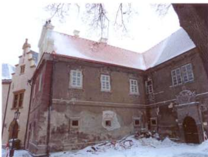
Střecha budovy arciděkanství po opravě v r. 2010
