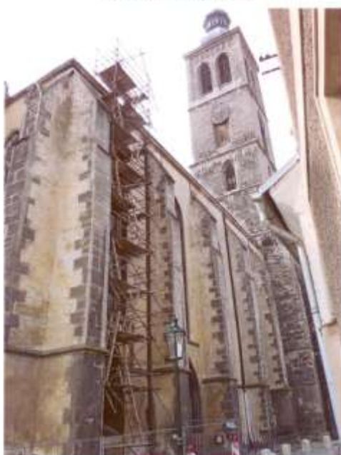
Kostel sv.Jakuba před opravou – stavba lešení r.2010
