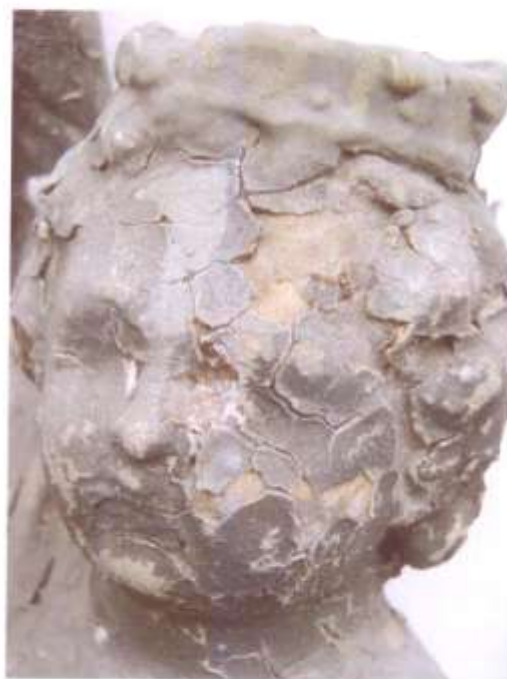
detaily poškození – povrchová vrstva nátěrů se odděluje s vrstvou kamene
