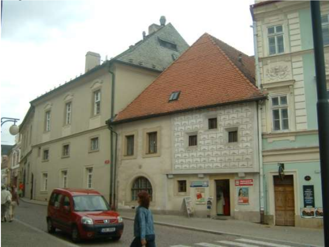
Stav před obnovou
