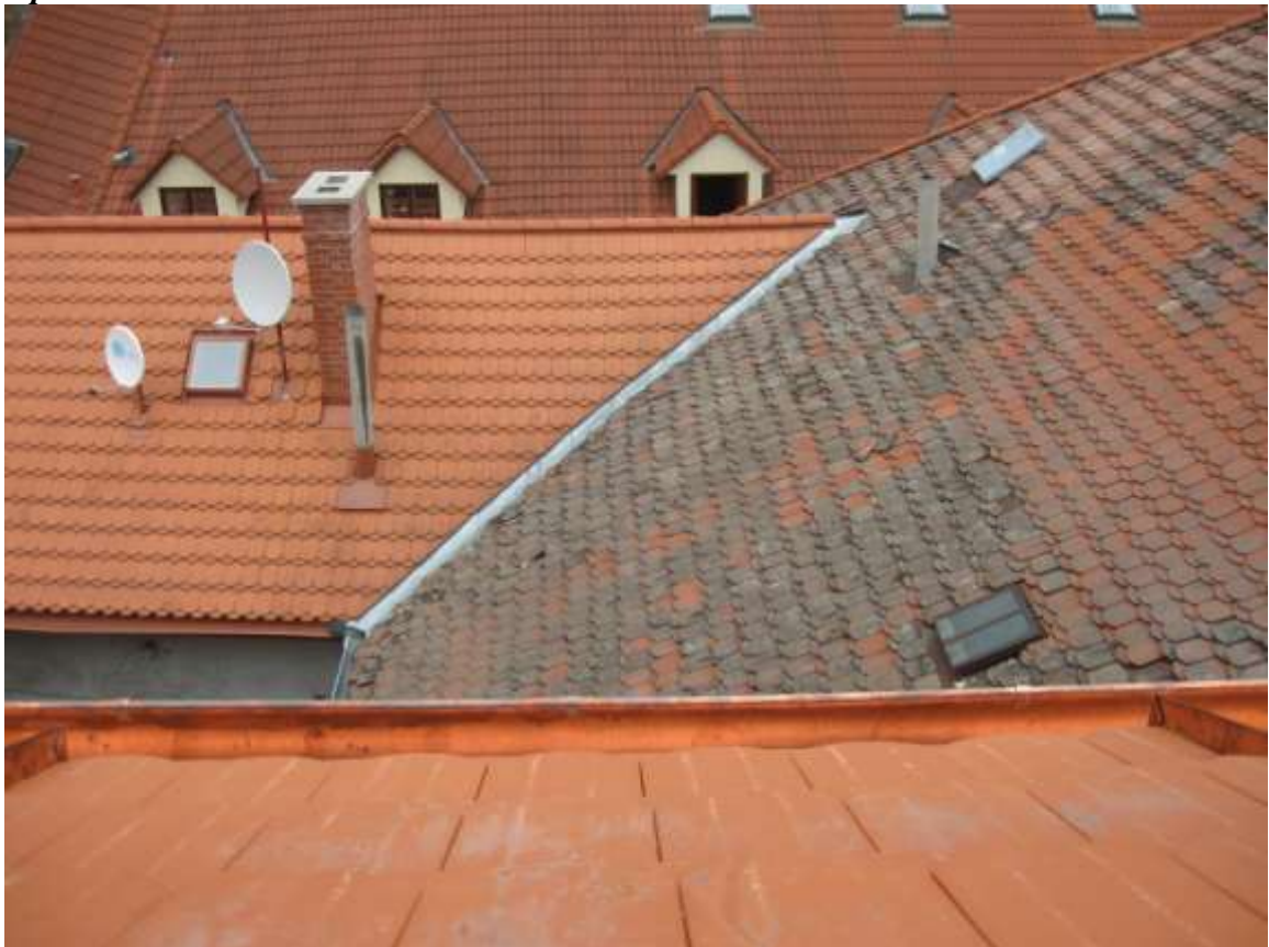
Stav po obnově – ze dvora
