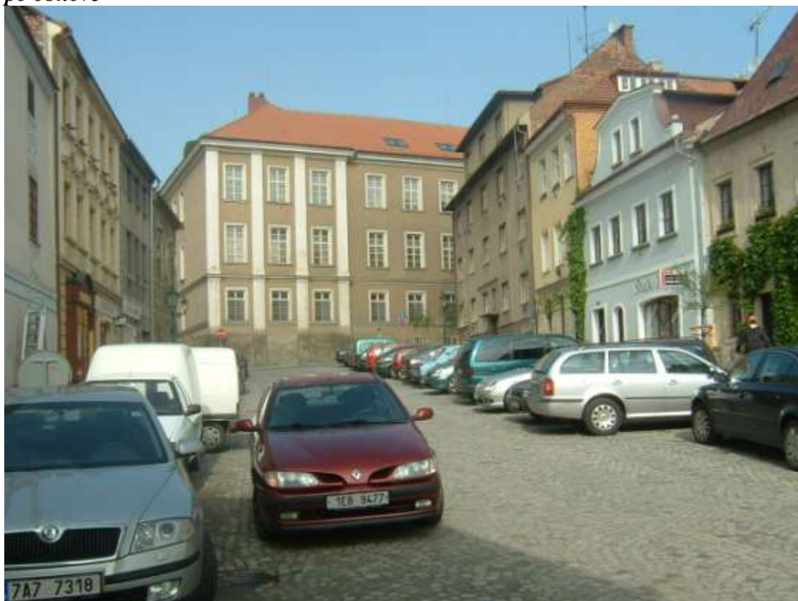
Stav po obnově
