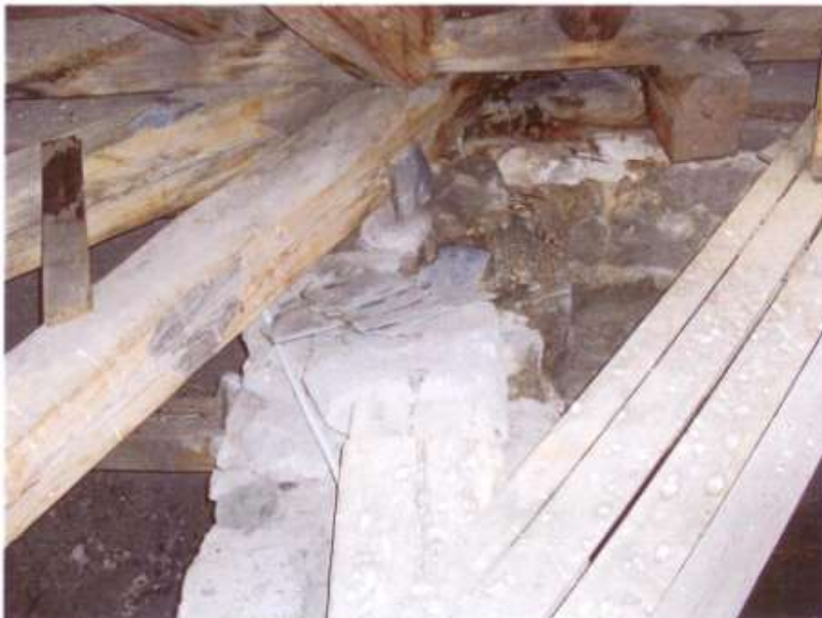
Stav tesařských konstrukcí před opravou – r.2010
