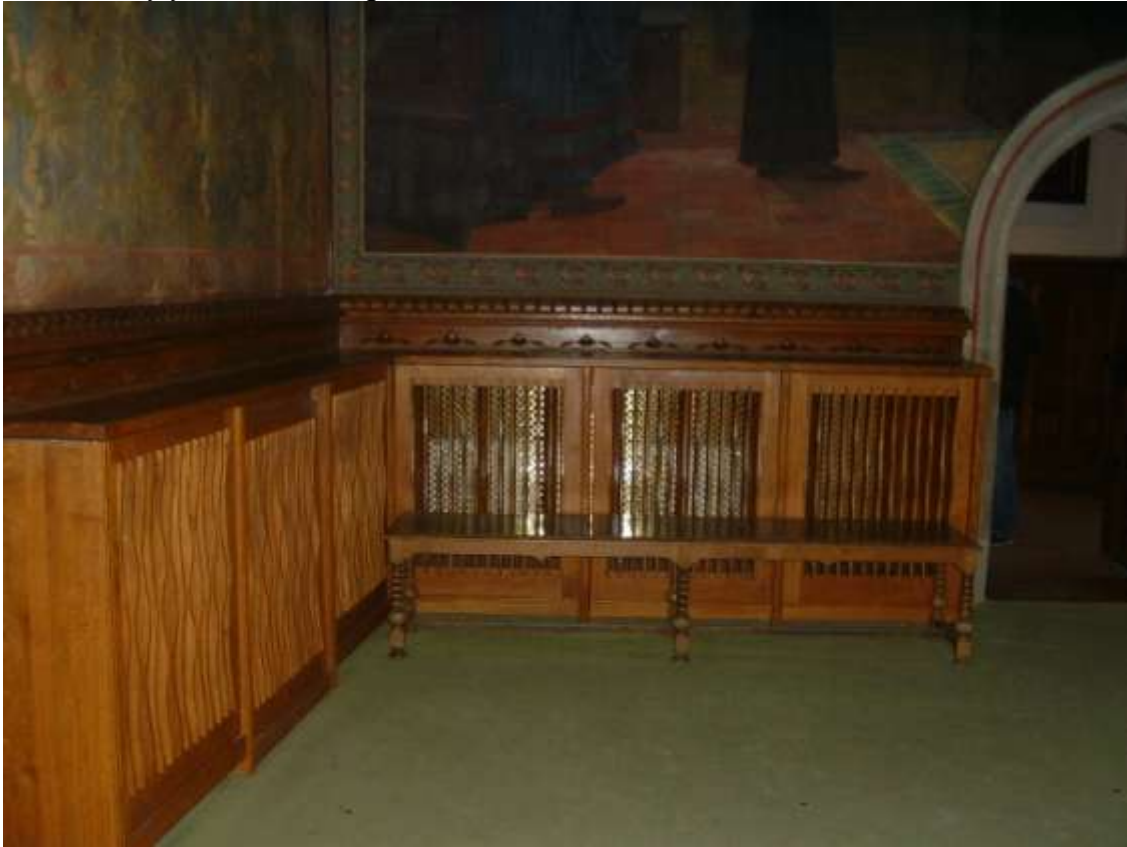
Původní kryty ústředního topení
