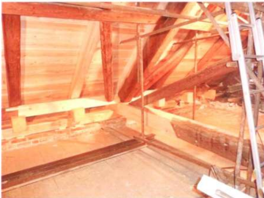
Opravená plná vazba – r. 2010
