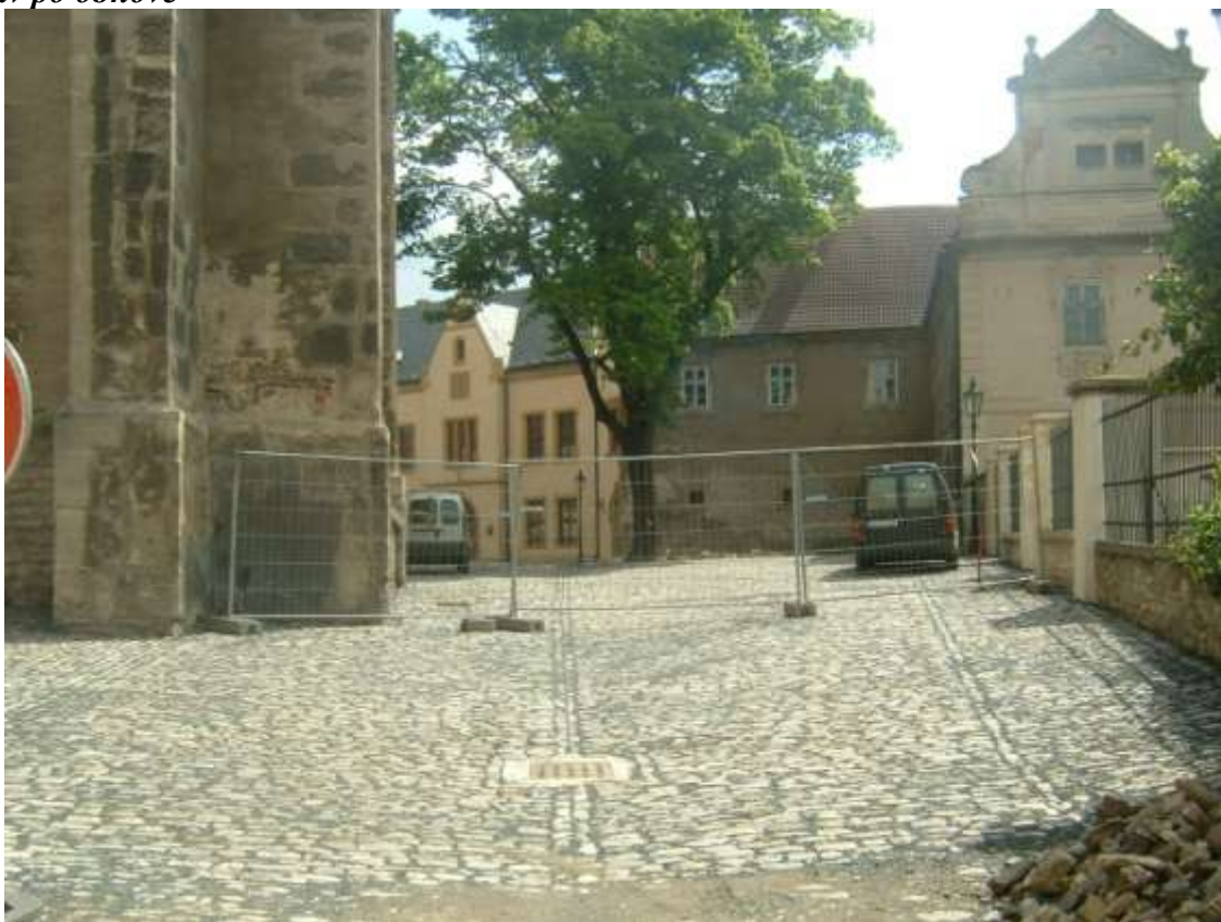
Stav po obnově
