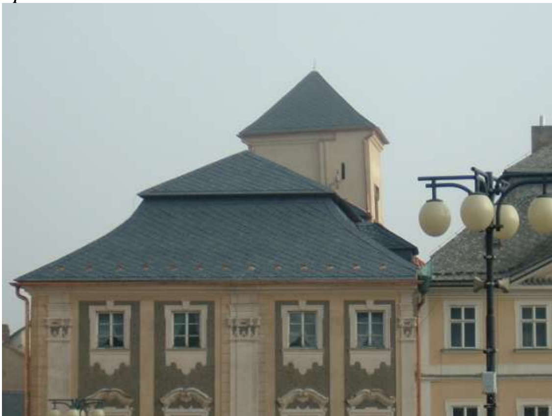
Stav po obnově
