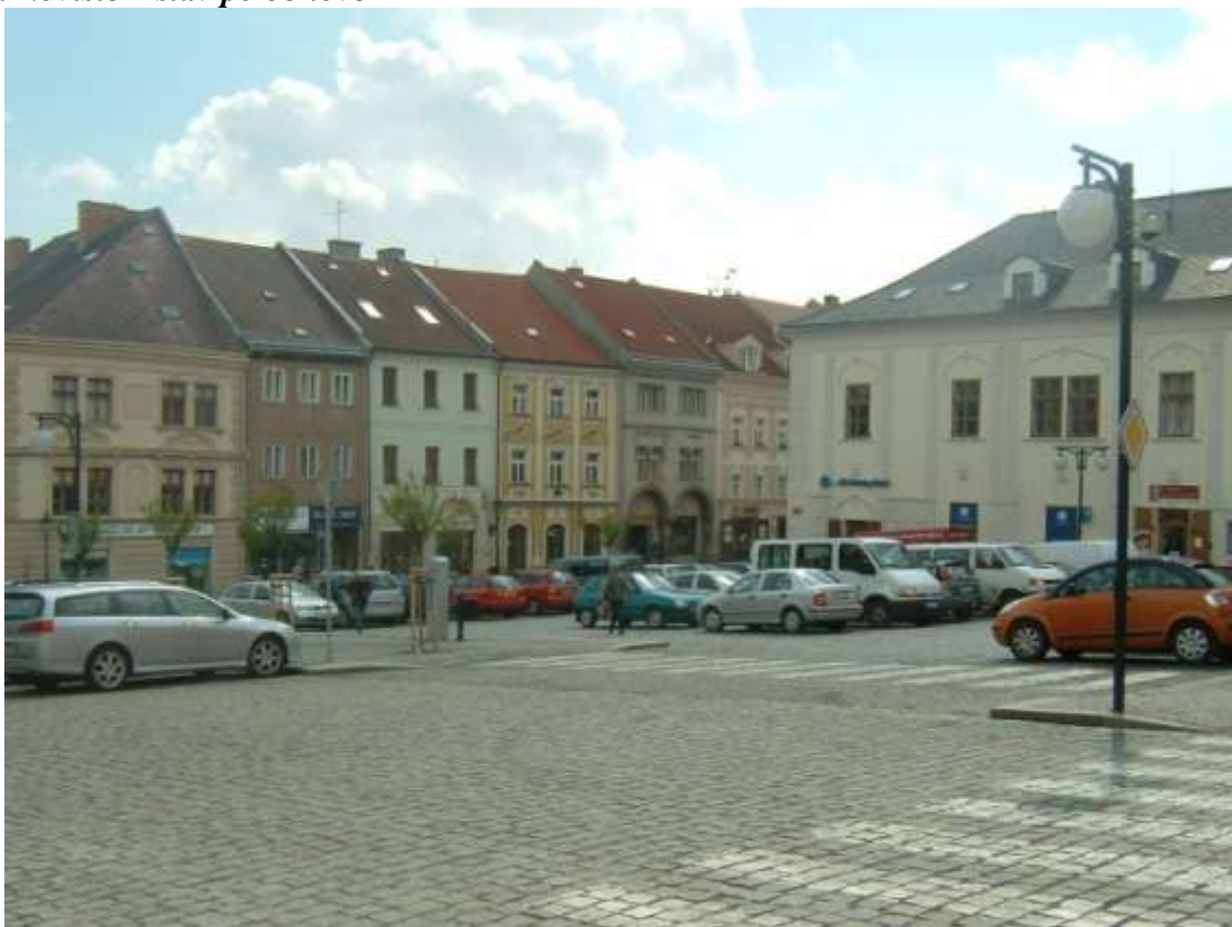
Parkoviště – stav po obnově
