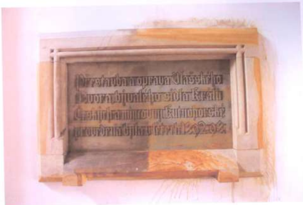
15. Pamětní deska přestavby, průběh čištění
