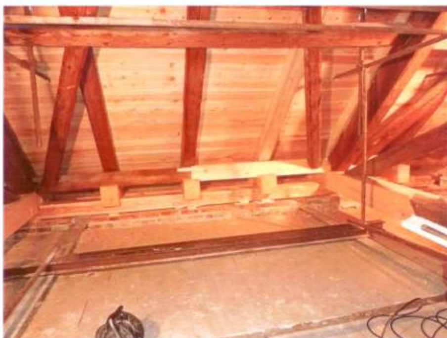
Opravené plné pole včetně podbití, VT, PO, KR – r. 2010
