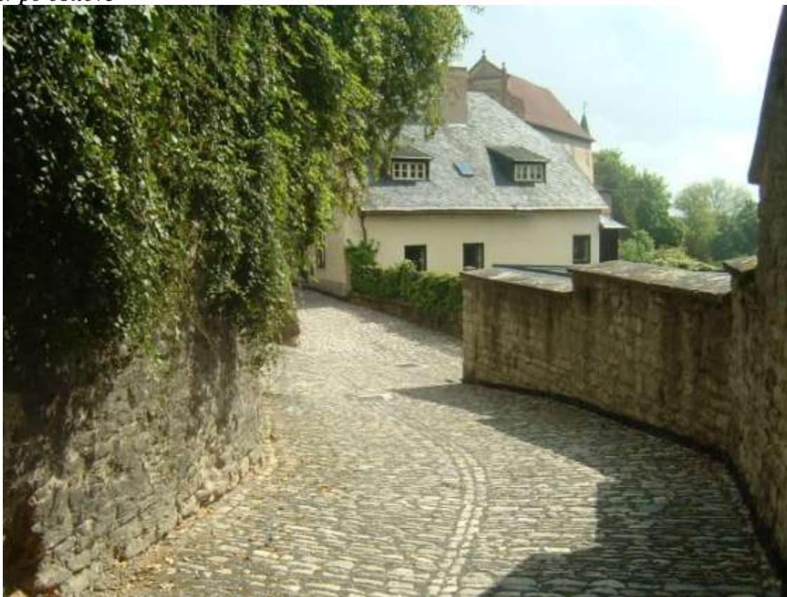
Stav po obnově
