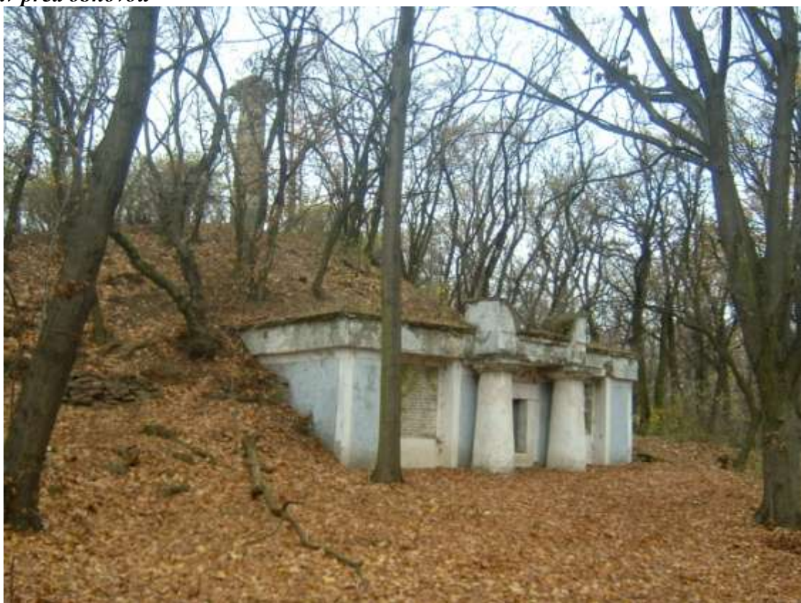
Stav před obnovou
