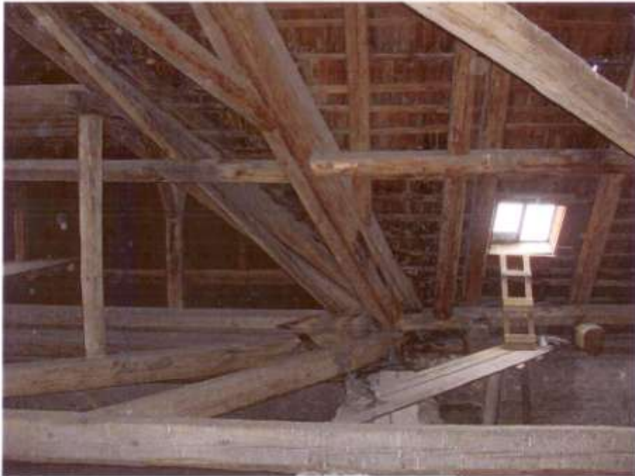
Stav tesařských konstrukcí před opravou – r.2010
