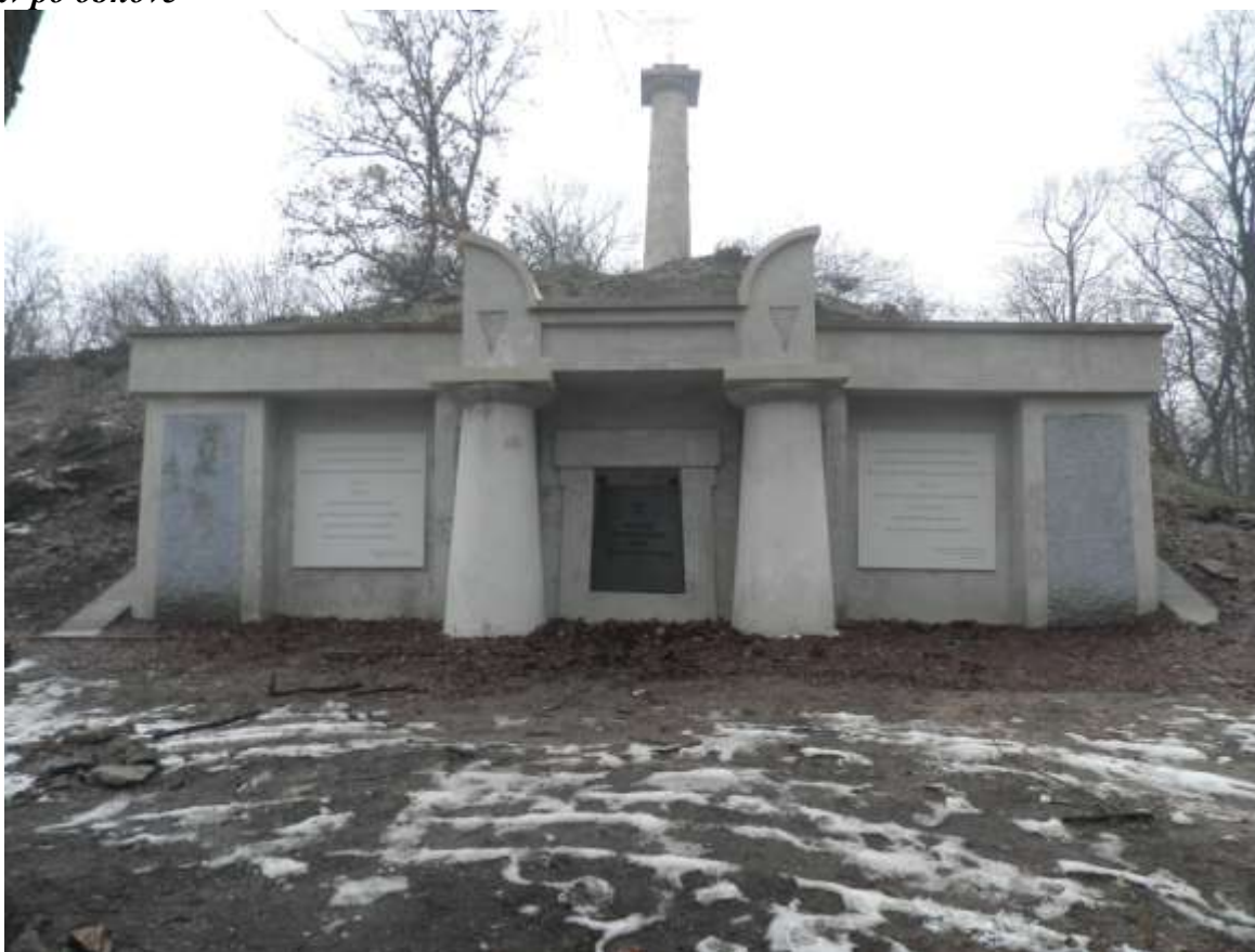
Stav po obnově
