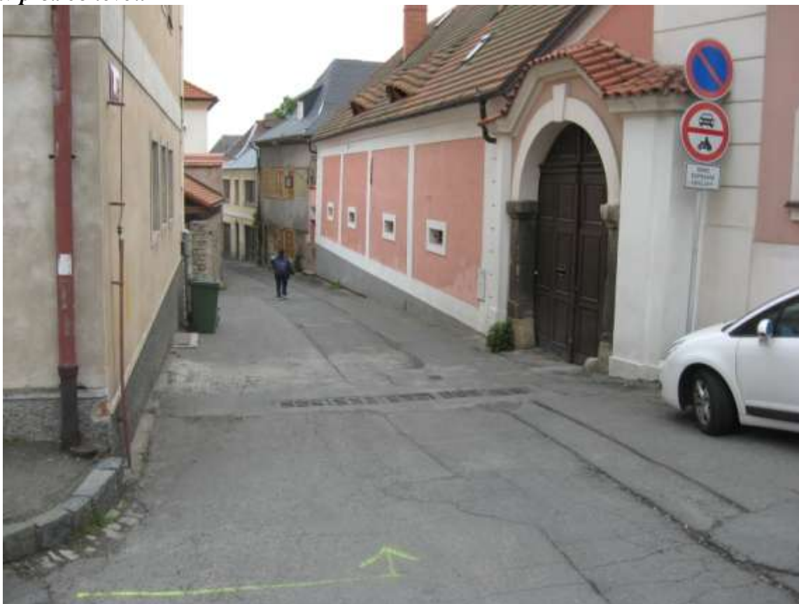
Stav před obnovou
