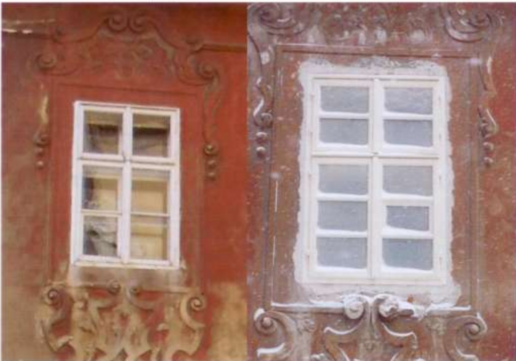
Příklad okna před a po výměně v r. 2010
