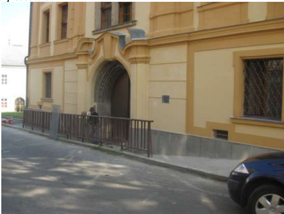
Stav před obnovou
