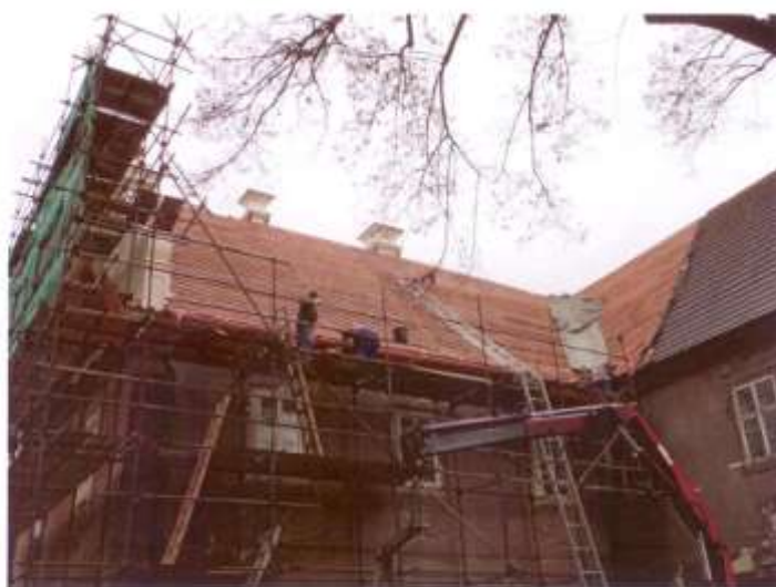
Střecha budovy arciděkanství v průběhu oprav v r. 2010
