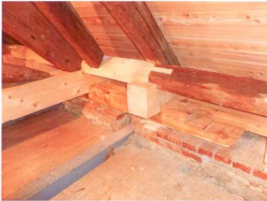
Oprava pozednice – r.2010
