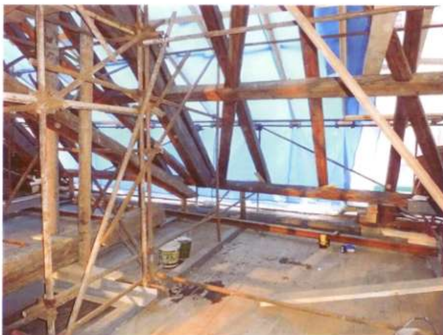
Konstrukce krovy zvednutá hevery, výměna pozednice, kroví, krácat – r.2010
