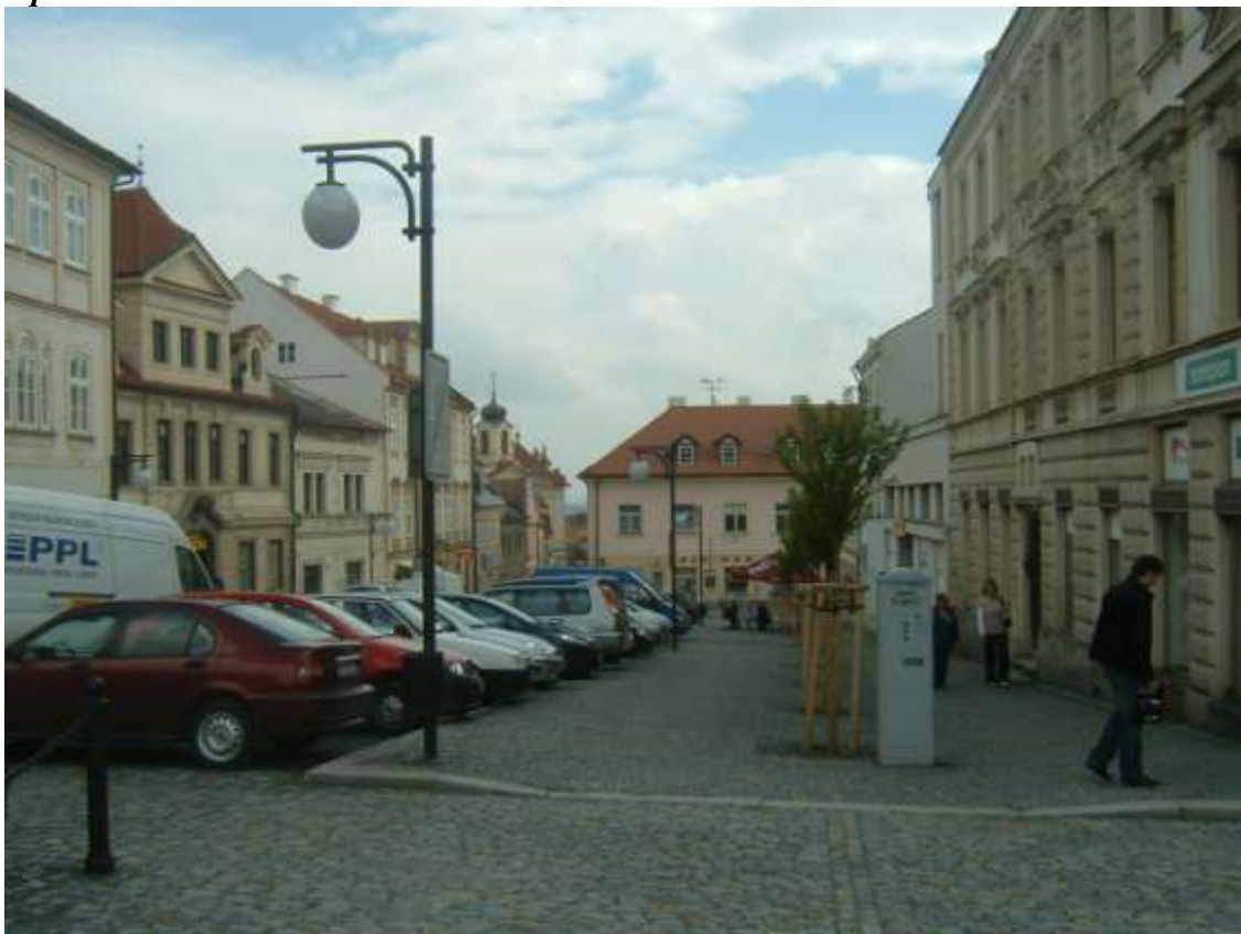
Stav po obnově
