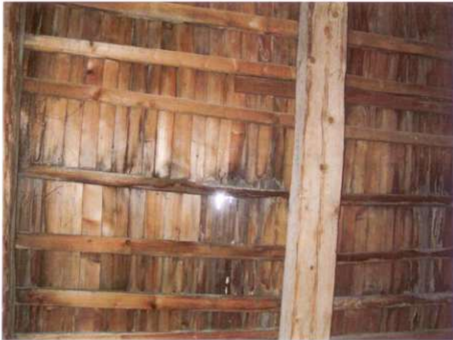
Stav podbití krytiny před opravou – r.2010
