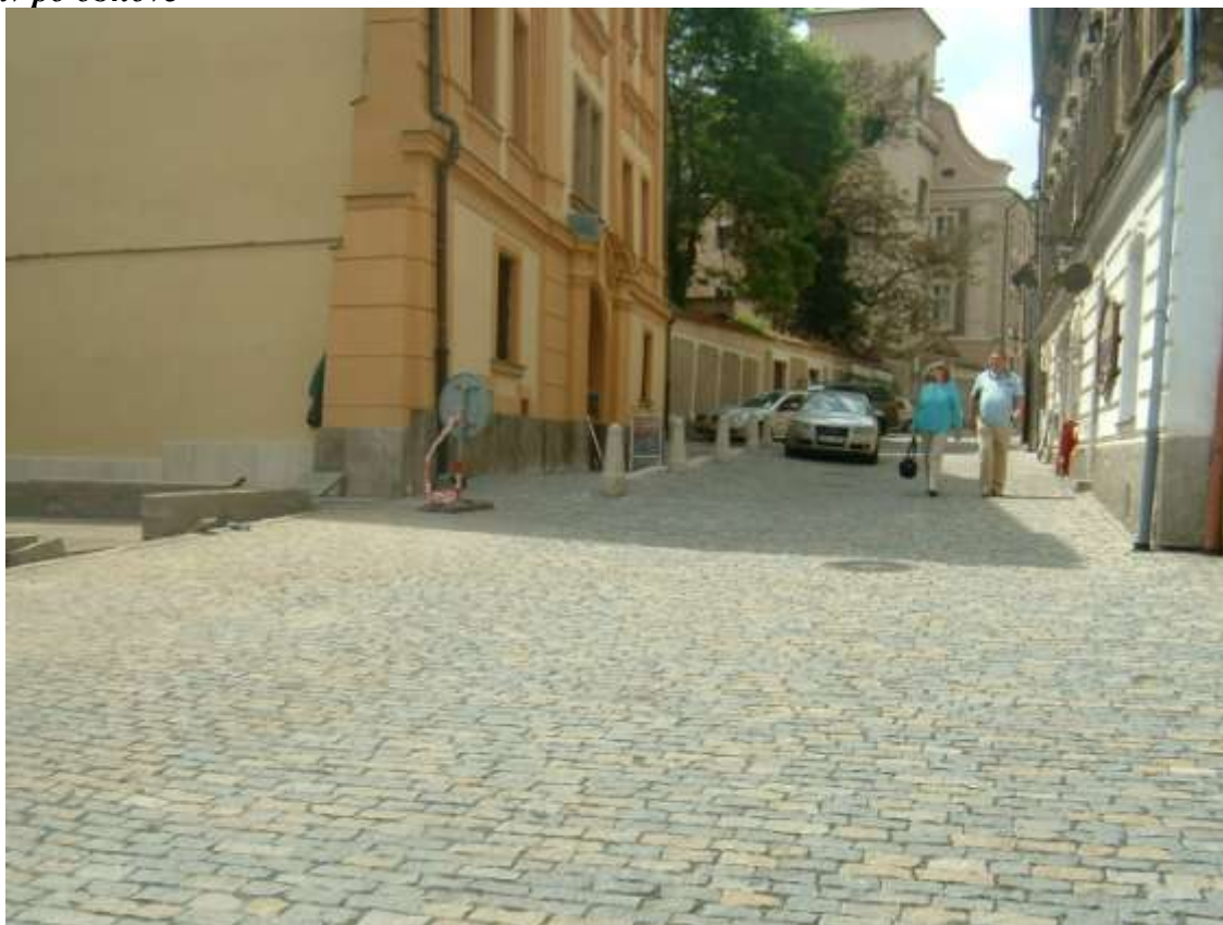
Stav po obnově
