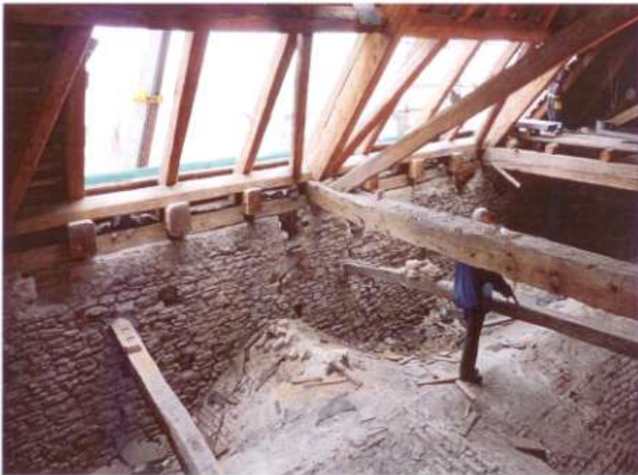
Odkrytí montážního otvoru – r. 2010
