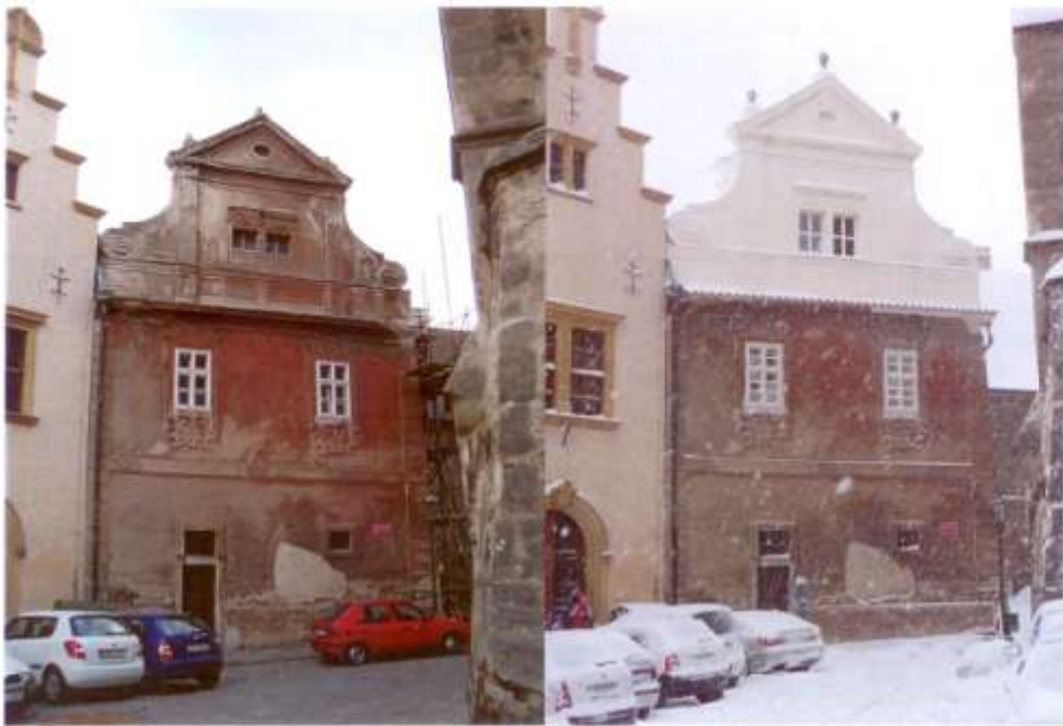
Štít severního křídla před a po opravě v r. 2010
