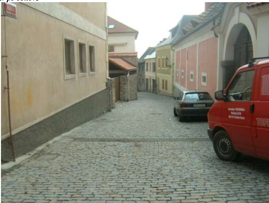
Stav po obnově
