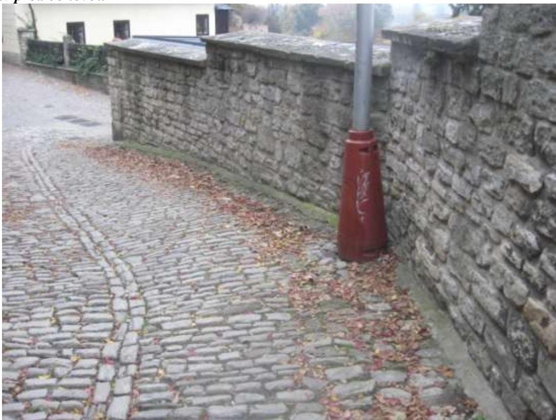
Stav před obnovou
