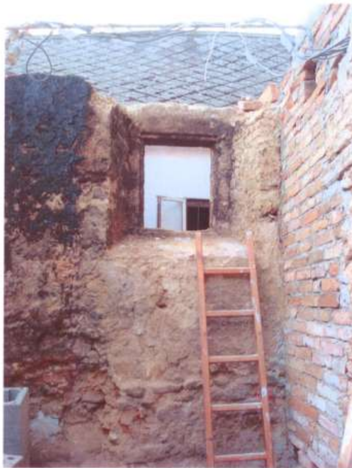
Stav kamenného okna před restaurováním a po restaurování
