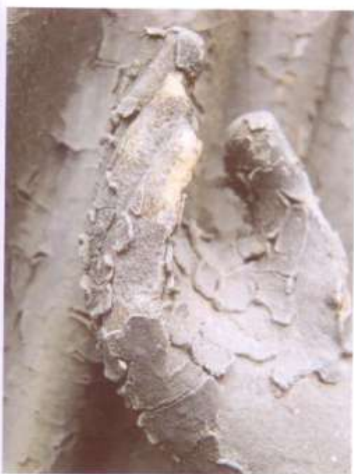
detaily poškození – povrchová vrstva nátěrů se odděluje s vrstvou kamene
