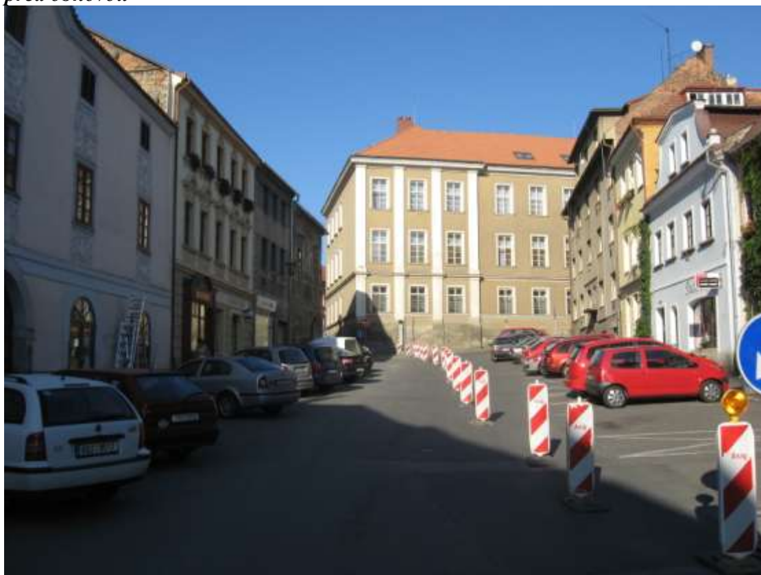
Stav před obnovou
