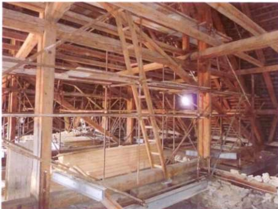
Stavba heverovacího lešení – r. 2010
