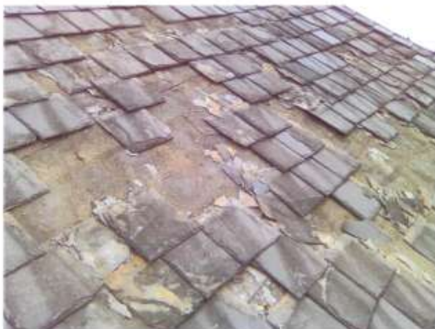
Střecha kostela před opravou – r.2010
