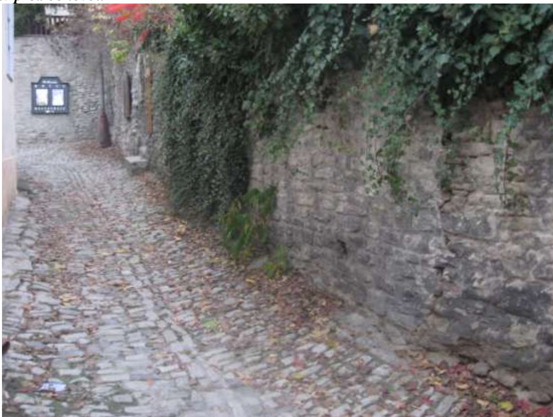
Stav před obnovou
