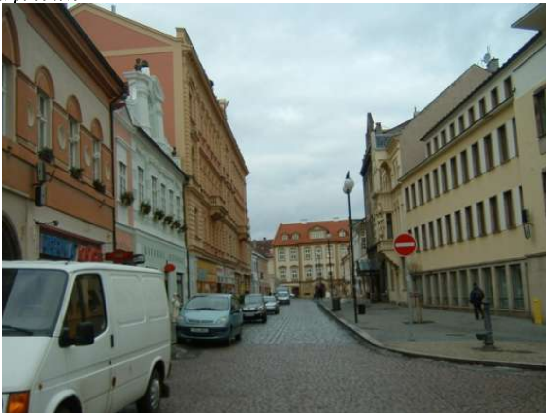
Stav po obnově
