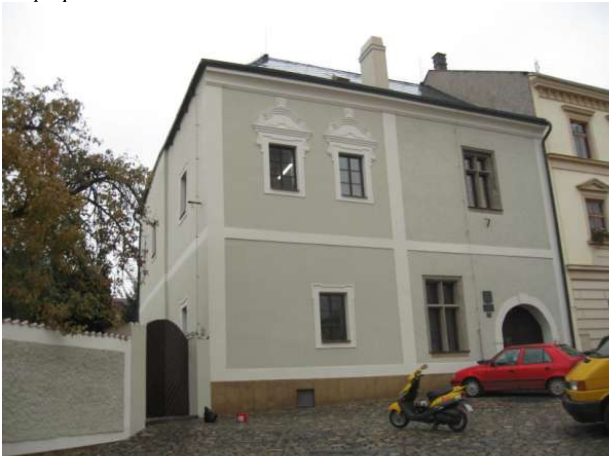
Stav po opravě
