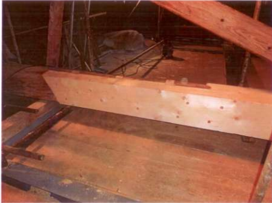
Opravený vazný trám – r.2010
