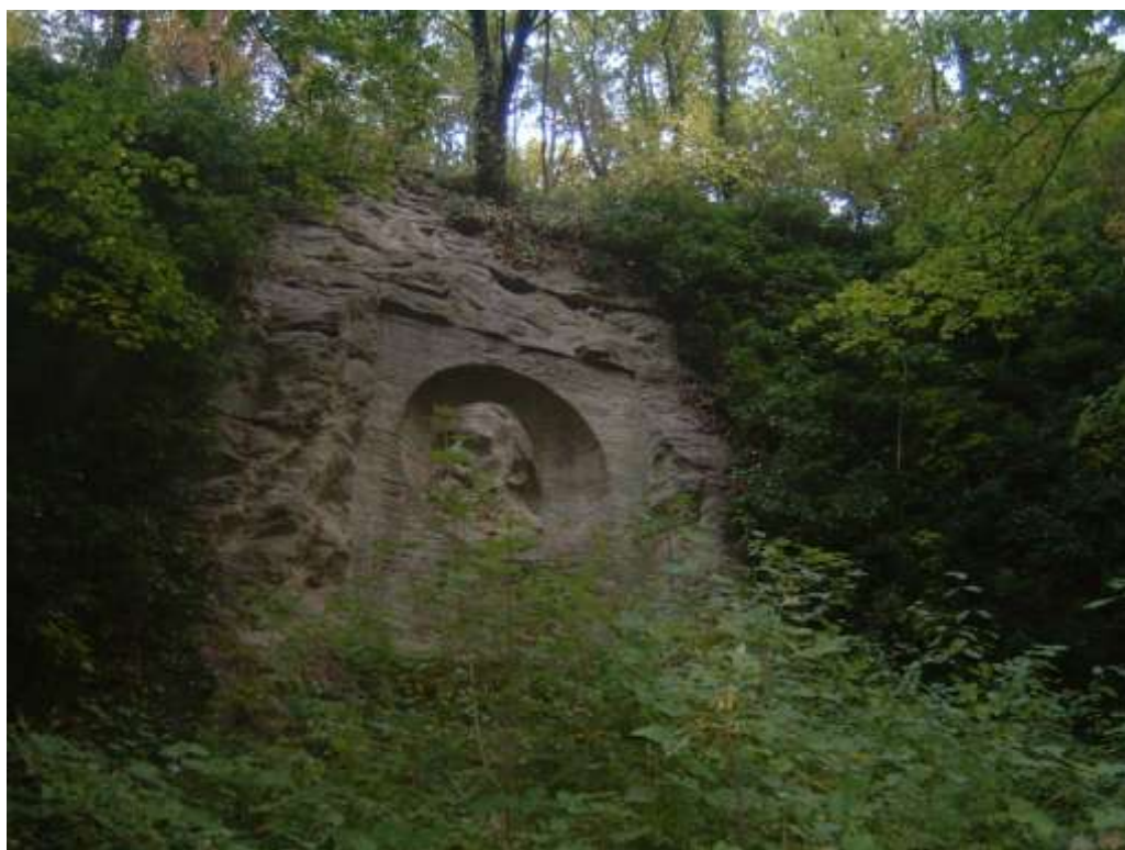
Stav po restaurování
