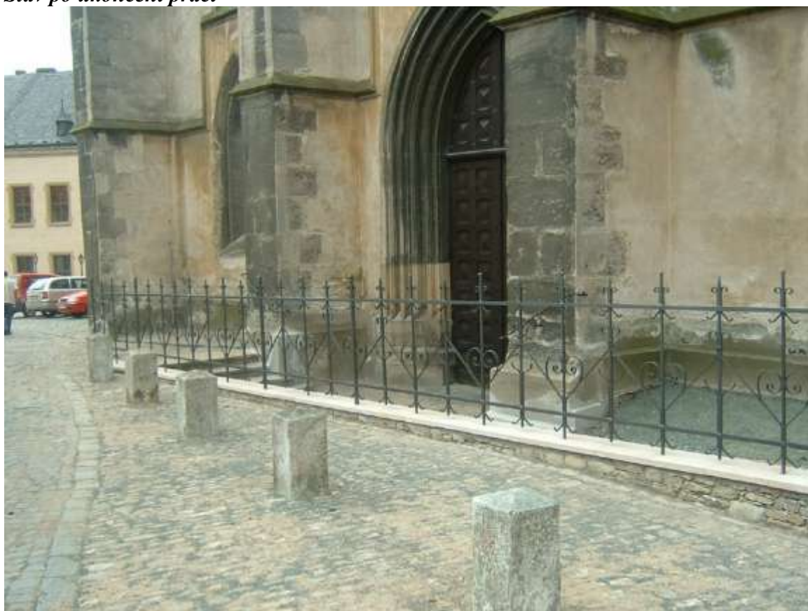
Stav po ukončení prací
