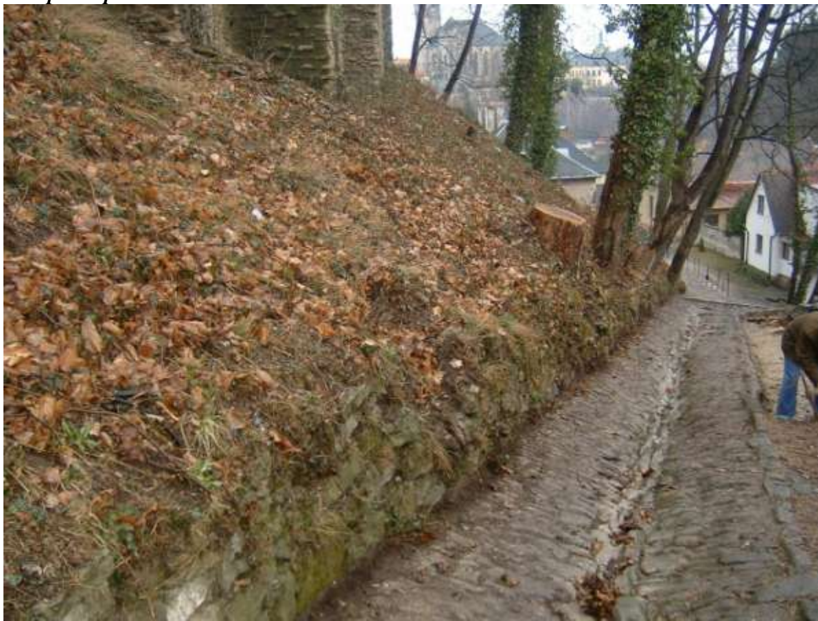
Stav před opravou
