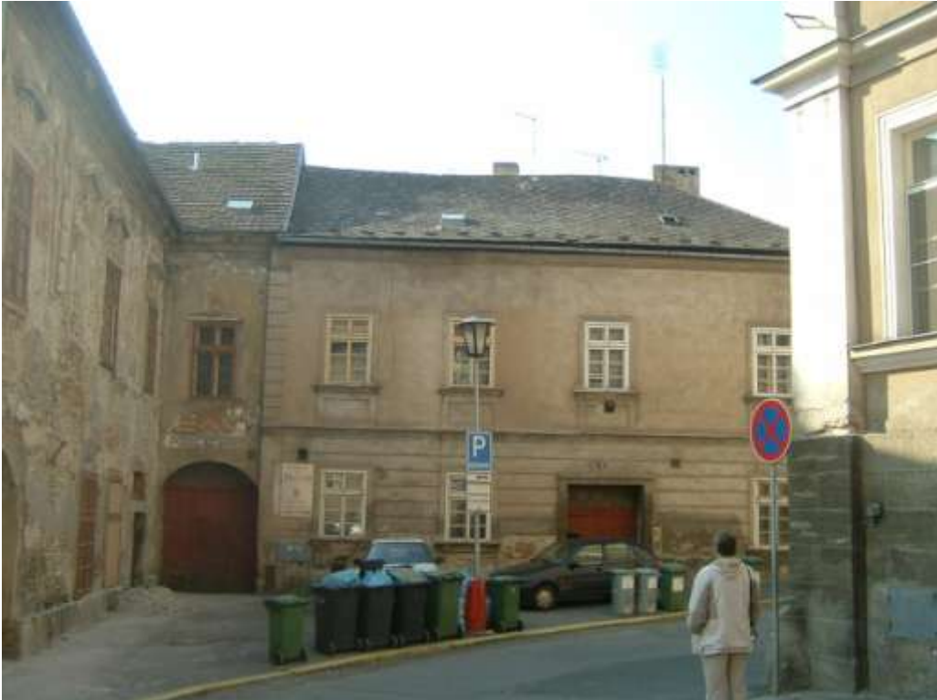
Stav před obnovou
