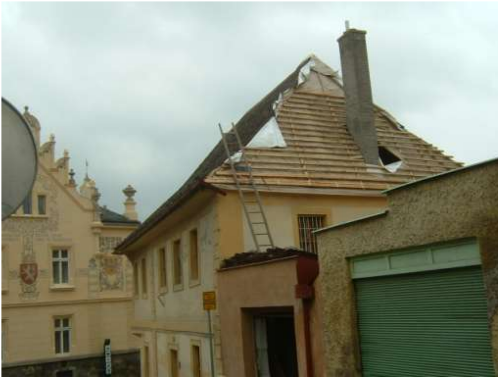
Stav po obnově
