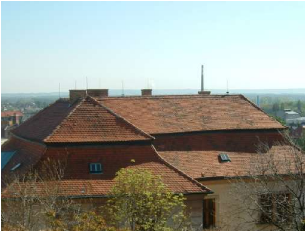
Stav před obnovou střešního pláště
