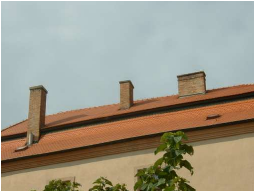
Stav po obnově střešního pláště
