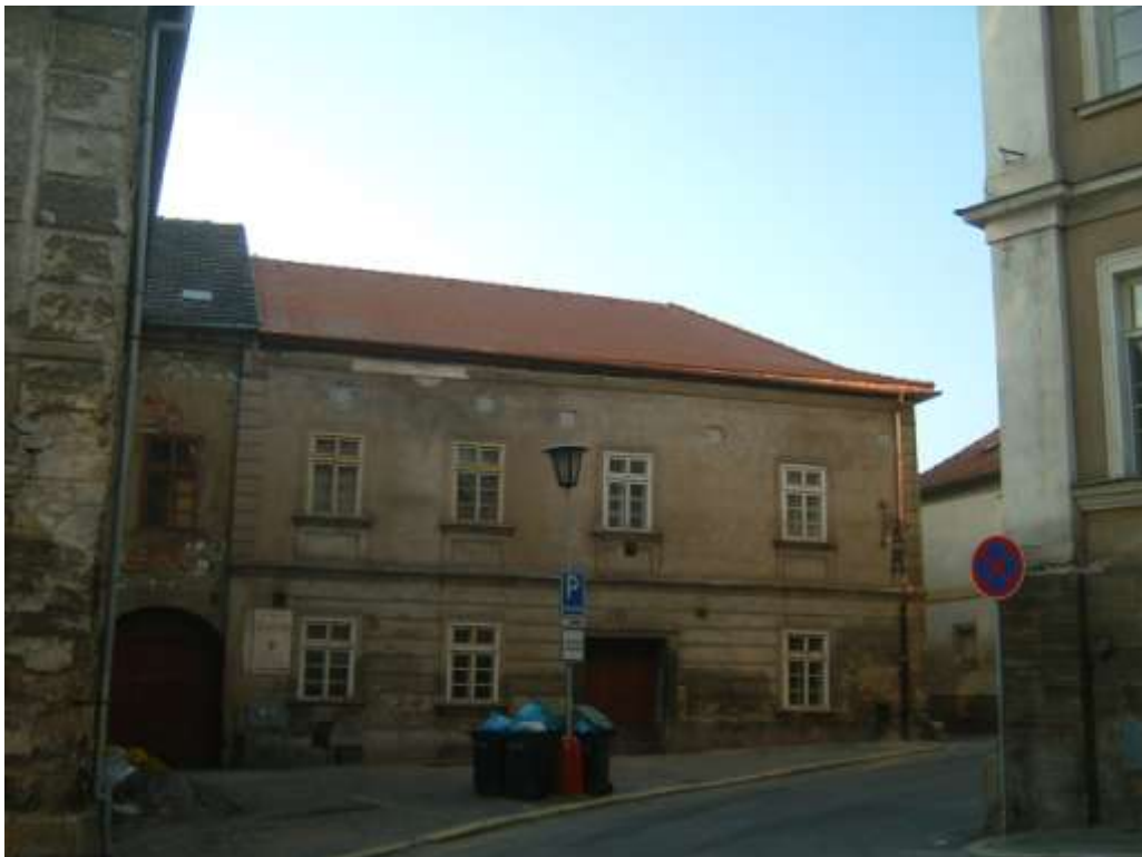
Stav po obnově
