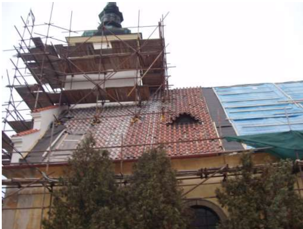
Stav v průběhu rekonstrukce
