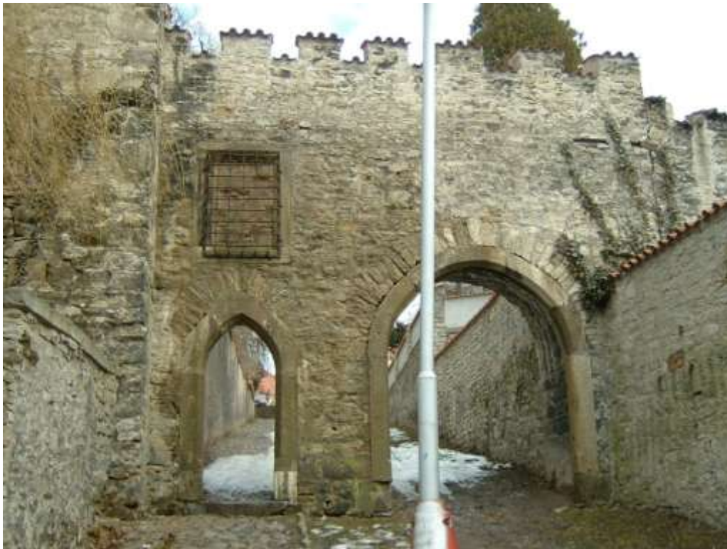
Stav před opravou brány
