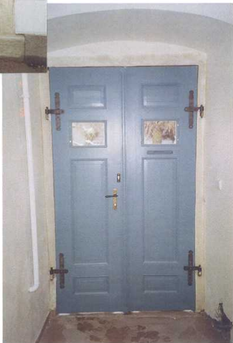
Čp. 34 Barborská ulice, Kutná Hora Stav vstupních dveří po obnově
