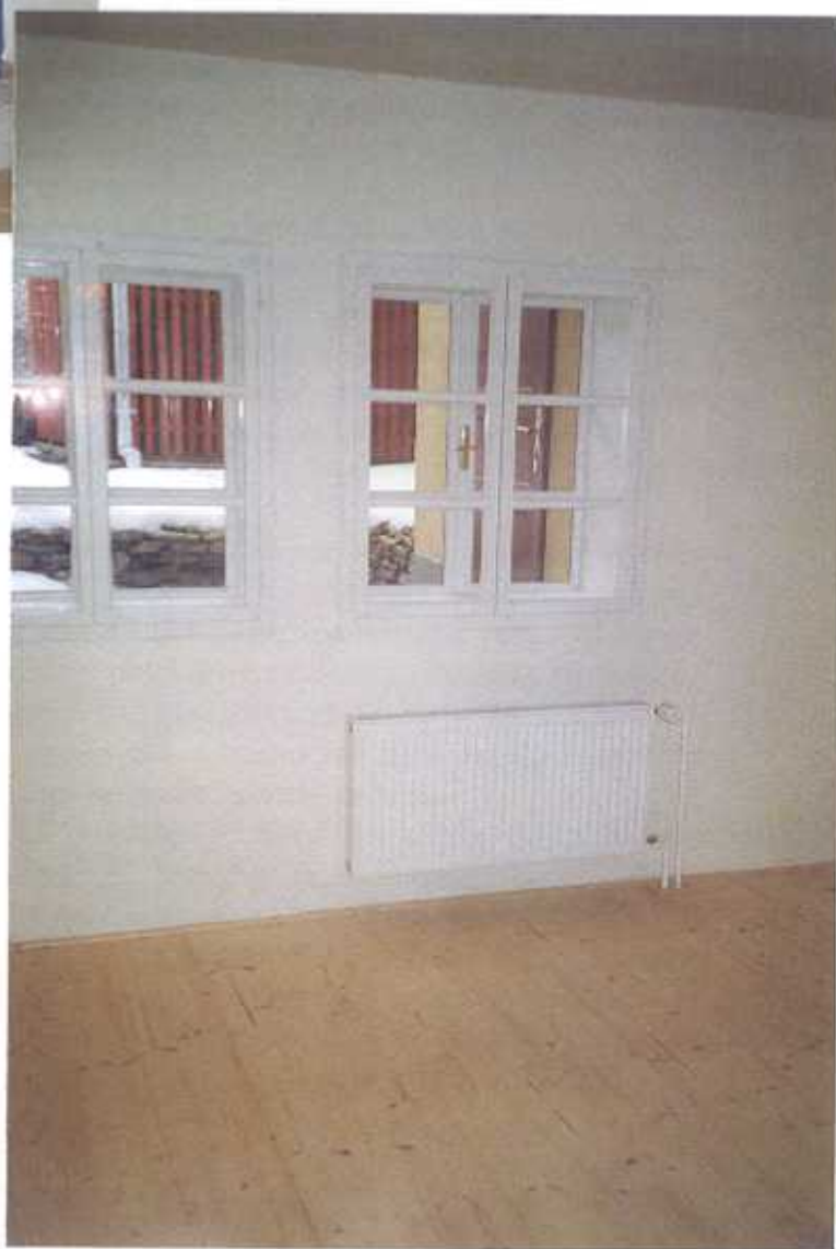
Čp. 34 Barborská ulice, Kutná Hora Stav interiéru po obnově
