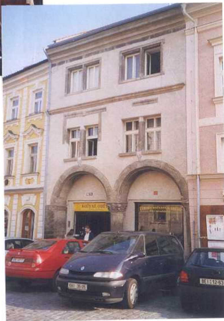
Čp.166 Šultysova ulice, Kutná Hora Stav fasády před obnovou a po obnově
