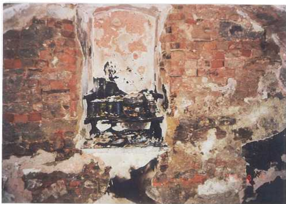
Čp. 77 Vysokostelská ulice, Kutná Hora Stav přízemí objektu před obnovou
