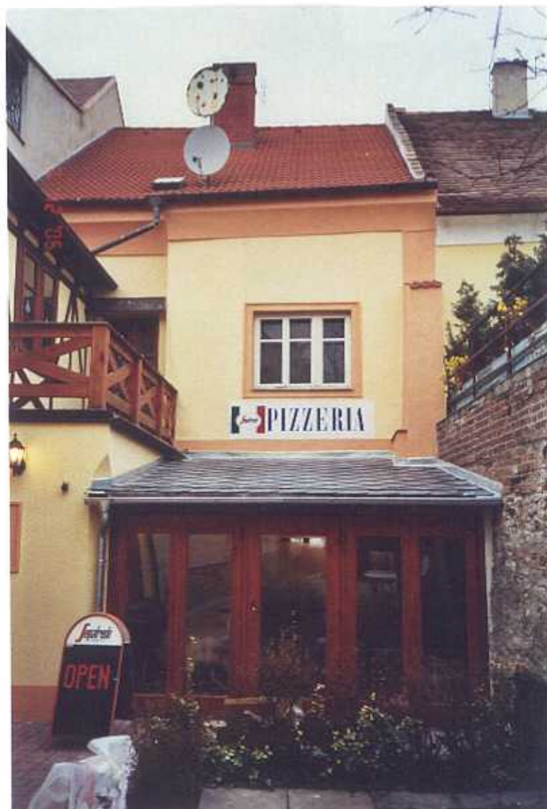
Čp. 90 Palackého náměstí, Kutná Hora Stav fasády po obnově
