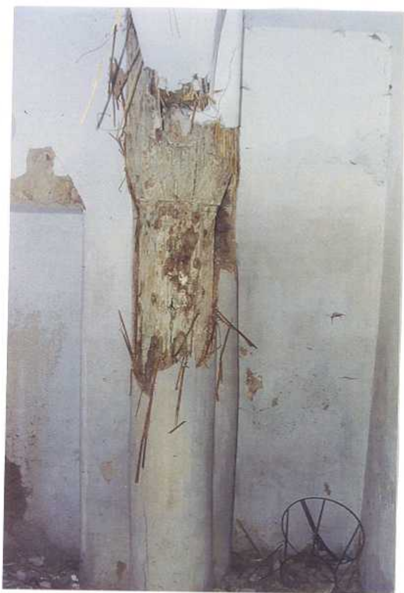
Čp. 34 Barborská ulice, Kutná Hora Dřevěný sloup trámového průvlastu v přízemí – stav před obnovou
