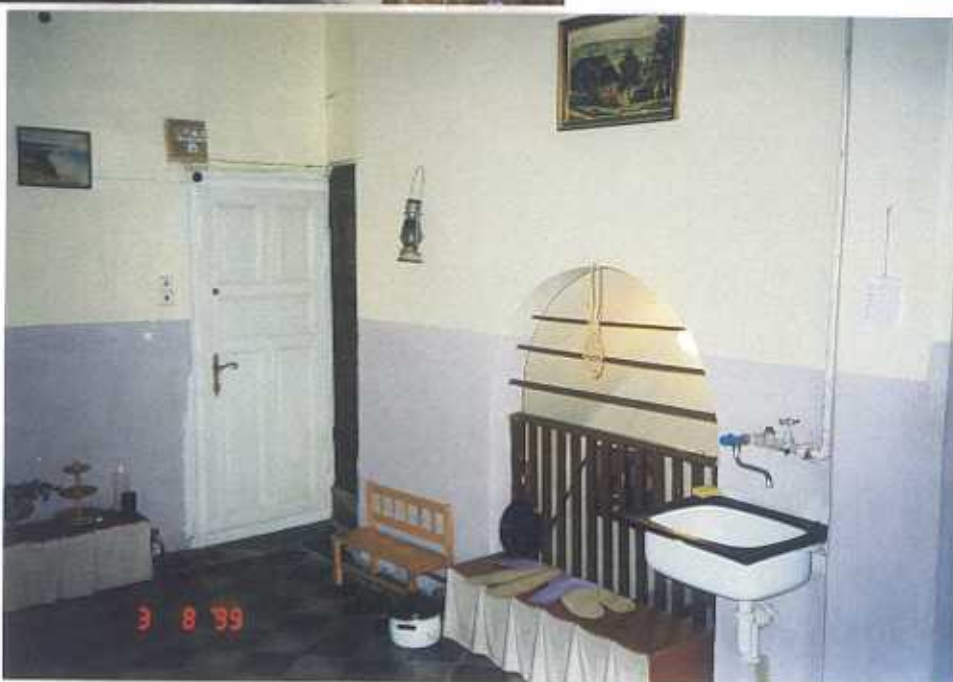
Čp. 34 Barborská ulice, Kutná Hora Stav interiéru před obnovou
