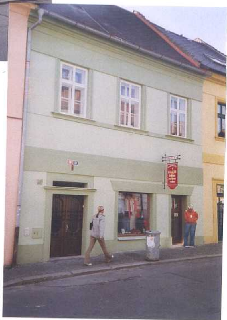
Čp. 20 Komenského náměstí, Kutná Hora Stav fasády před obnovou a po obnově
