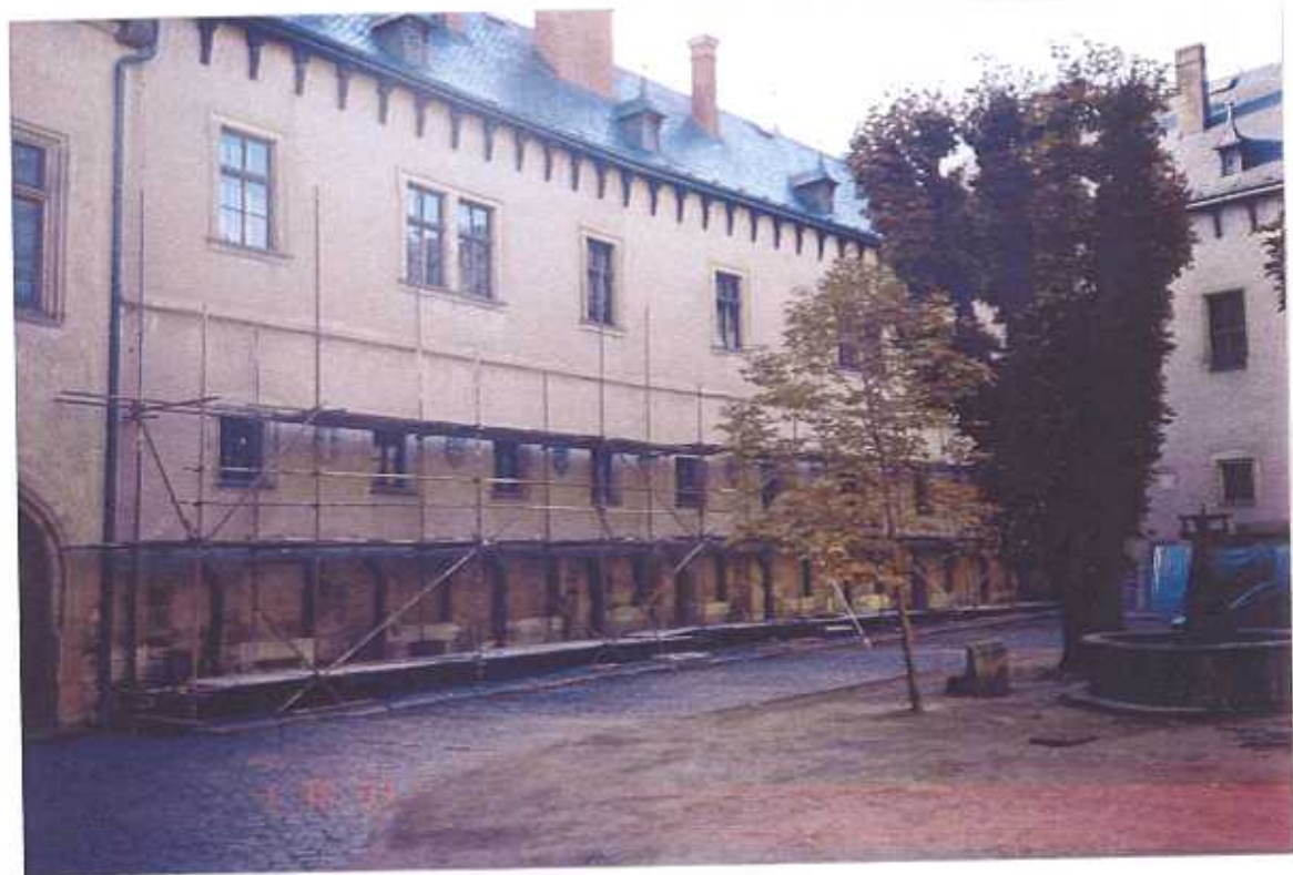
Stav fasád nádvoří Vlašského dvora před obnovou
