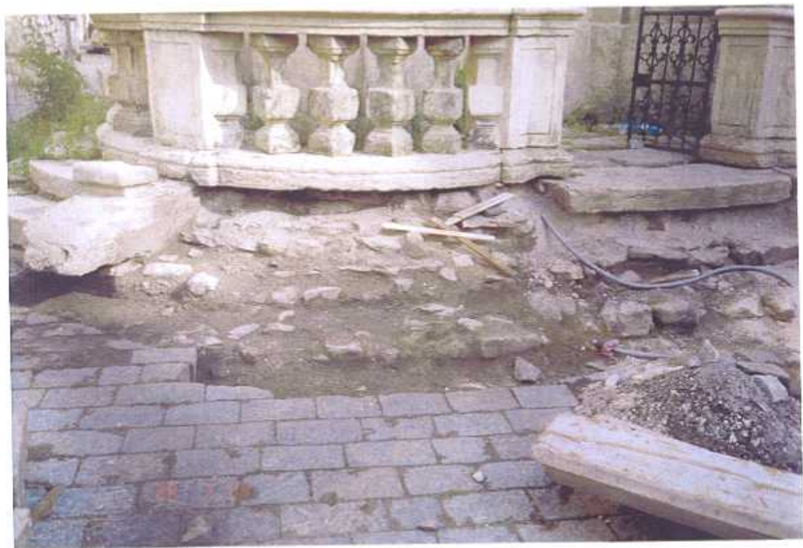
Morový sloup, Šultysova ulice, Kutná Hora průběh obnovy
