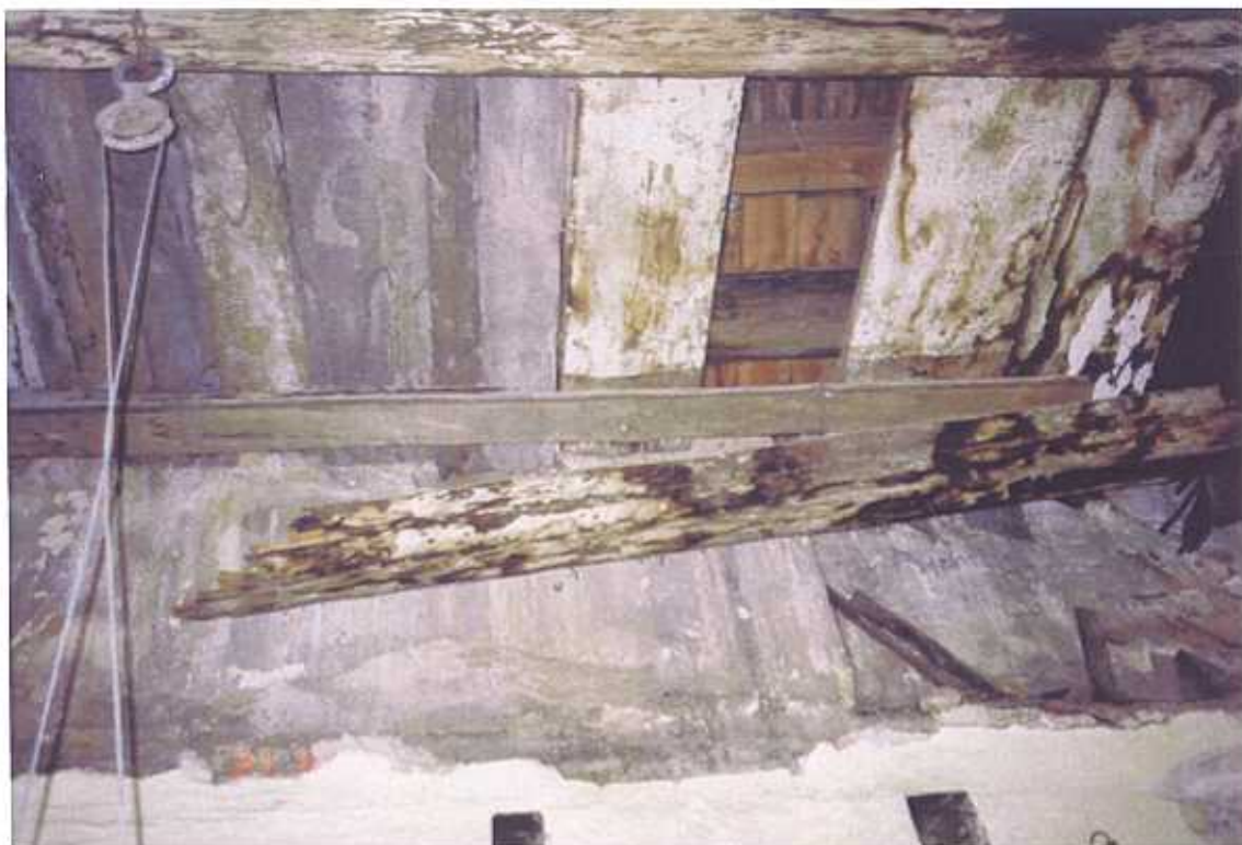
gotický záklopový strop v míst. 2.12 I. patro stav po odkrytí
