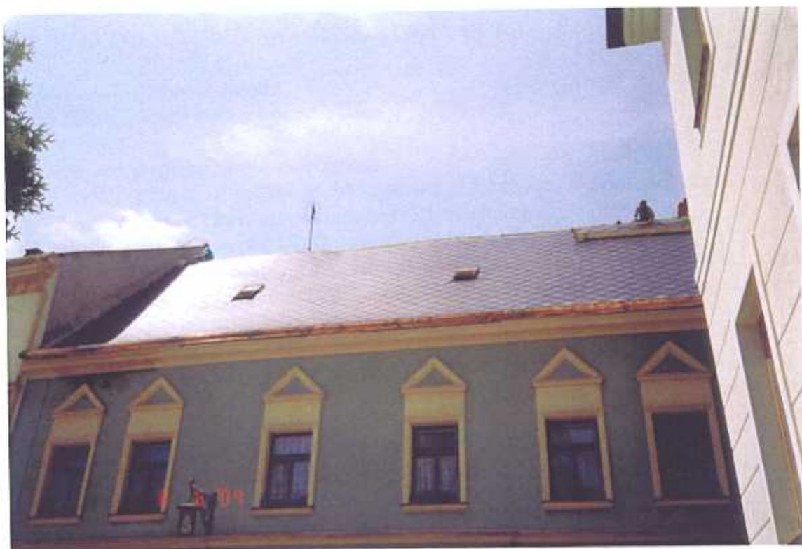
Dům čp. 18. Dačického náměstí, Kutná Hora stav střechy po obnově
