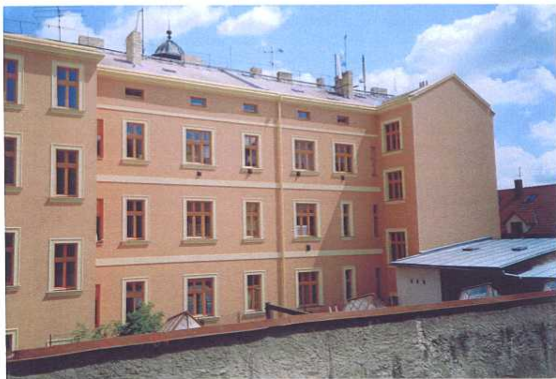
čp. 589, 590 Kollárova ulice, Kutná Hora stav dvorní fasády po obnově
