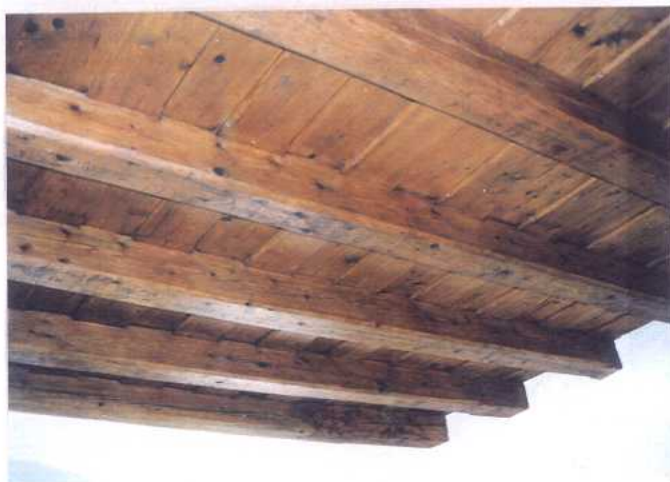
Celkový pohled na záklopový strop po zrestaurování.
