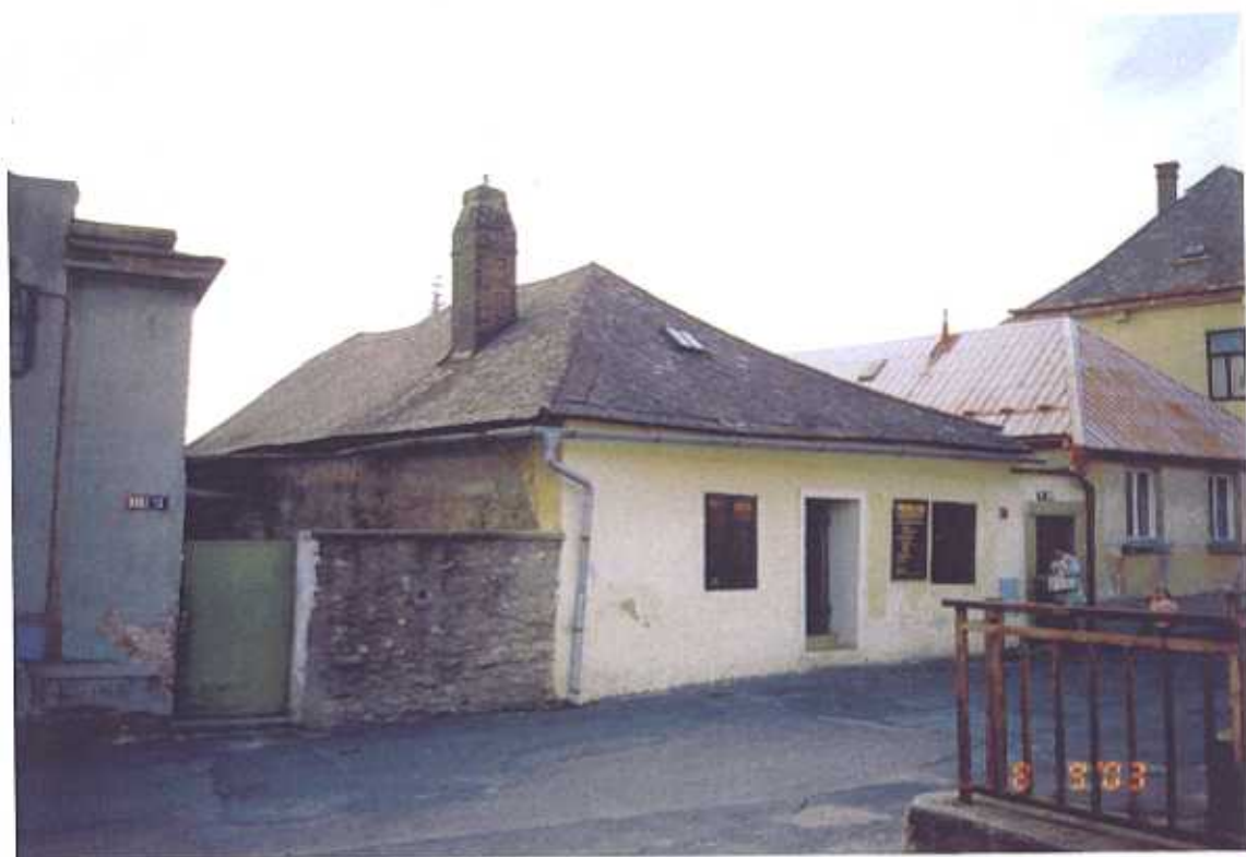
Stav objektu před zahájením obnovy
