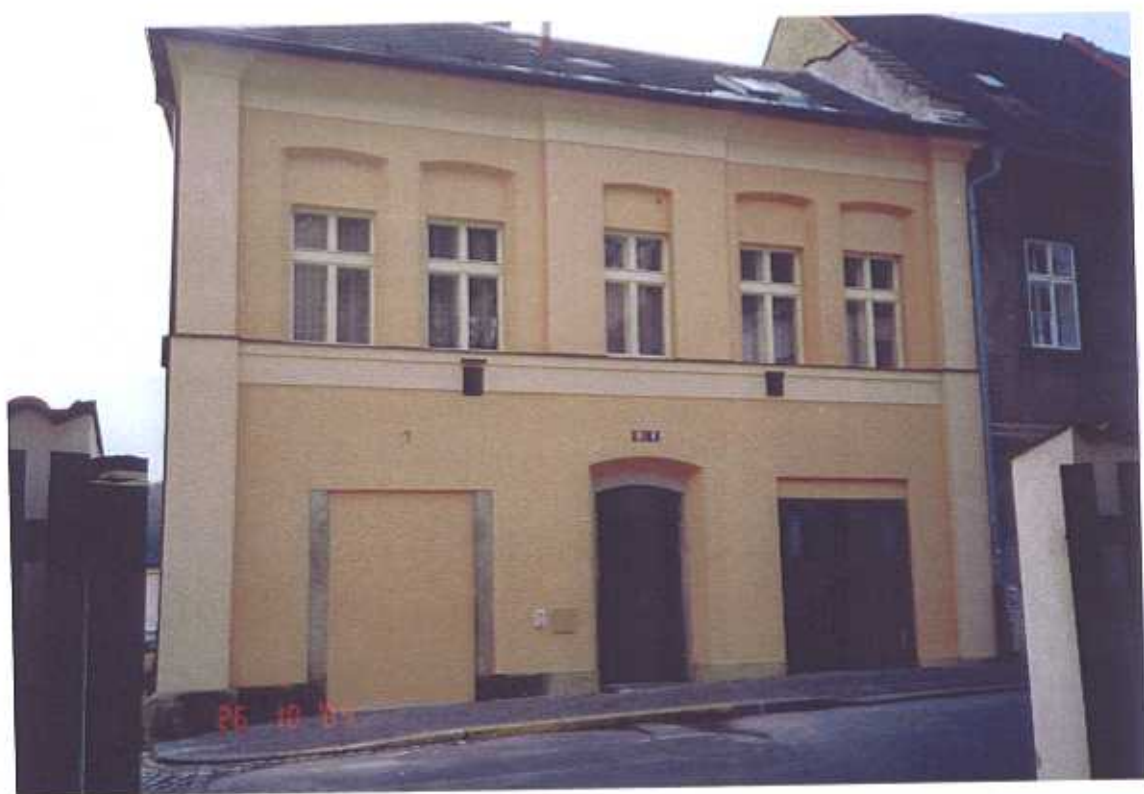
Dům čp. 19 Komenského náměstí, Kutná Hora stav fasád po obnově
