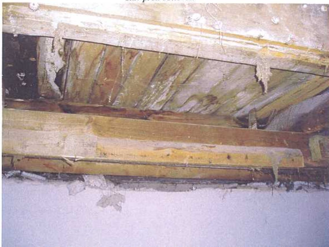
stav před obnovou
