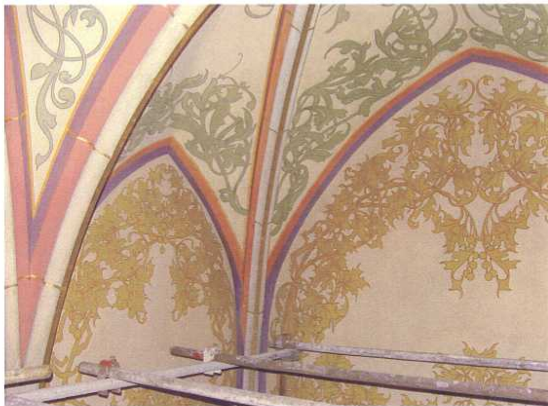
Provedení rekonstrukcí chybějících partií v malbě
