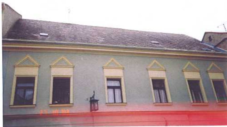
stav střechy před zahájením obnovy
