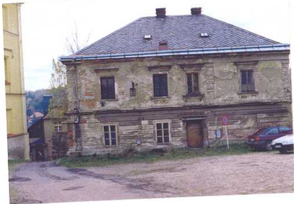
Stav fasády před obnovou.
