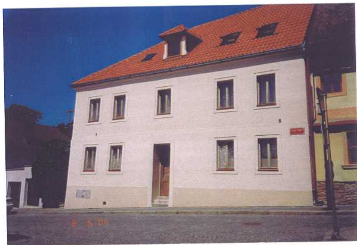
Dům čp. 543 Jánské náměstí, Kutná Hora stav fasád po obnově
