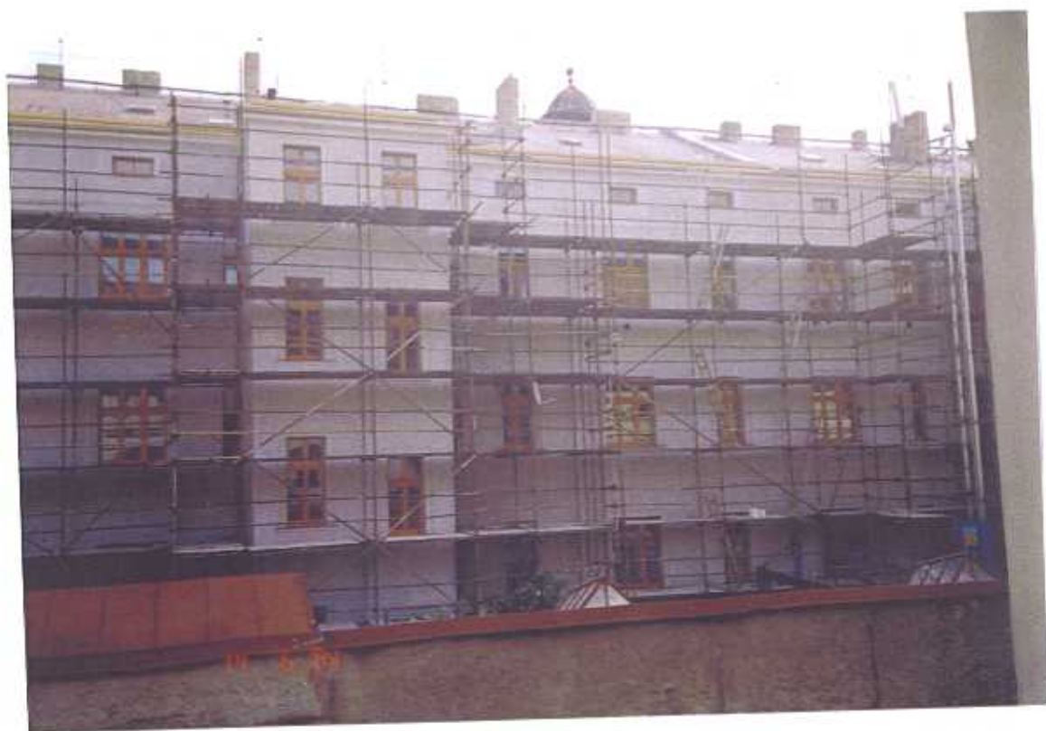
čp. 589, 590 Kollárova ulice, Kutná Hora průběh obnovy
