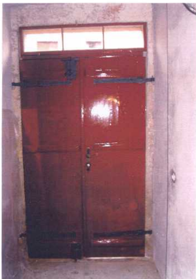
Vstupní dveře Česká ulice čp. 191 stav po restaurování
