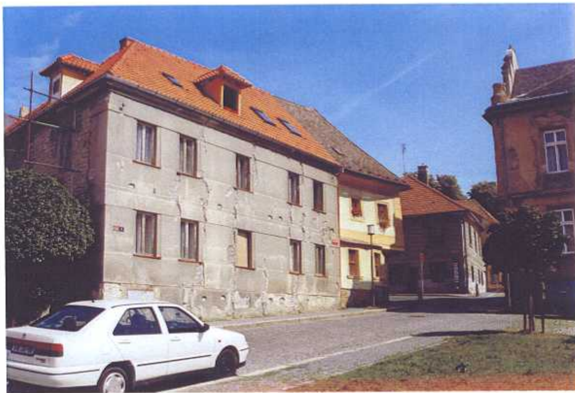
Dům čp. 543 Jánské náměstí, Kutná Hora stav fasád před zahájením obnovy
