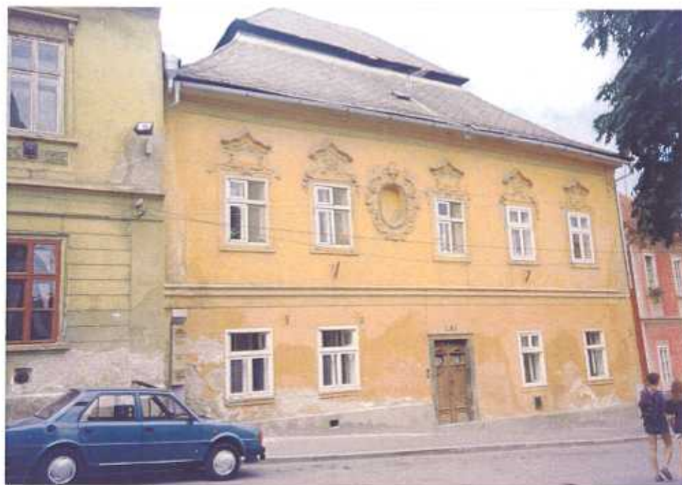
Původní stav objektu
