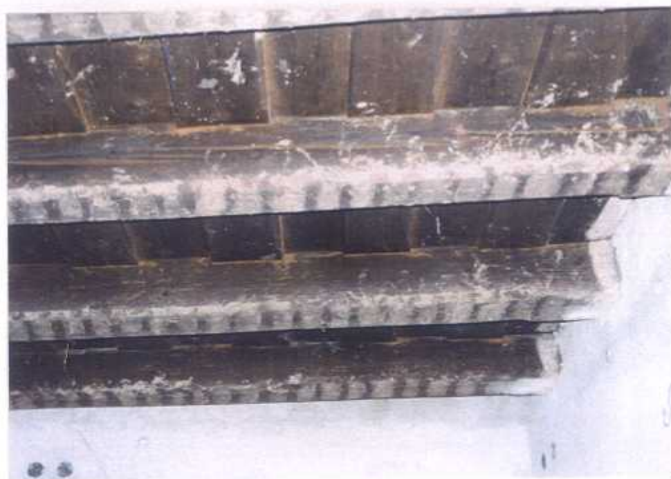
Zákloповý strop po odstranění štukového podhledu – před restaurováním.
