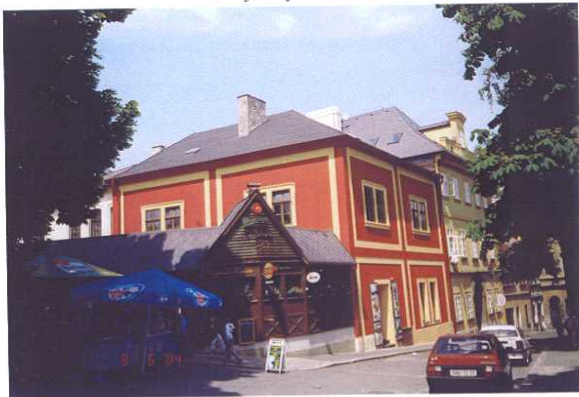
Stav fasád po obnově
