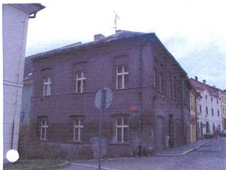
Stav fasád před zahájením obnovy
