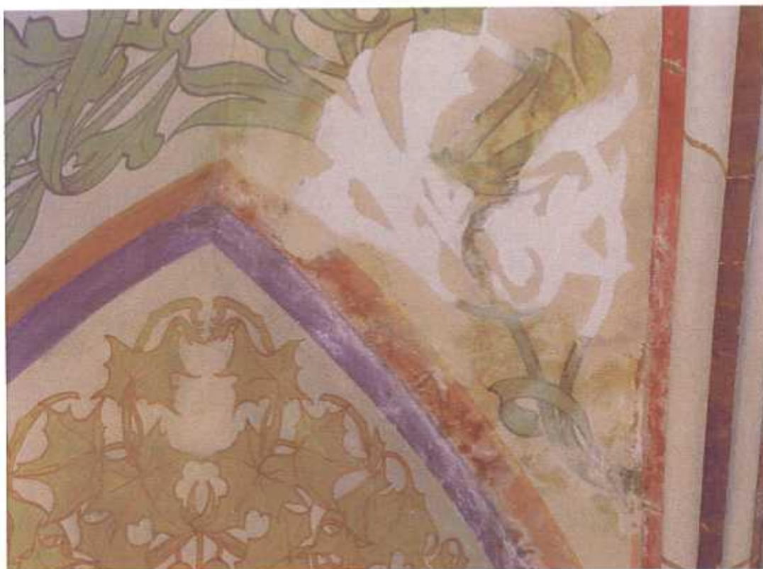
Stav po sejmutí povrchových nečistot, zpevnění barevné vrstvy a hloubkovém zpevnění vrstev omítkových a vytmelení defektů; základní kresebný rozvrh rekonstruovaných partií
