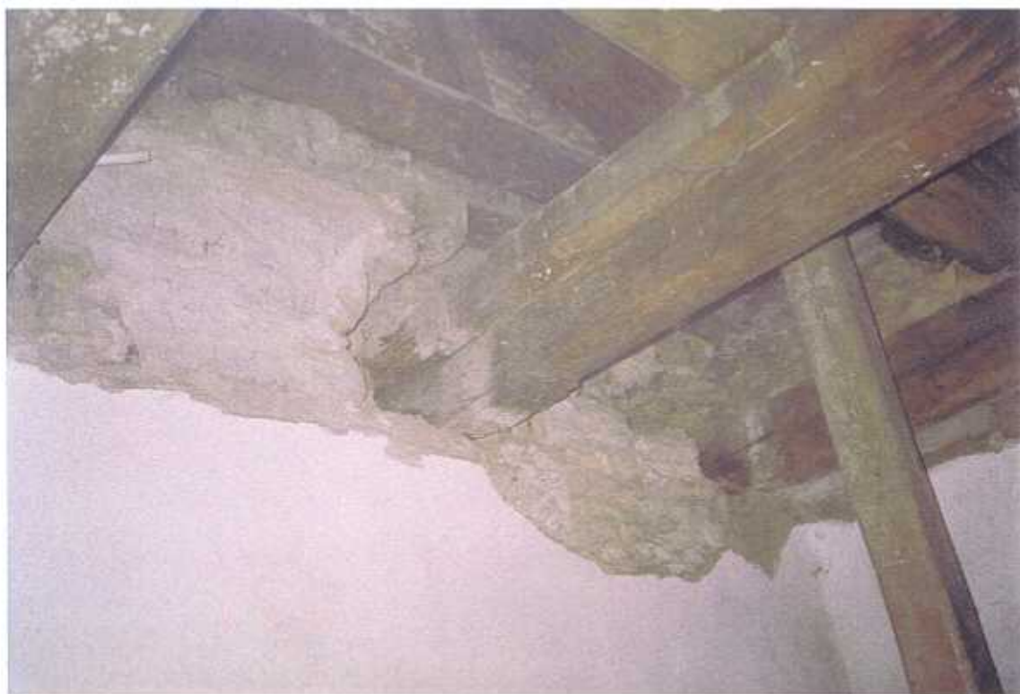
Dům čp. 34 Barborská ulice, Kutná Hora gotický záklopový strop v míst. 2.04 I. patro stav po odkrytí
