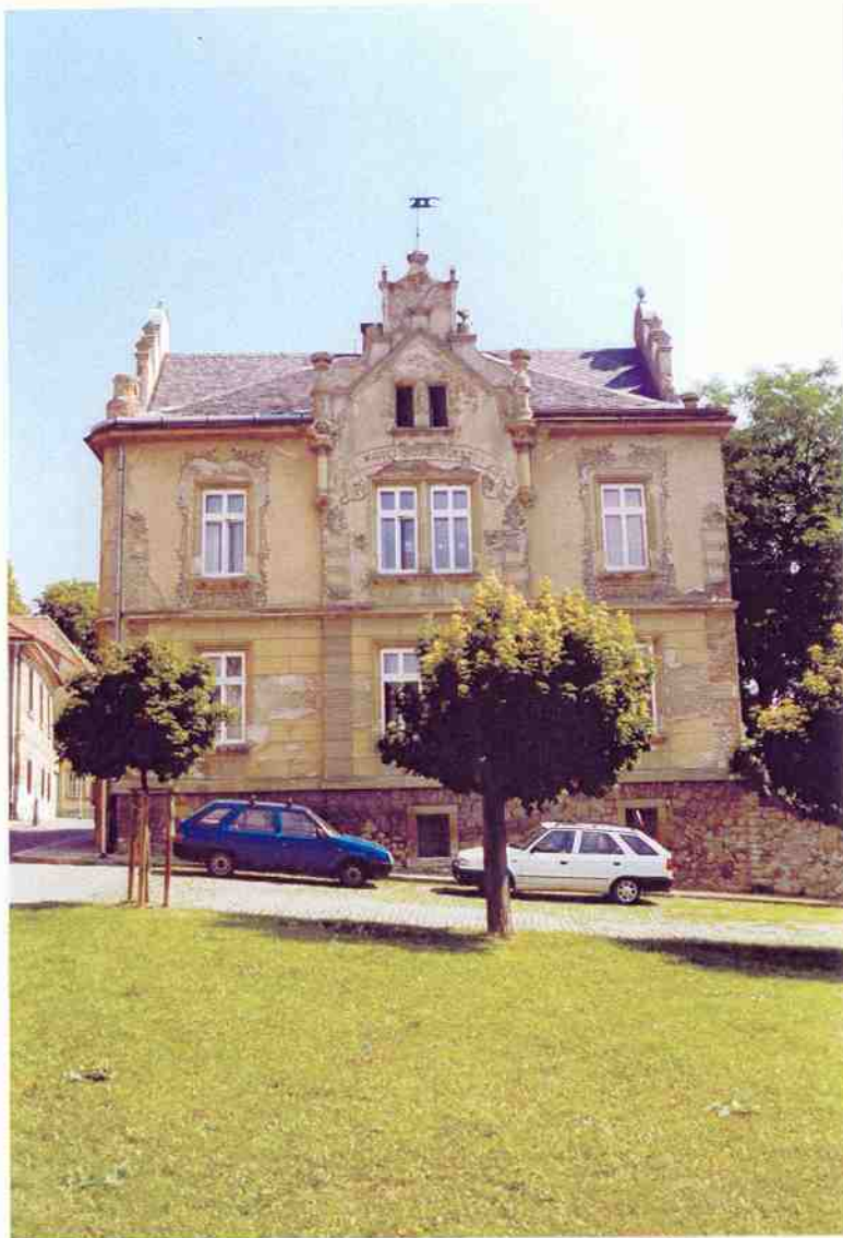
Stav střechy před obnovou
