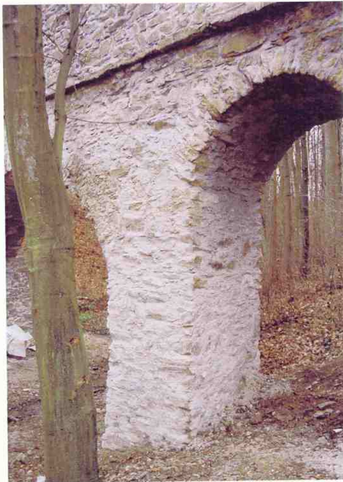
Akvadukt Bylanka Stav po obnově
