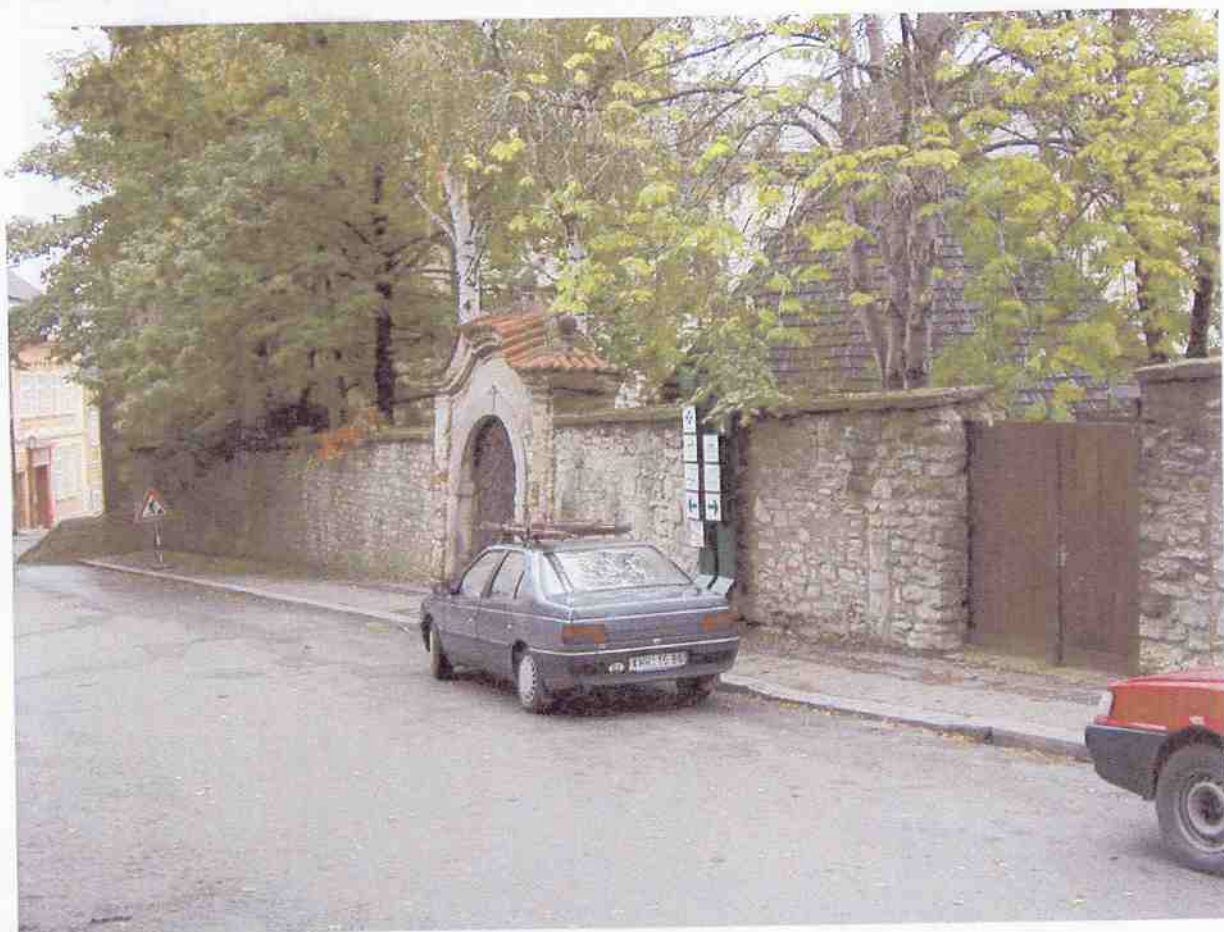
Ohradní zeď u Hrádku, Barborská ulice Stav před zahájením prací
