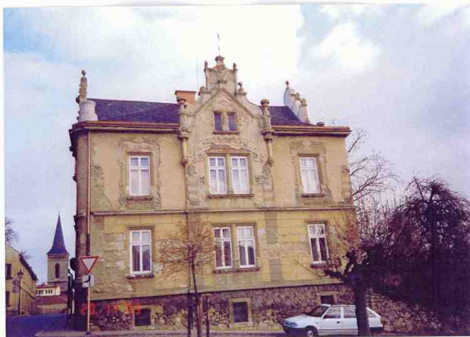
Čp. 521 Jánské náměstí Stav střechy po obnově
