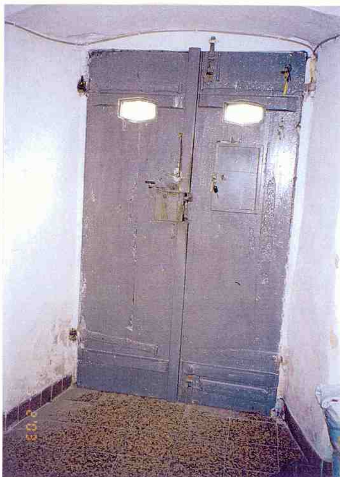
Havlíčkovo náměstí čp. 520, Kutná Hora Vnitřní strana dveří před restaurováním
