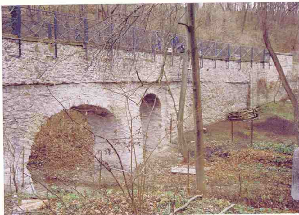
Akvadukt Bylanka Stav po obnově
