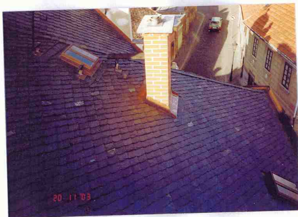
Čp. 521 Jánské náměstí Stav střechy po obnově
