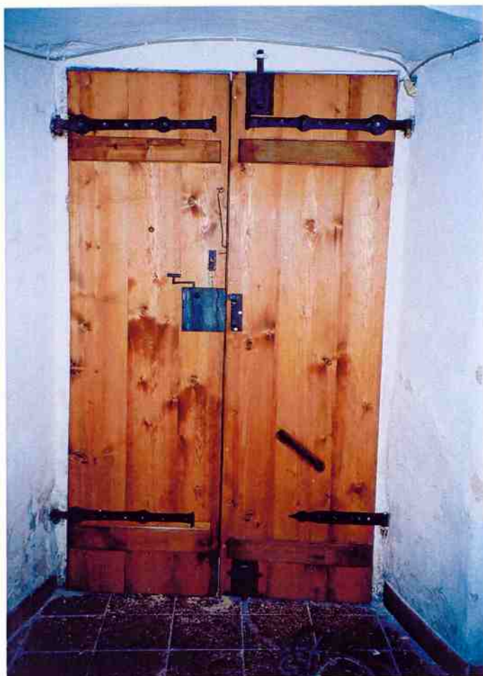
Havlíčkovo náměstí čp. 520, Kutná Hora Vnitřní strana dveří po restaurování
