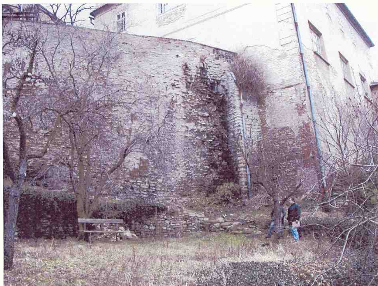
Stav zdi před obnovou
