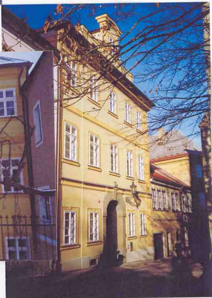
Čp. 30 Barborská ulice Stav čelní a dvorní fasády po obnově
