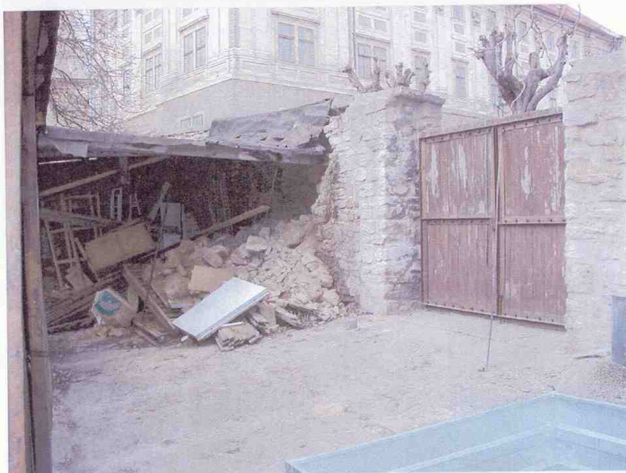
Ohradní zeď u Hrádku, Barborská ulice Stav před zahájením prací
