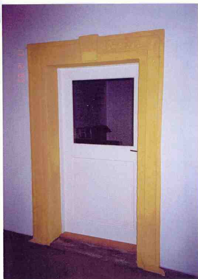
Čp. 30 Barborská ulice Stav před obnovou a po obnově
