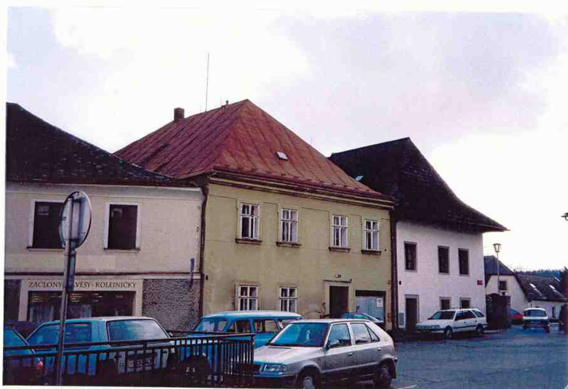
Čp. 369 Anenské náměstí Stav objektu před zahájením obnovy
