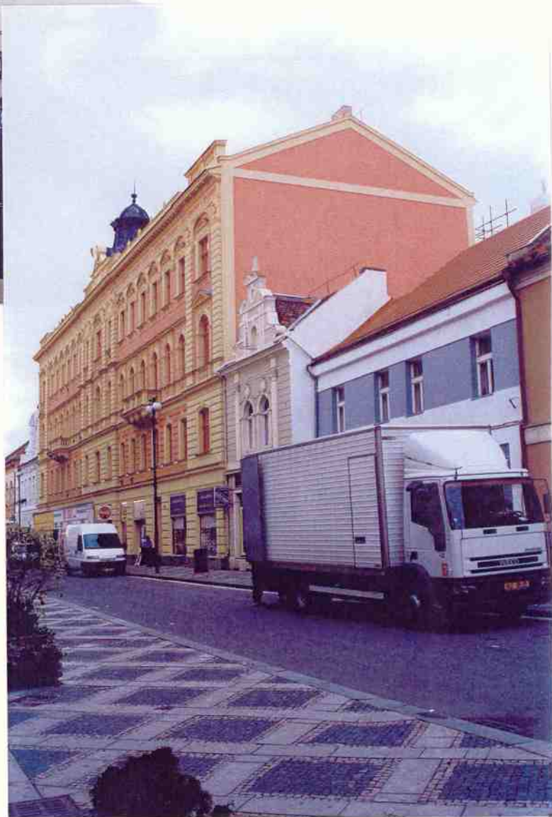
Čp. 589, 590 Kollárova ulice Průběh obnovy a stav po obnově
