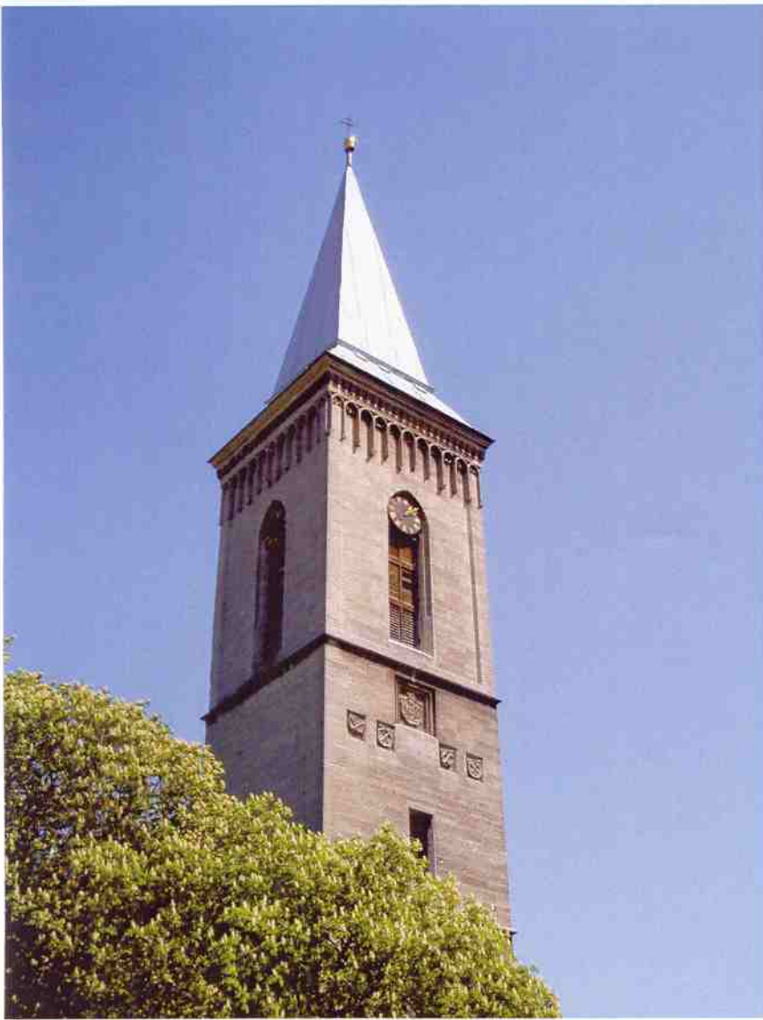
Stav před obnovením
