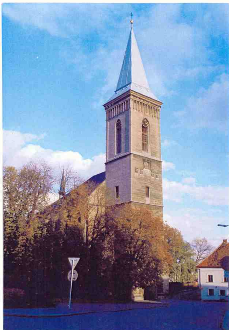
Kostel Matky Boží Na náměti Stav střechy před obnovou
