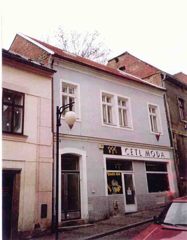
ČP. 588, TYLOVA ULICE STAV PŘED A PO OBNOVĚ STŘECHY
