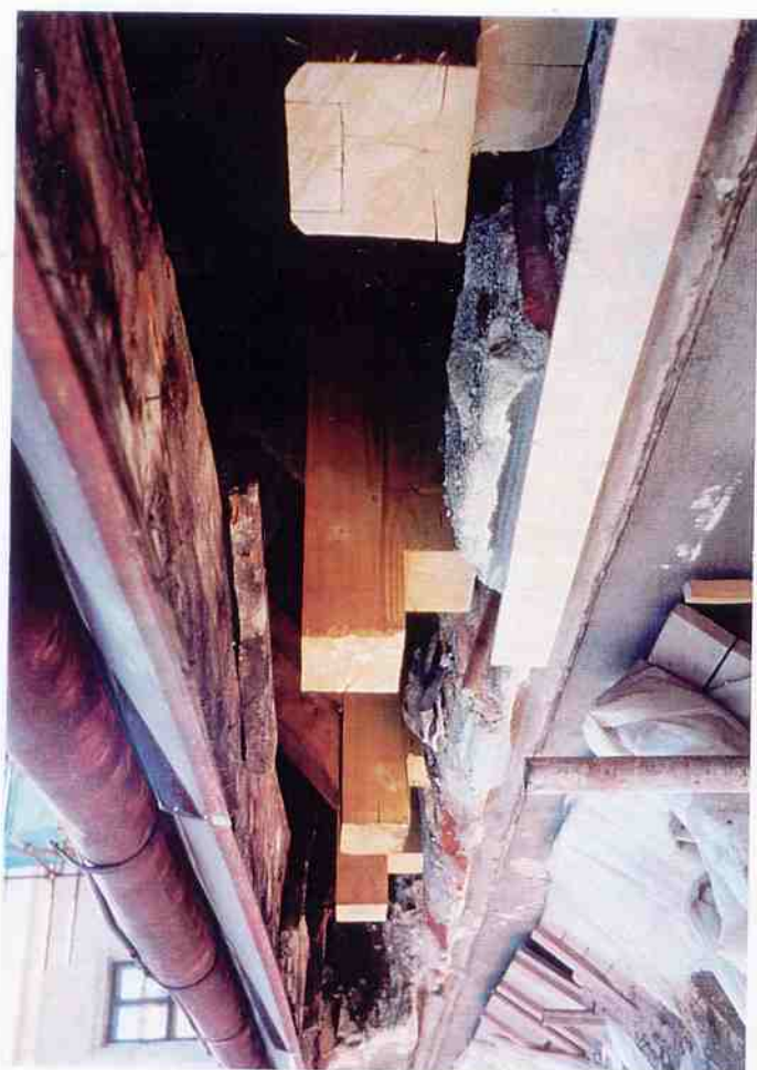
ČP. 30, BARBORSKÁ ULICE KROKVE, VAZNÉ TRÁMY A HLAVNÍ ŘÍMSA PŘED A PO OBNOVĚ
