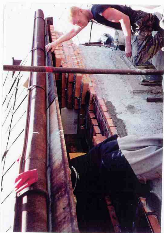
ČP. 30, BARBORSKÁ ULICE KROKVE, VAZNÉ TRÁMY A HLAVNÍ ŘÍMSA PŘED A PO OBNOVĚ
