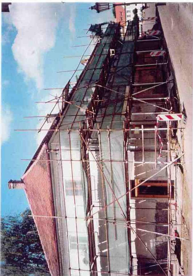
ČP. 471, JUNGMANNOVO NÁNĚSTÍ STAV PŘED A BĚHEM STATICKÉHO ZAJIŠTĚNÍ A OBNOVY PLÁŠTĚ
