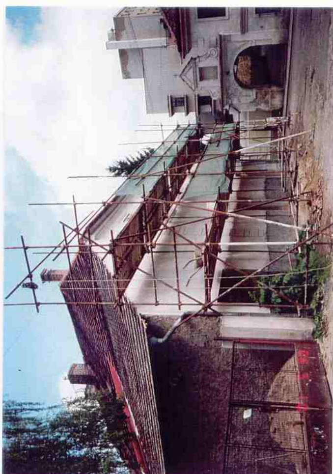
ČP. 471, JUNGMANNOVO NÁNĚSTÍ STAV PŘED A BĚHEM STATICKÉHO ZAJIŠTĚNÍ A OBNOVY PLÁŠTĚ
