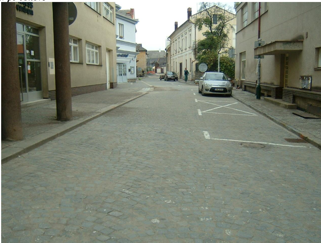
Stav po obnově
