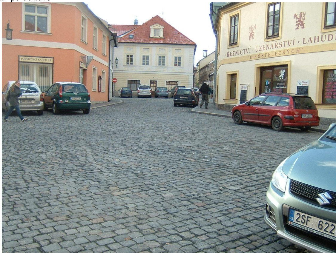
Stav po obnově
