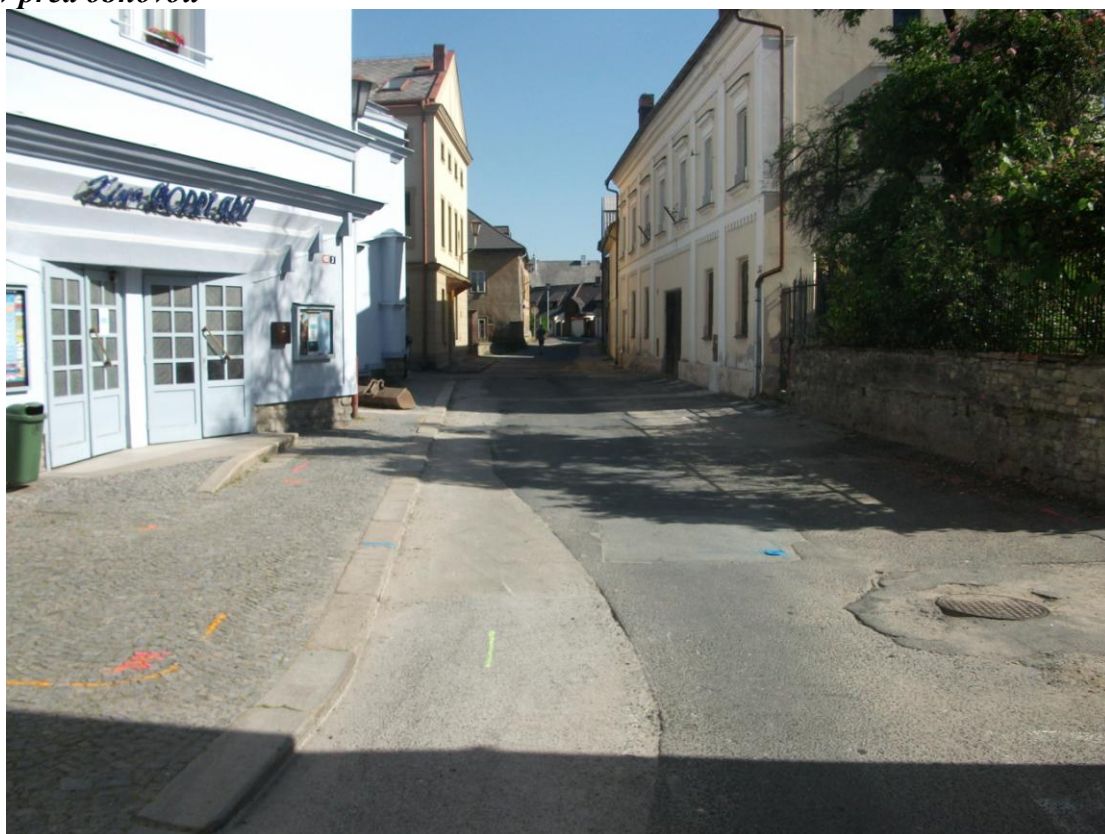
Stav před obnovou
