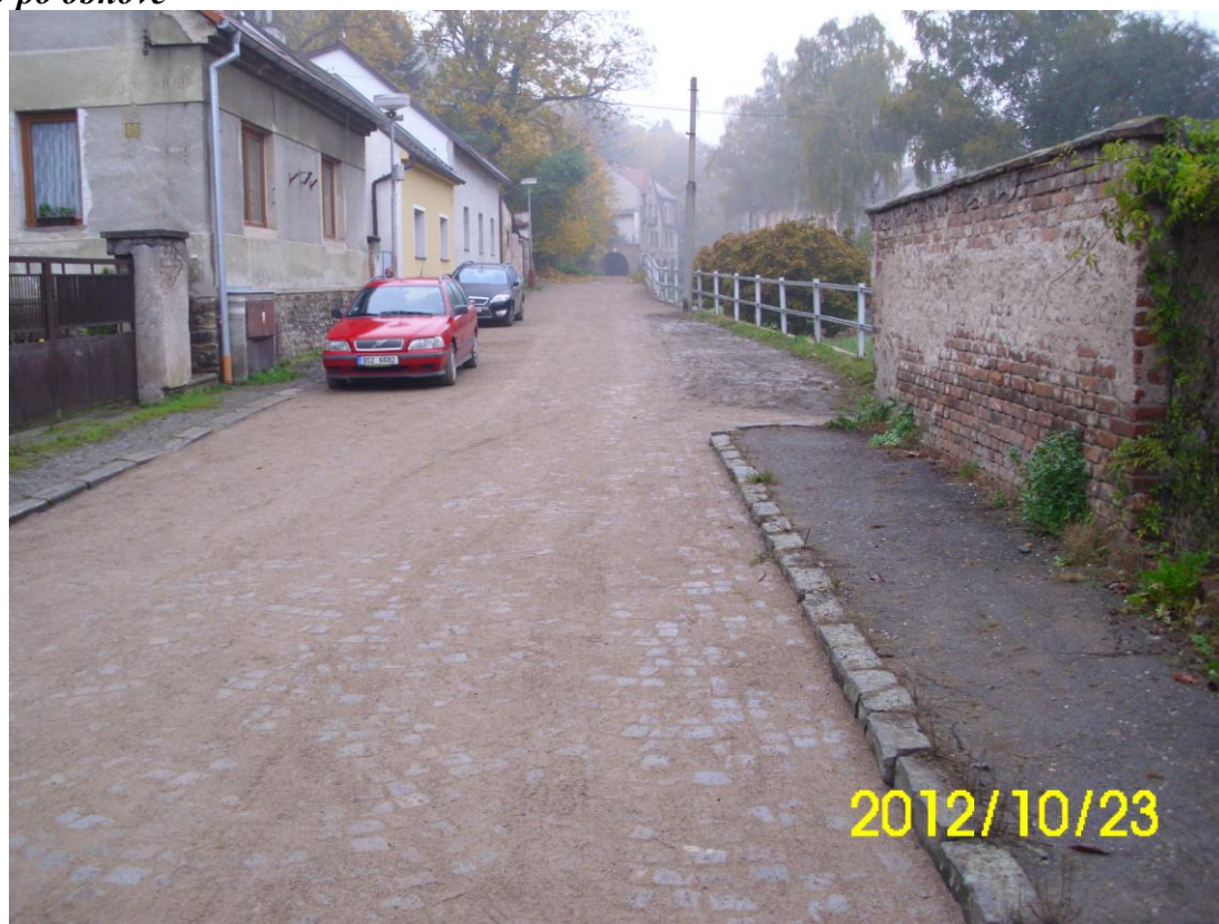
Stav po obnově
