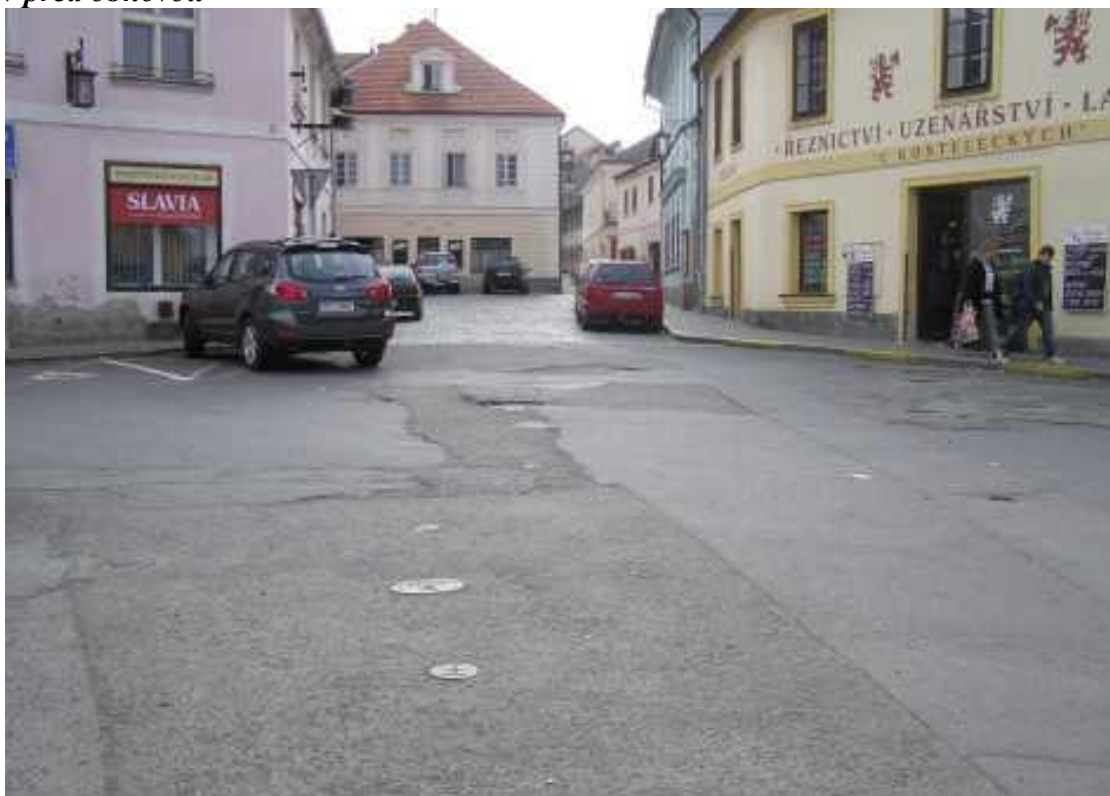
Stav před obnovou
