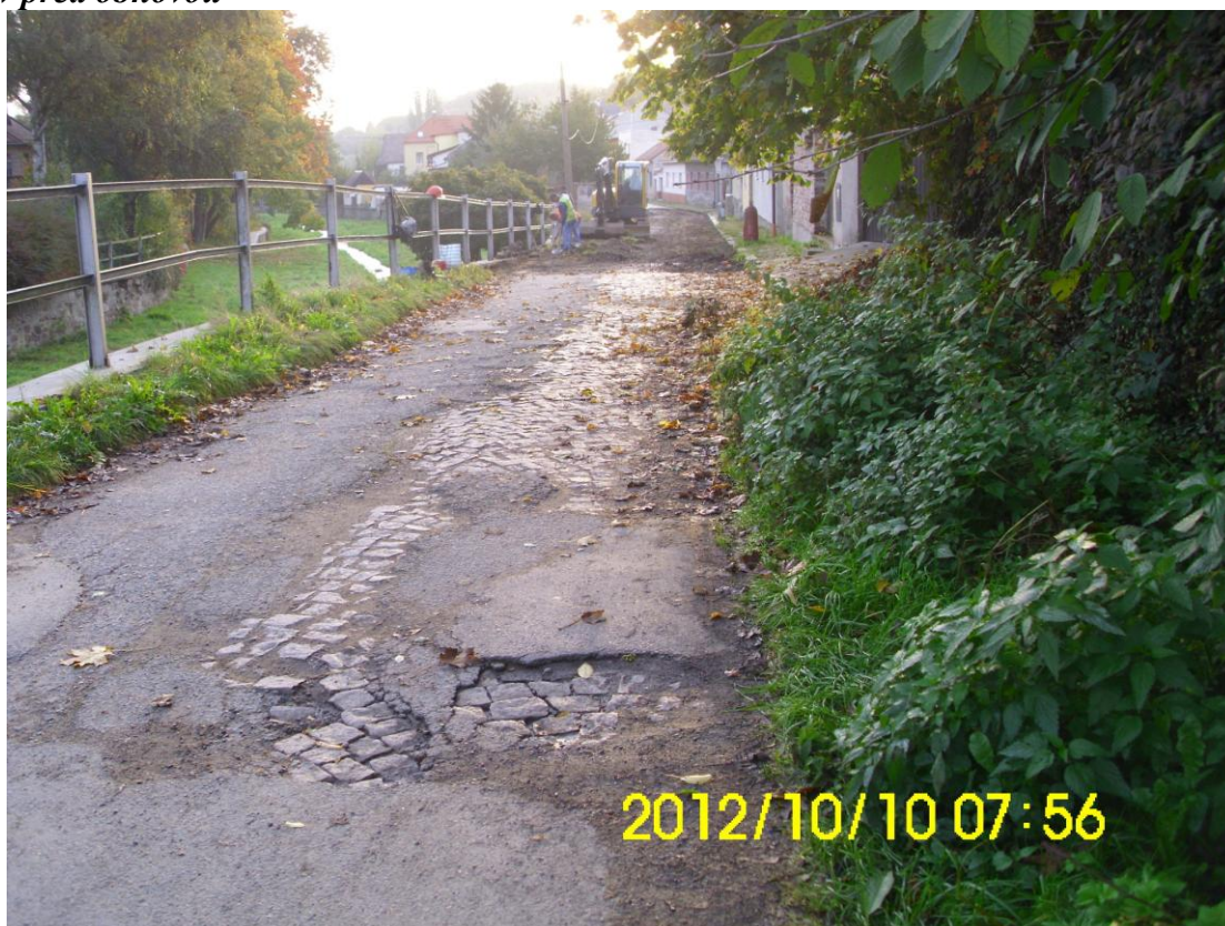
Stav před obnovou
