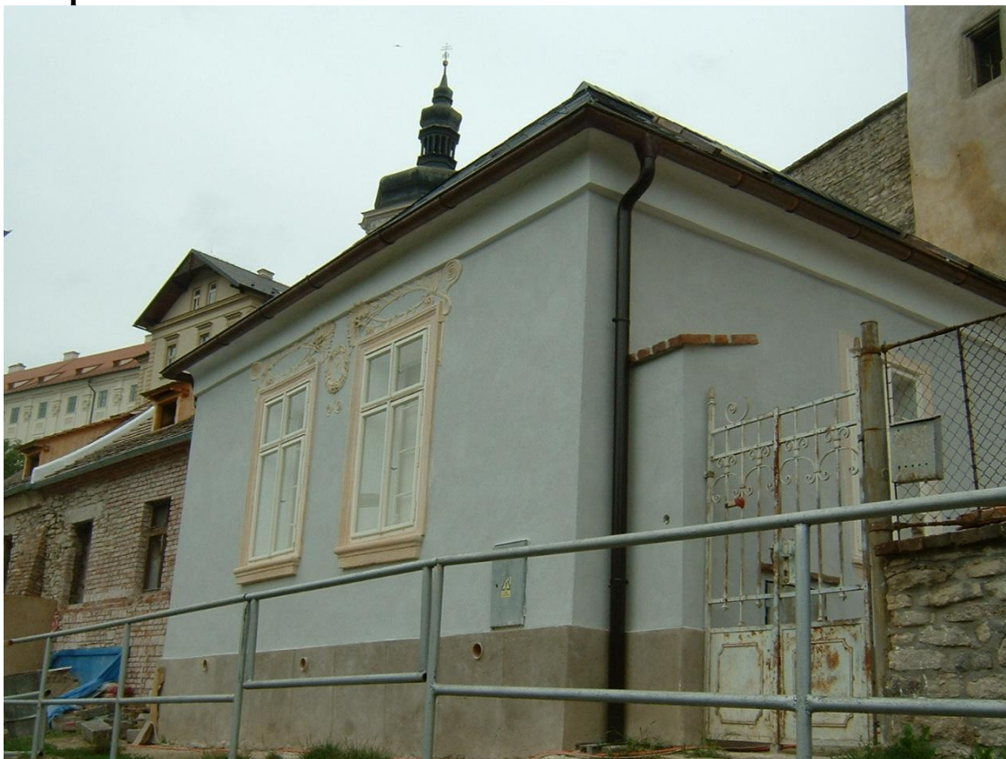
Dům č.p. 43 Pod Hrádkem
