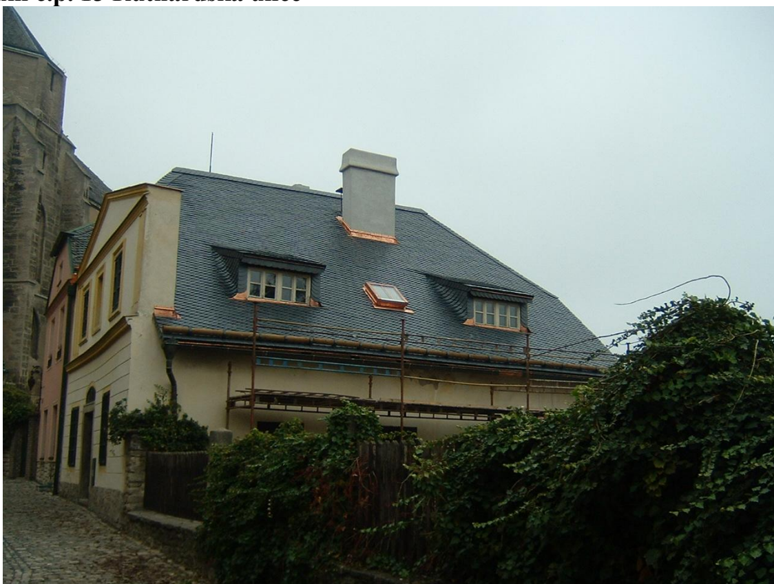
Dům č.p. 13 Ruthardská ulice
