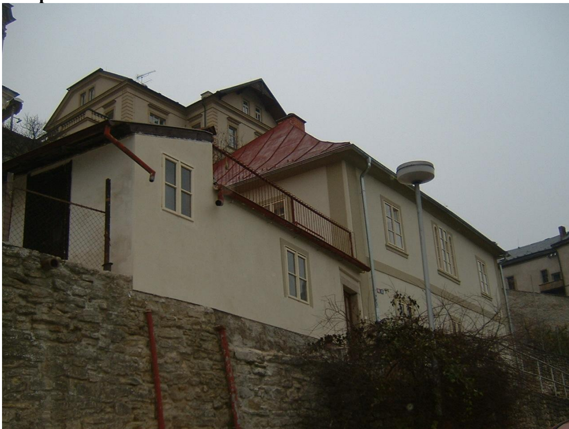
Dům č.p. 40 Pod Hrádkem
