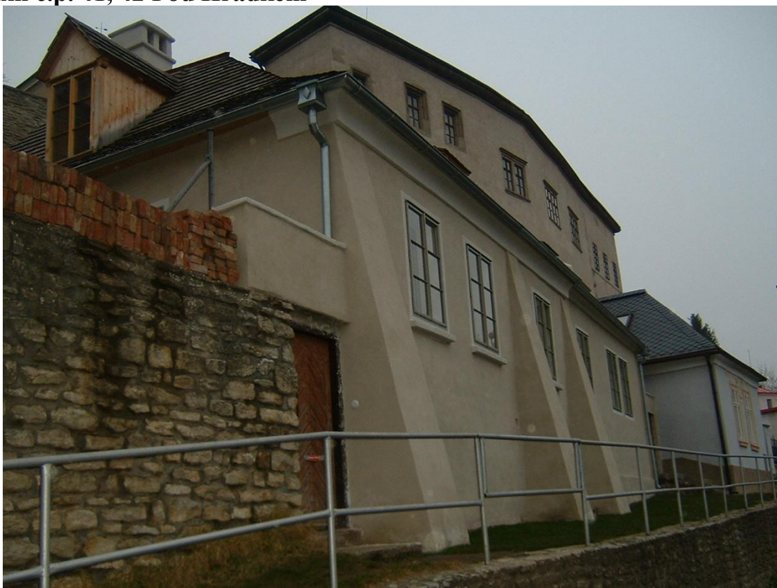
Dům č.p. 41, 42 Pod Hrádkem
