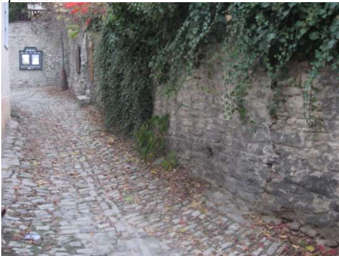
Stav před obnovou
