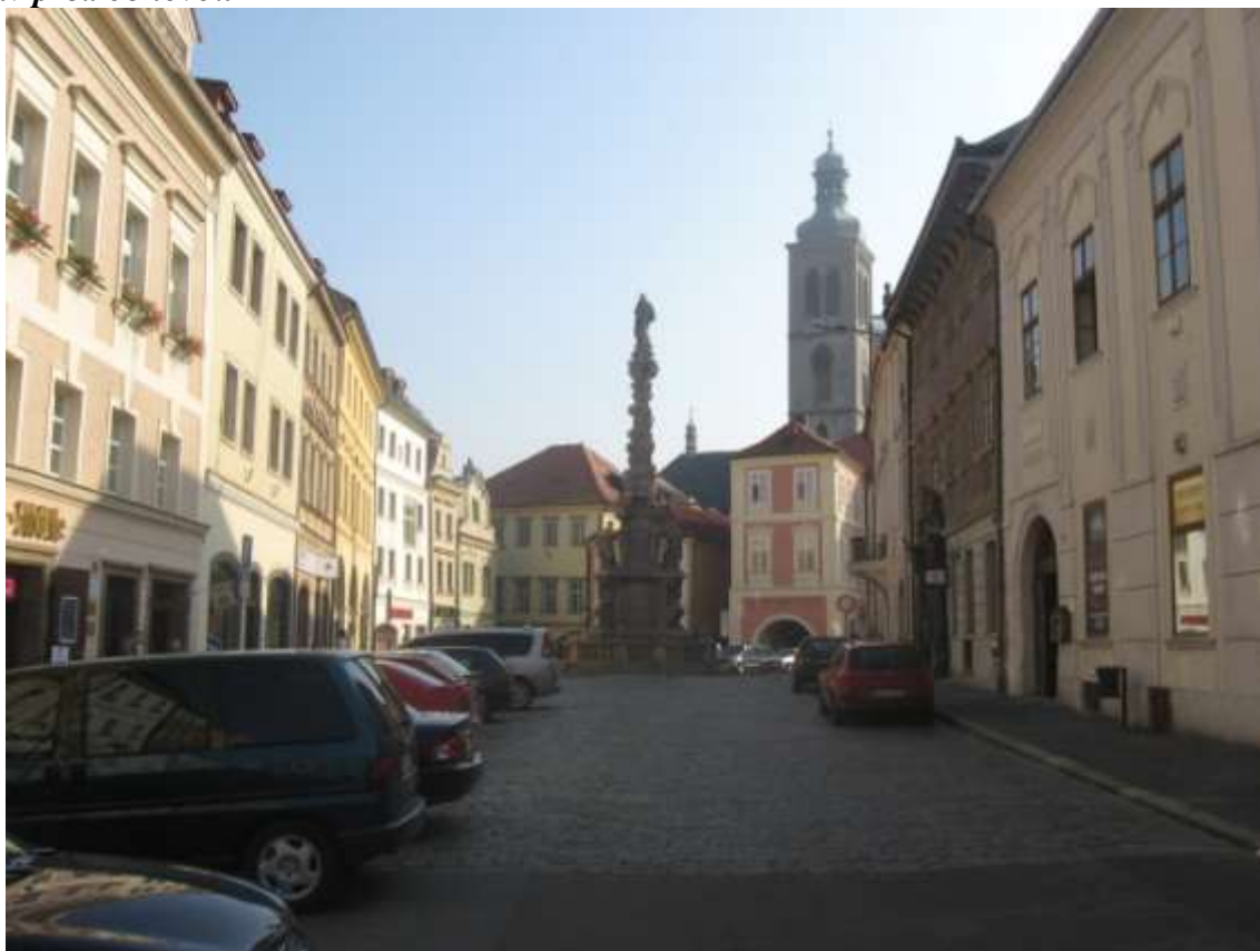
Stav před obnovou
