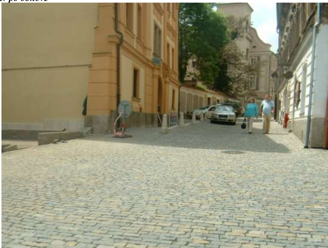
Stav po obnově
